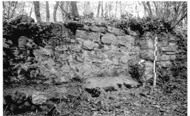
Fig. 16 : Esenköy, “site byzantin”, mur périmétrique, section 1, semelle.
