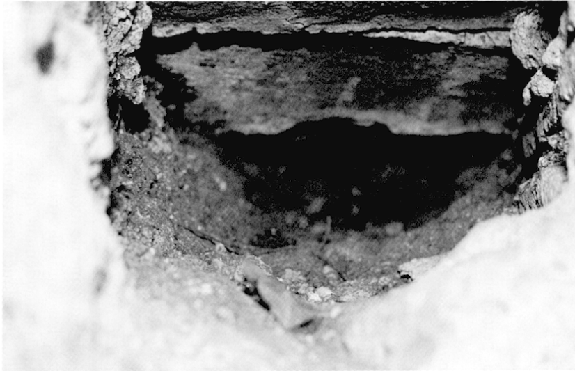
Fig. 20: Esenköy, “site byzantin”, structure à “l’abside”, “abside”, trou dans le recessed brick work , intérieur du conduit.
