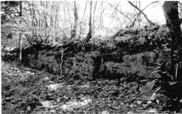
Fig. 15 : Esenköy, “site byzantin”, mur périmétrique, section 1.
