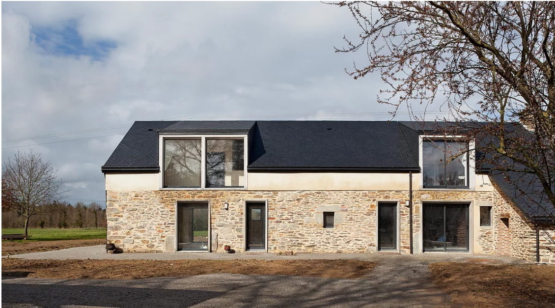
Réhabilitation d'une logère en logement : la longère Brus, Bretagne. [Atelier 56S]. Source : Atelier 56S.
