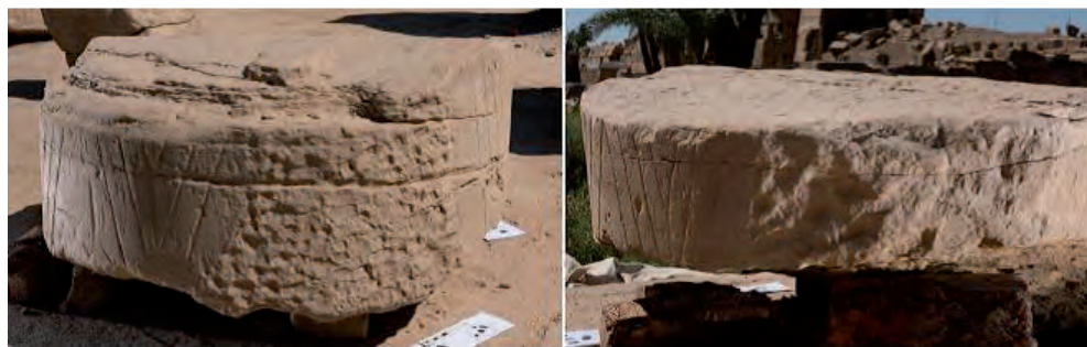
FIG. 16. BASE DE LA COLONNE B (BLOC N° 3) AVEC LES TRACES D'UN MURET (GAUCHE) ET D'UNE POSSIBLE PORTE (DROIT) (© CNRS-CFEETK/E. SAUBESTRE)
