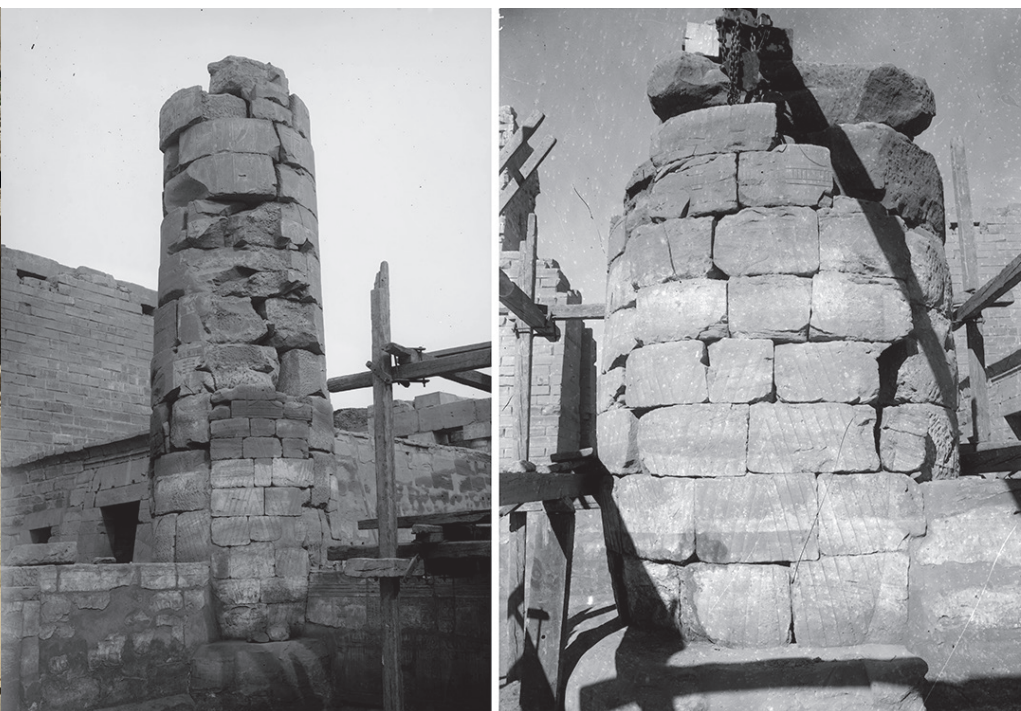
Fig. 7 Restaurations antiques des colonnes V' (gauche) et IV' (droite) du kiosque de Taharqa (photos n°s 96410 et 96399 CFEETK/fonds H. Chevrier).
