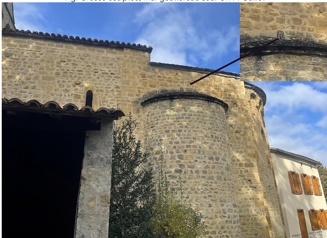
Fig. Crosse sculptée, mur gouttereau sud. Cr. F. Guillot
