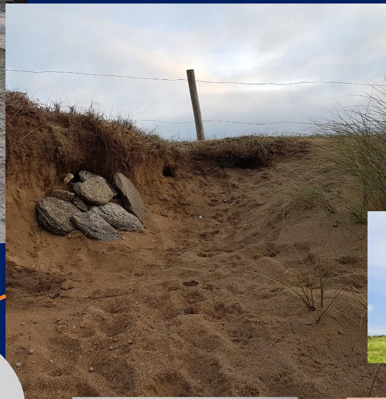
Constats sur le terrain
