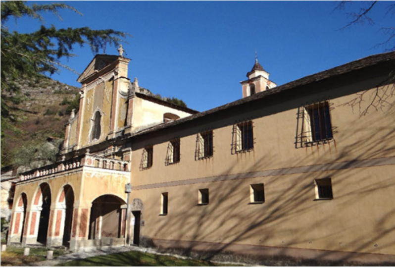
Fig. 2. Façade de l'ancien couvent des franciscains de Saorge (06) (CC)
