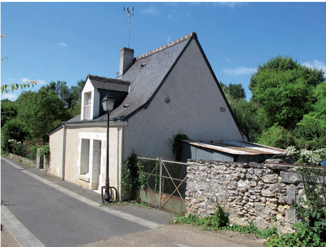
Figure 167. DE 5156. Vue depuis le nord est. Cliché J.-Ph. Chimier, 2016.
