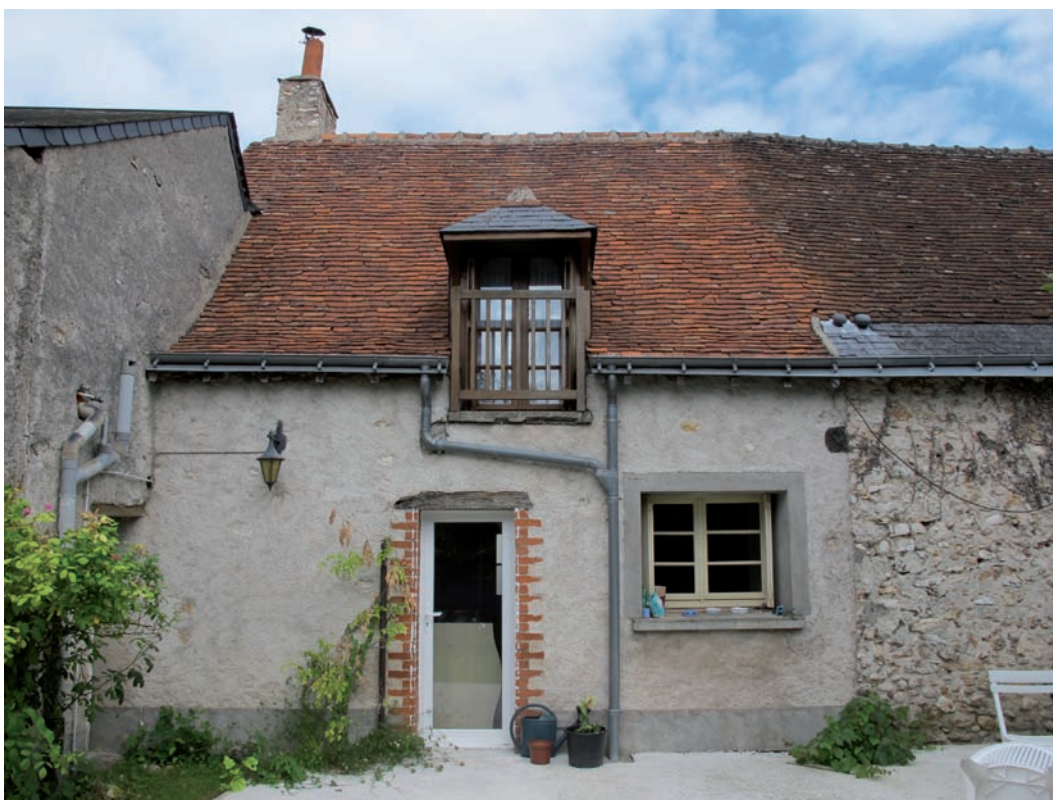
Figure 104. Vue du mur gouttereau ouest depuis le jardin. Cliché J.-Ph. Chimier, 2016.
