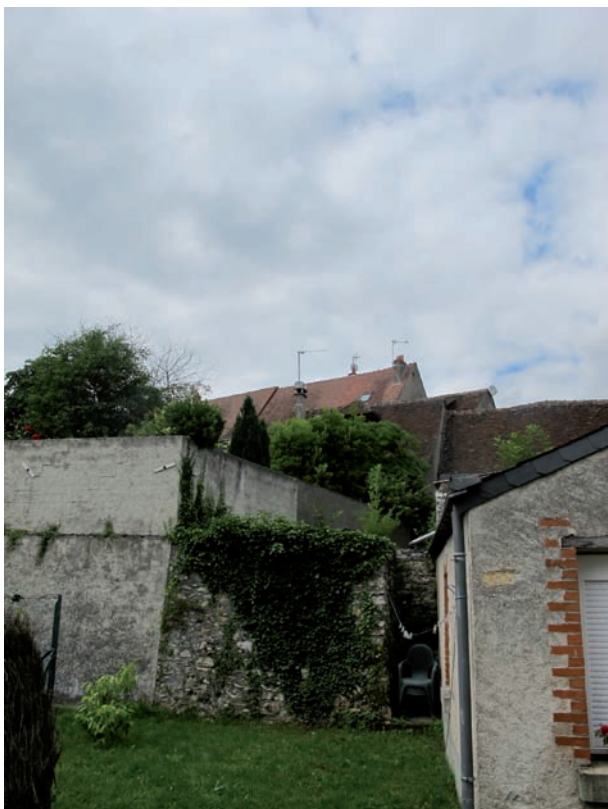
Figure 96. DE 5224. Vue du mur de terrasse depuis le jardin de DE 5223. Cliché J.-Ph. Chimier, 2016.
