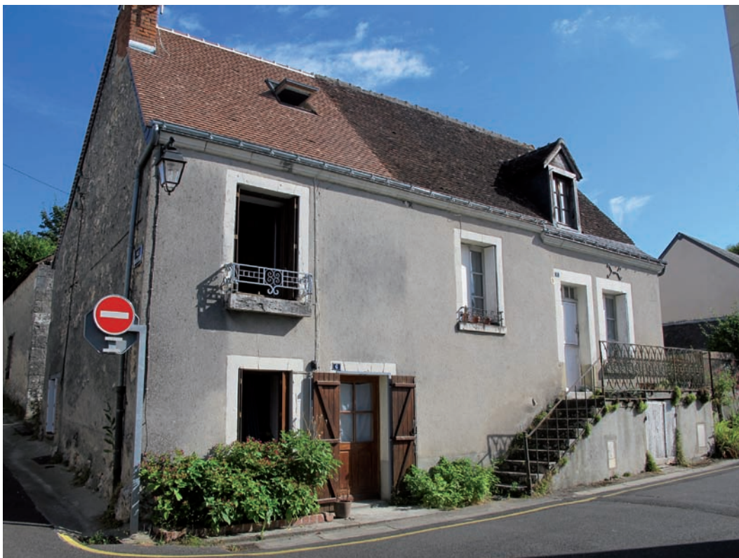
Figure 150. DE 5318. Façades des DE 5377 à gauche et 5318 à droite. Cliché J.-Ph. Chimier, 2016.
