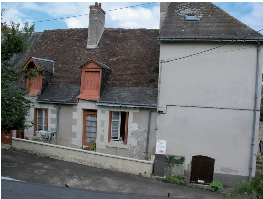
Figure 85. DE 5345. Vue des murs gouttereaux ouest des DE 5218, 5345 et 5217. Cliché J.-Ph. Chimier, 2016.
