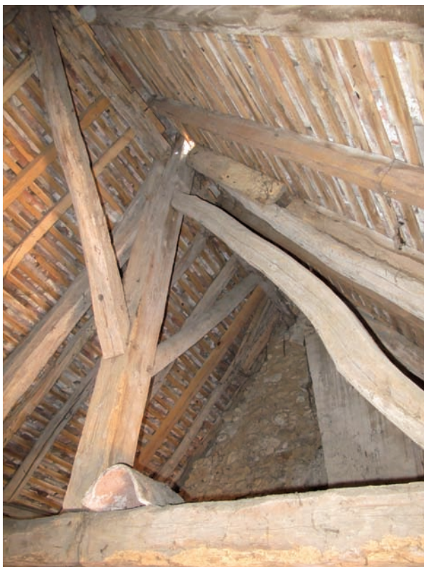
Figure 88. DE 5345. Détail de la charpente depuis le nord-ouest. Cliché J.-Ph. Chimier, 2016.
