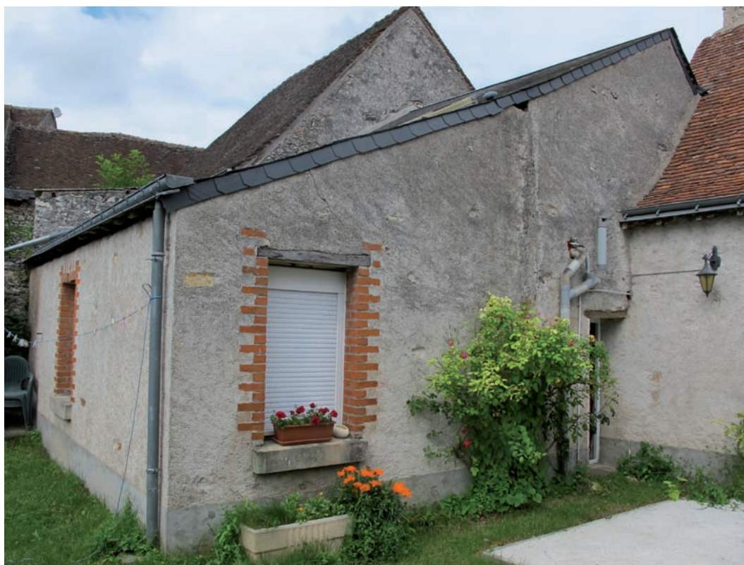
Figure 101. DE 5062. Vue générale de l'extension 5062 et du mur pignon sud de DE 5223 depuis le jardin. Cliché J.-Ph. Chimier, 2016.
