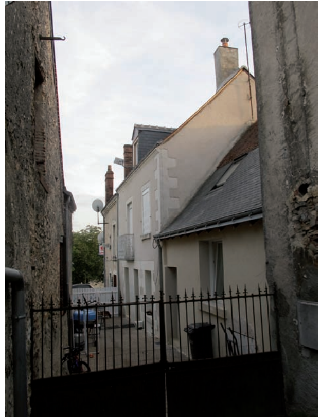
Figure 128. Vue de l'ensemble du groupe BA_2 depuis le nord. Au premier plan le DE 5312. Cliché J-Ph. Chimier, 2016.
