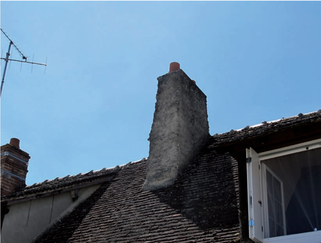
Figure 113. DE 5306. Détail de la souche de cheminée. Cliché J.-Ph. Chimier, 2016.
