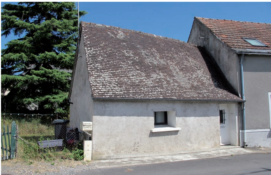
Figure 158. DE 5162 vu du nord ouest. Vue depuis le sud. Cliché J.-Ph. Chimier, 2016.
