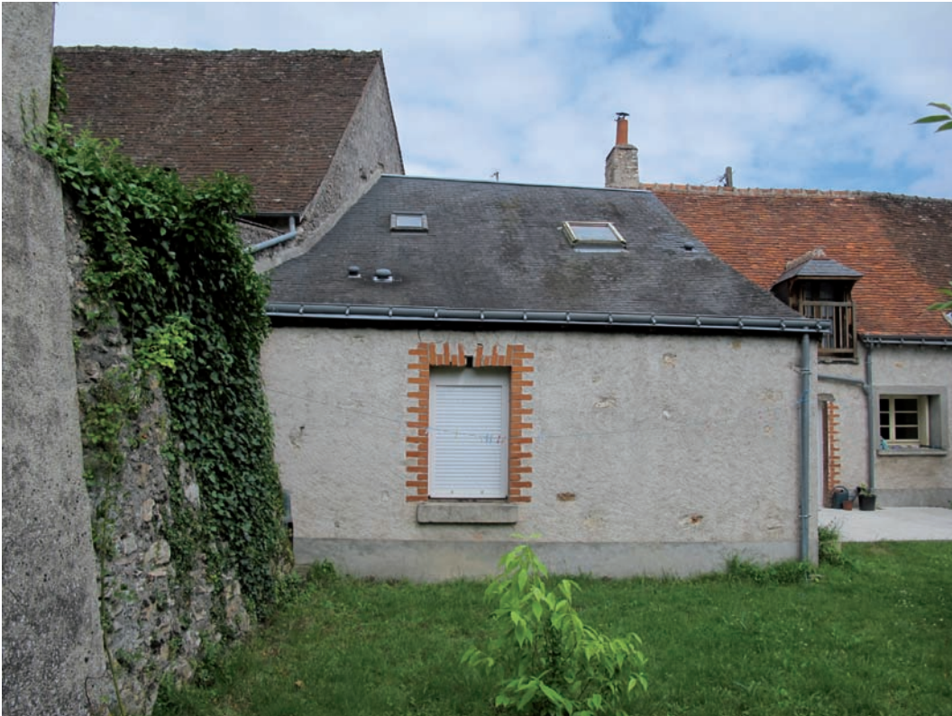
Figure 102. DE 5062. Vue de la façade ouest. Cliché J.-Ph. Chimier, 2016.
