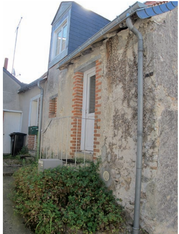
Figure 147. DE 5377. Le gouttereau sud. Cliché J.-Ph. Chimier, 2016.
