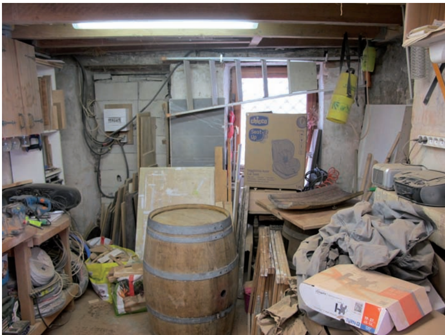
Figure 133. DE 5232. La porte et la fenêtre du gouttereau sud ouest. Cliché J.-Ph. Chimier, 2016.
