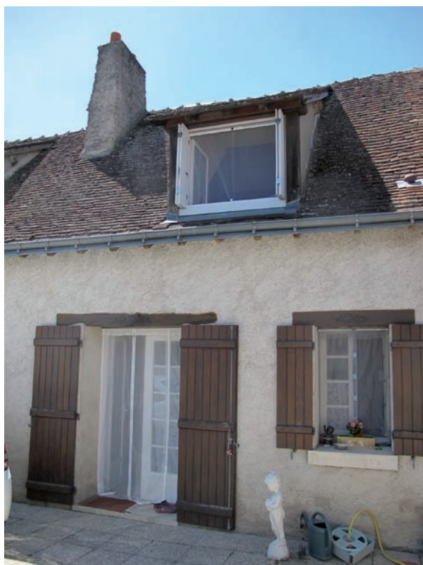
Figure 111. DE 5306. Le mur gouttereau est vu depuis la cour du bâtiment. Cliché J.-Ph. Chimier, 2016.
