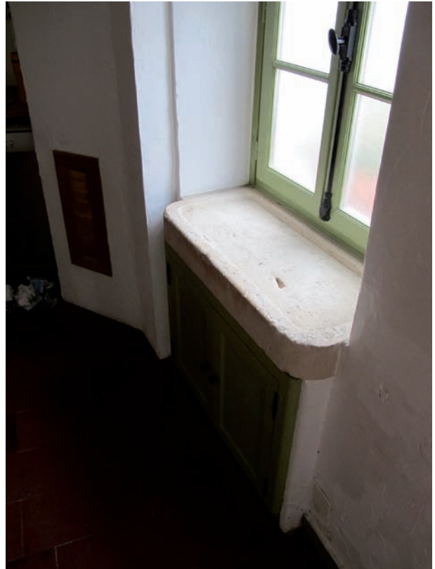
Figure 99. DE 5223. Détail de la pierre d'évier. Cliché J.-Ph. Chimier, 2016.
