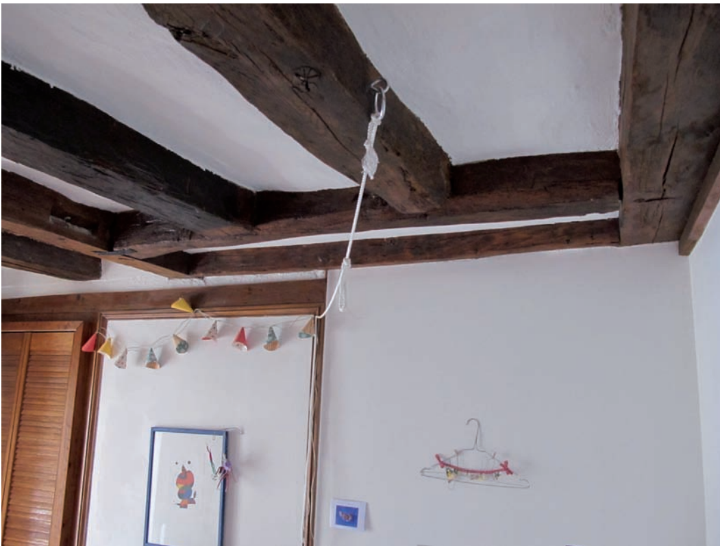
Figure 148. DE 5377. Les solives du 2 e niveau et la trémie de l'ancien coffre de cheminée. Cliché J.-Ph. Chimier, 2016.
