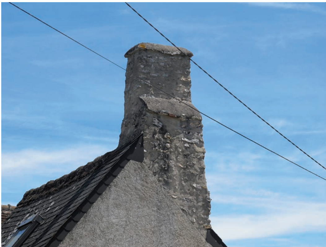
Figure 135. DE 5232. Détail de la souche de cheminée. Cliché J.-Ph. Chimier, 2016.
