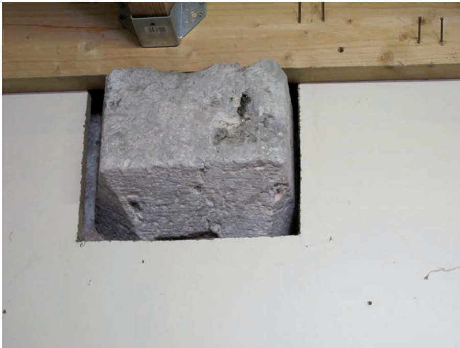
Figure 125. DE 5208. Détail de la console sud du faux manteau de la cheminée. Cliché J.-Ph. Chimier, 2016.
