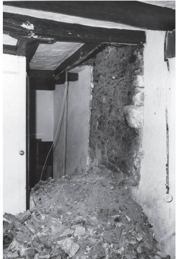
Figure 165. DE 5103. La console de l'état ancien de la cheminée. Collection particulière, cliché Azo.
