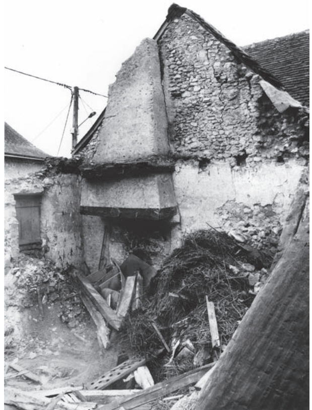
Figure 166. Maison en cours de destruction quartier Saint-Médard. Collection particulière, cliché Azo.
