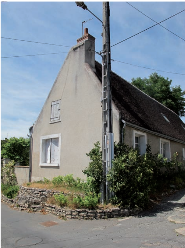
Figure 157. La souche de cheminée du DE 5262. Vue depuis le sud. Cliché J.-Ph. Chimier, 2016.
