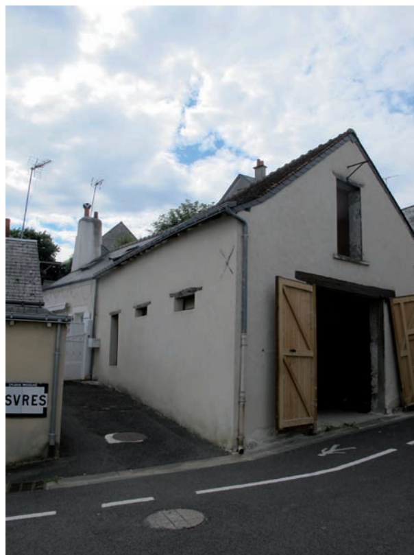
Figure 123. DE 5208. Vue générale du bâtiment depuis le sud-est. Cliché J.-Ph. Chimier, 2016.
