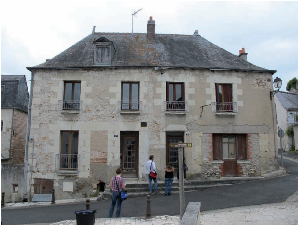
Figure 174. DE 5148. Vue de la façade est du bâtiment. La partie sud, à gauche, est un ajout postérieur au cadastre de 1823. Cliché J.-Ph. Chimier, 2016.
