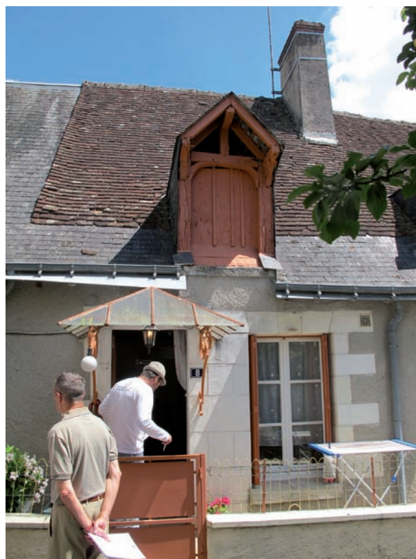
Figure 81. DE 5218. Vue du mur gouttereau ouest du bâtiment 5218. Cliché J.-Ph. Chimier, 2016.
