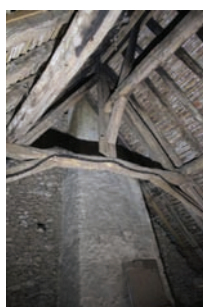
2e ferme principale depuis le sud au niveau du faux-entrait
