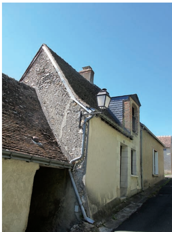
Figure 160. Les DE 5109, rue château. Vue depuis le sud. Cliché J.-Ph. Chimier, 2016.
