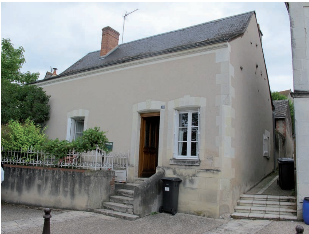
Figure 154. Façade sud de DE 5254. Cliché J.-Ph. Chimier, 2016.
