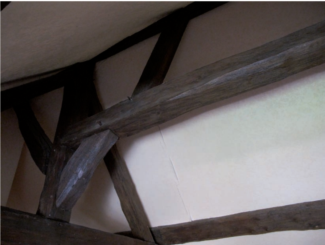
Figure 114. DE 5306. Détail de la charpente vu depuis le nord-est. Cliché J.-Ph. Chimier, 2016.
