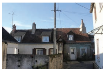
2-4 impasse du Marché Façades est
