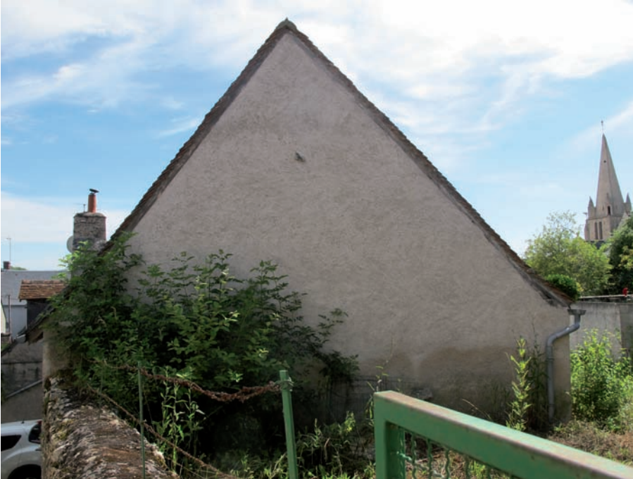
Figure 94. DE 5224. Vue du mur pignon nord. Cliché J.-Ph. Chimier, 2016.
