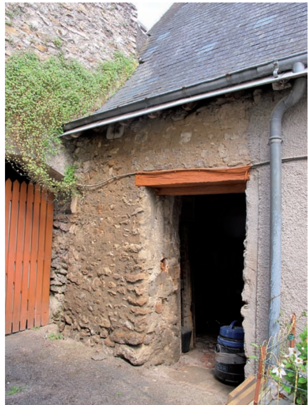
Figure 76. DE 5219. Vue du mur gouttereau ouest du bâtiment DE 5219. Cliché J.-Ph. Chimier, 2016.
