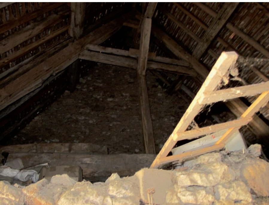
Figure 95. DE 5224. Vue de la charpente et du mur pignon sud en arrière plan. Chimier, 2016.
