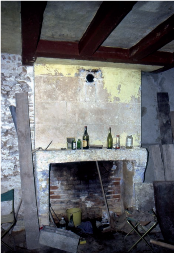
Figure 164. DE 5103. La cheminée avant sa dépose. Collection particulière, cliché Azo.
