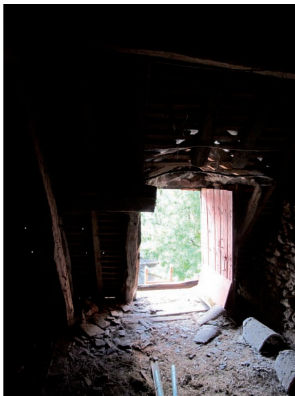
Figure 87. DE 5345. Vue de la lucarne depuis l'intérieur des combles. Cliché J.-Ph. Chimier, 2016.
