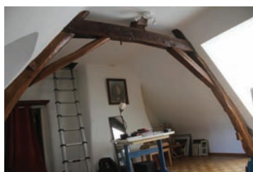
4 impasse du Marché La 1ère ferme principale depuis le nord
