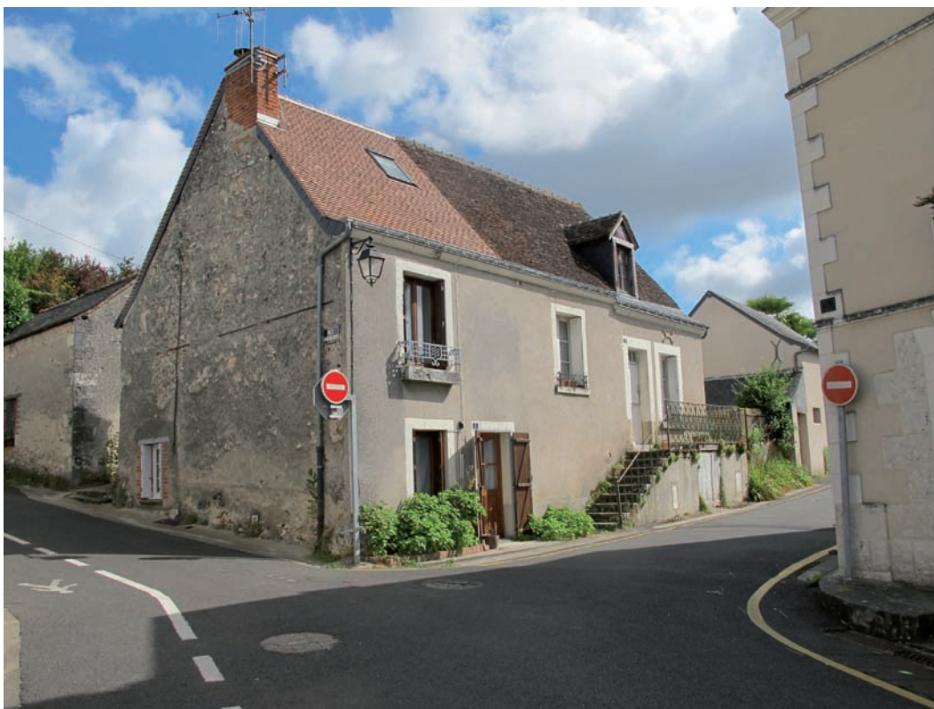
Figure 146. DE 5377. Vue générale de DE 5377 et DE 5318 depuis le sud ouest. Cliché J.-Ph. Chimier, 2016.
