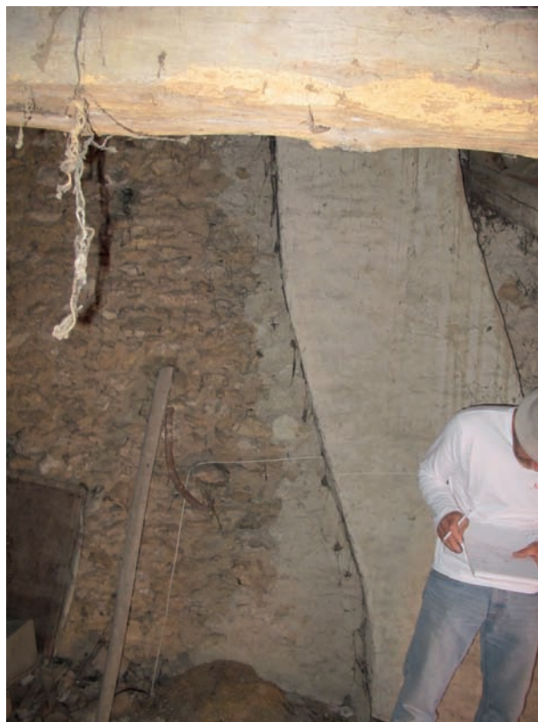
Figure 89. DE 5345. Détail du coffre de la cheminée sur le mur pignon sud. Cliché J.-Ph. Chimier, 2016.
