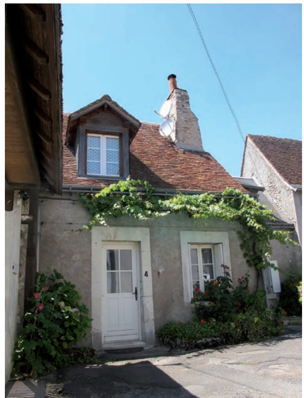
Figure 103. Vue du mur gouttereau est depuis la cour des Douard. Cliché J.-Ph. Chimier, 2016.
