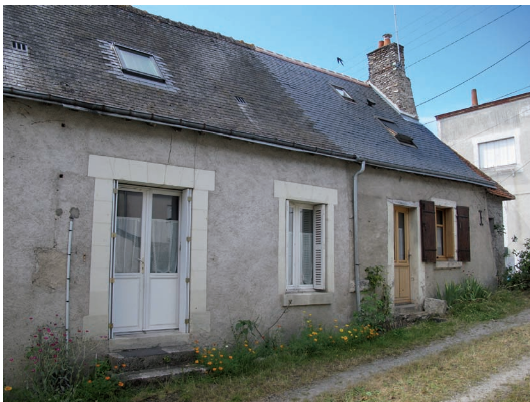
Figure 137. DE 5310 et 5243. Vue générale du bâtiment depuis le sud-est. Cliché J.-Ph. Chimier, 2016.
