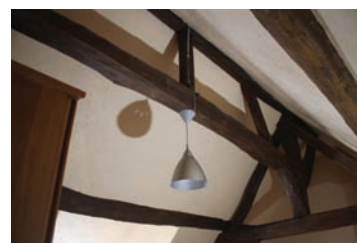
2 impasse du Marché Contreventement longitudinal
