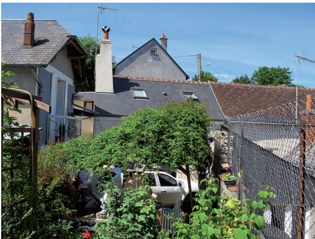
Figure 122. DE 5209. Vue générale du bâtiment depuis le sud. Cliché J.-Ph. Chimier, 2016.
