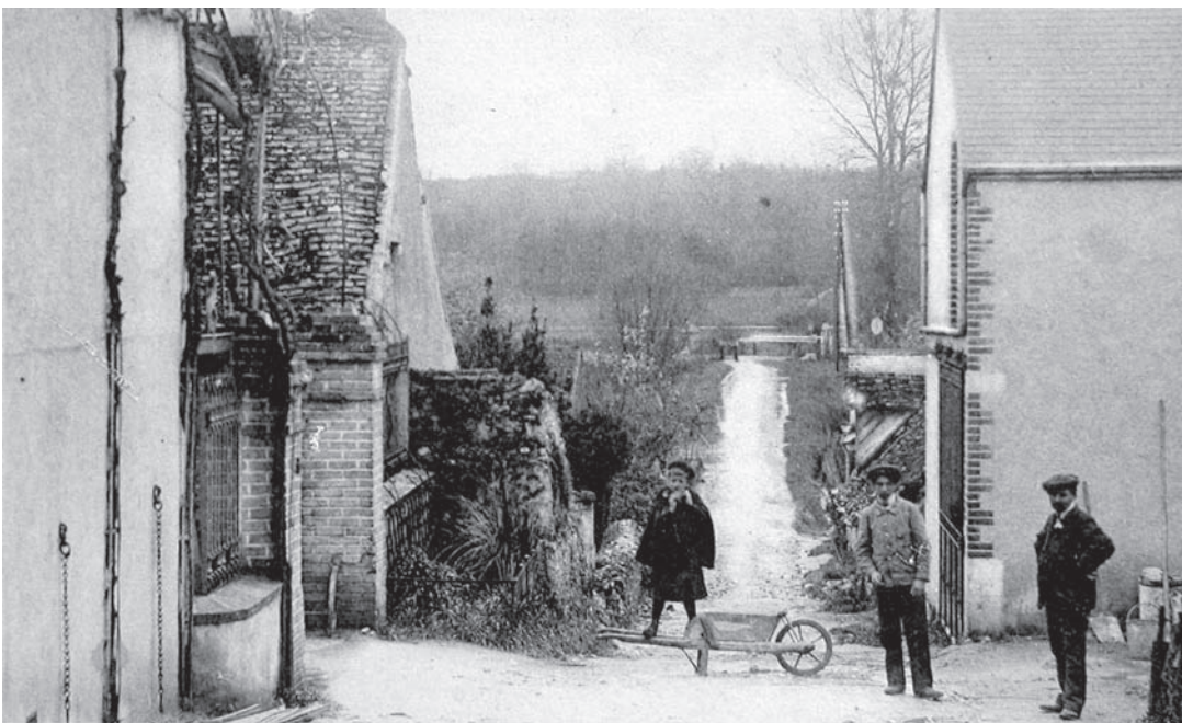
Figure 171. Extrait d'une carte postale du début du 20 e . La rue de la passerelle vue depuis le nord. A droite en arrière plan, le DE 5156 et un autre bâtiment de type loge. A gauche le bâtiment à cheminée en pierre et escalier extérieur. Collection ASPE.
