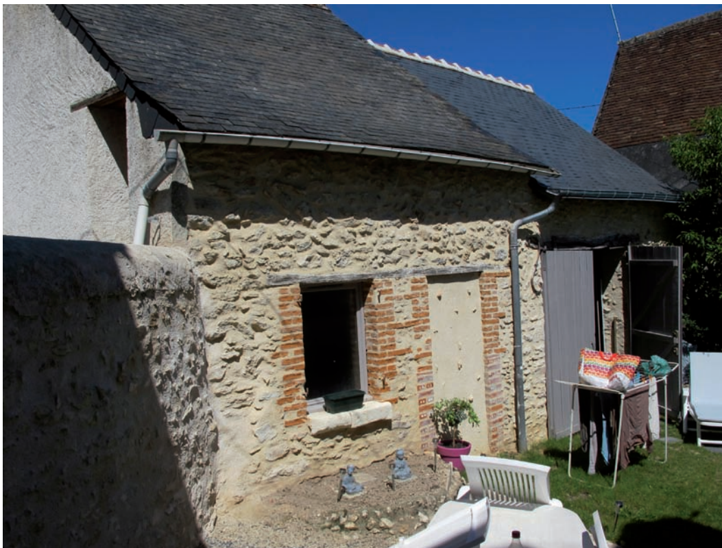
Figure 136. DE 5232. Vue du gouttereau sud-ouest et du bâtiment DE 5231 à droite. Cliché J.-Ph. Chimier, 2012.
