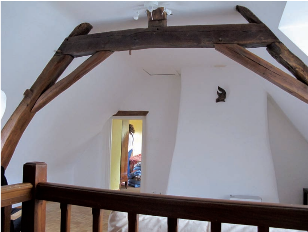
Figure 108. Ferme centrale de la charpente vue depuis le sud dans la partie aménagée des combles. En arrière plan le coffre de cheminée sur le pignon nord. Cliché J.-Ph. Chimier, 2016.
