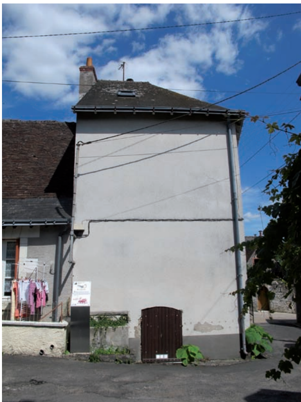
Figure 92. DE 5217. La façade ouest du DE 5217 vue depuis la cour des Douard. Cliché J.-Ph. Chimier, 2016.
