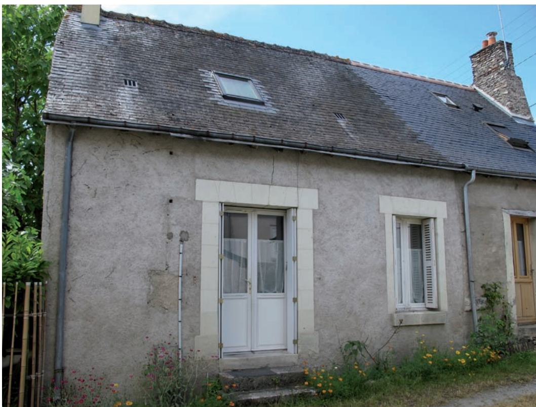
Figure 139. DE 5253. Détail de la façade est. Cliché J.-Ph. Chimier, 2016.
