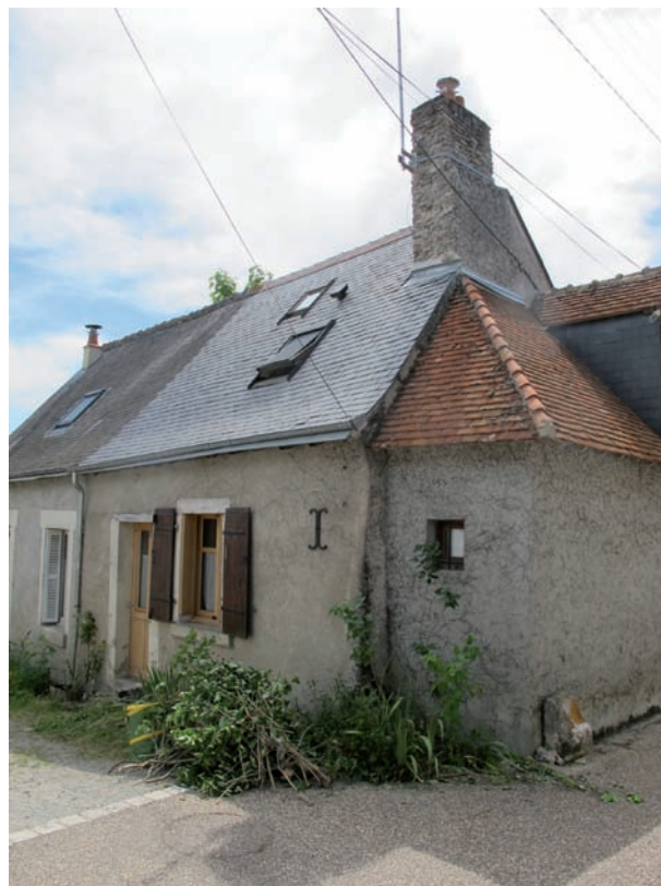
Figure 144. DE 5310. Vue de l'angle nord est, de l'extension nord et de la souche de cheminée en pierres. Cliché J.-Ph. Chimier, 2016.
