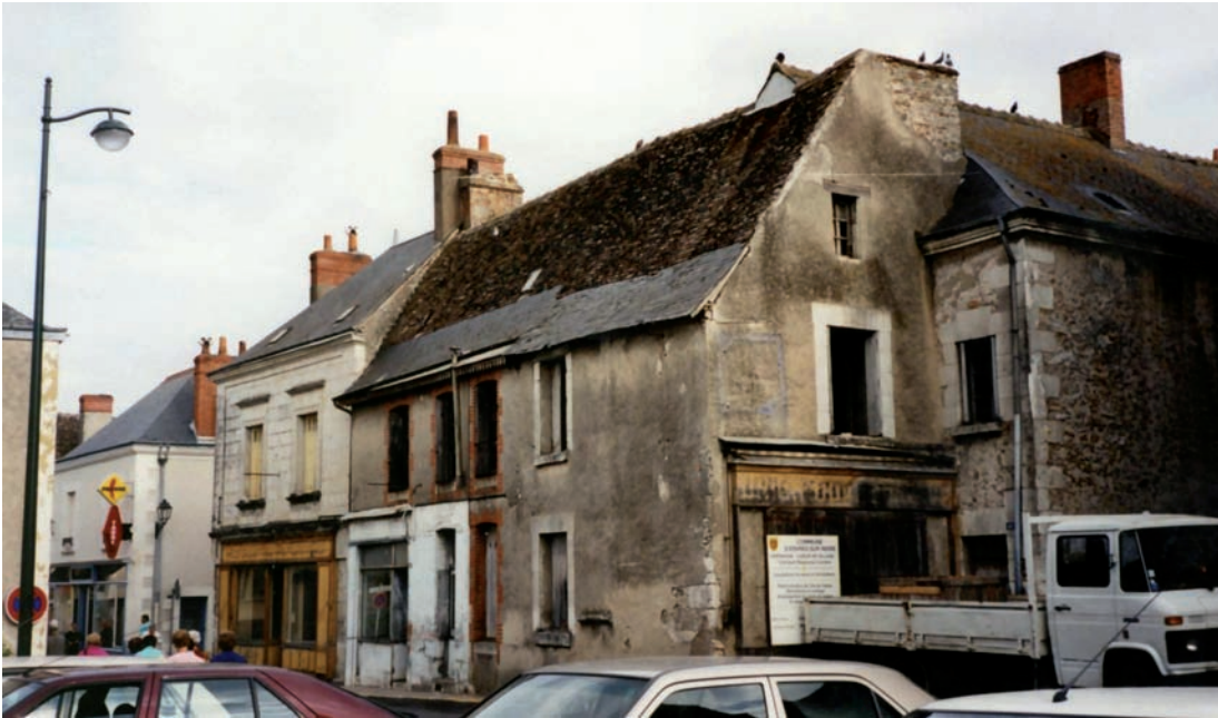
Figure 180. Le bâtiment à étage du quartier Saint-Médard, rue Nationale. Collection ASPE.
