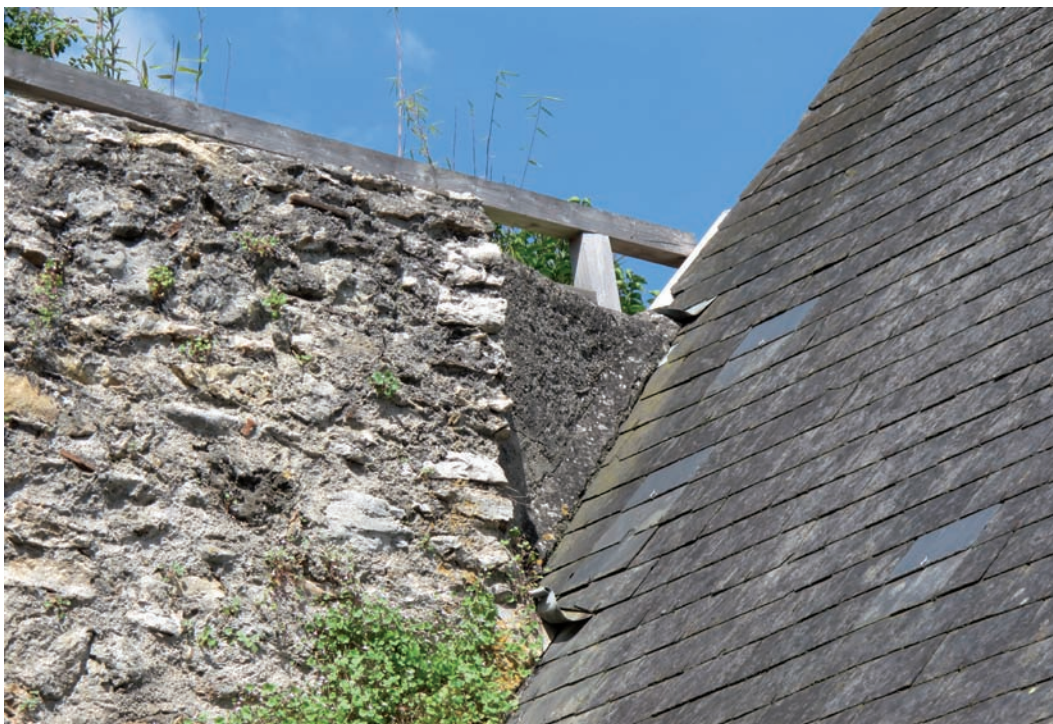
Figure 80. DE 5219. Empreinte de la souche de la cheminée au nord de 5219 vue depuis la cour des Douard. Cliché J.-Ph. Chimier, 2016.
