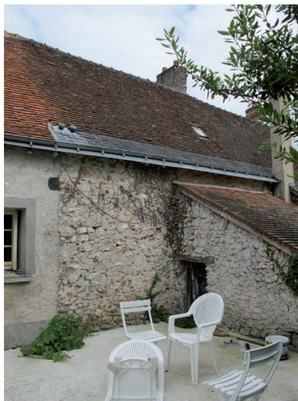
Figure 112. DE 5306. Le mur gouttereau ouest vu depuis le jardin de DE 5306. Cliché J.-Ph. Chimier, 2016.
