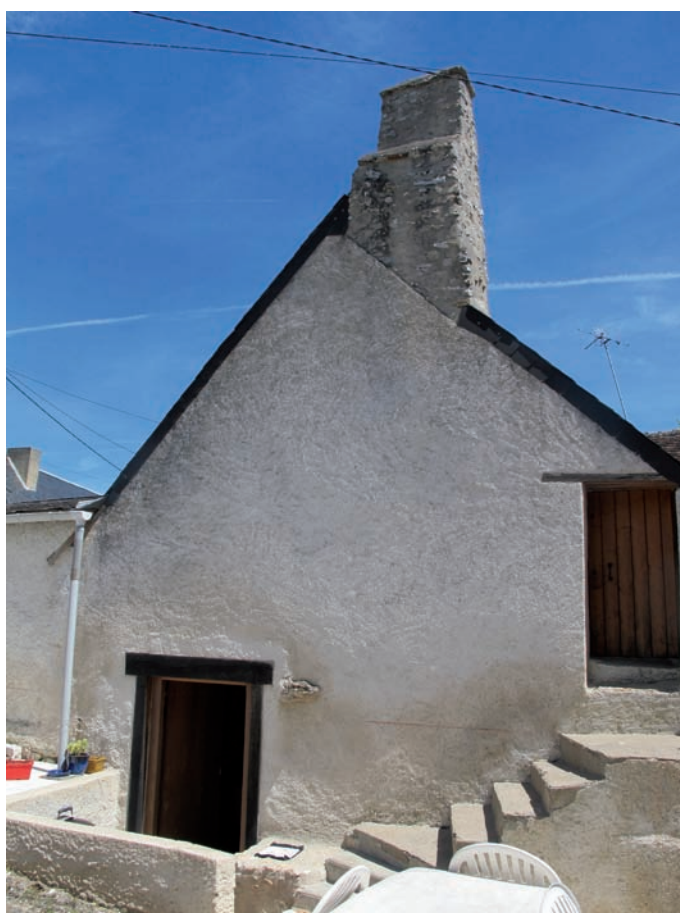
Figure 132. DE 5232. Vue du pignon nord-ouest. Cliché J.-Ph. Chimier, 2016.
