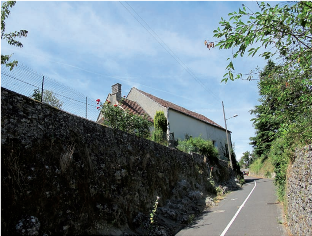
Figure 54. La rue Carlotti vue depuis le sud au niveau de sa jonction avec la ruelle anonyme. Cliché J.-Ph. Chimier, 2016.
