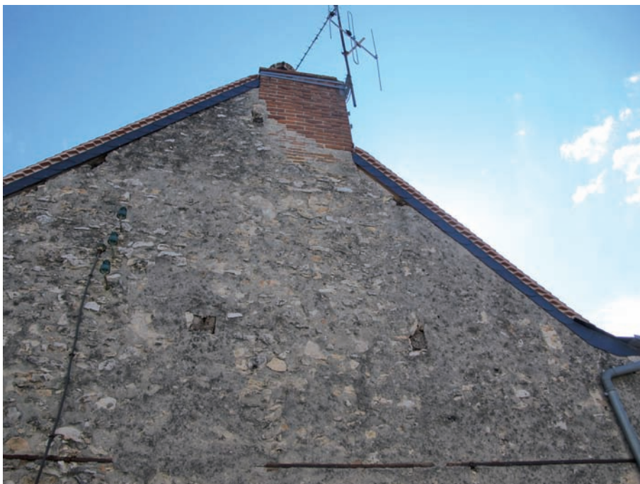
Figure 149. DE 5377. Détail de la façade est et de poutres traversantes au niveau de la cheminée. Cliché J.-Ph. Chimier, 2016.
