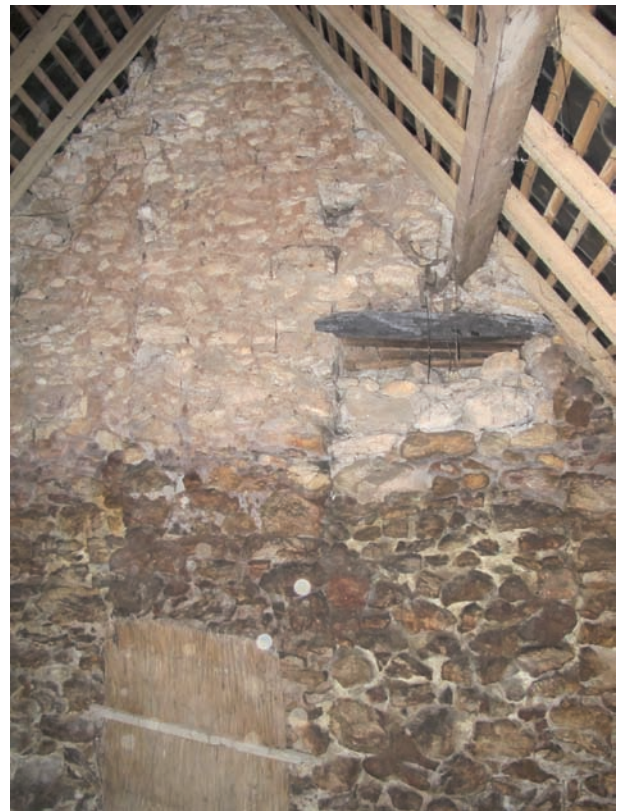
Figure 79. DE 5219. Mur pignon nord vu depuis l'intérieur. Détail de l'empreinte du coffre de cheminée, de l'accès (condamné) aux combles par le pignon et de la charpente. Cliché J.-Ph. Chimier, 2016.
