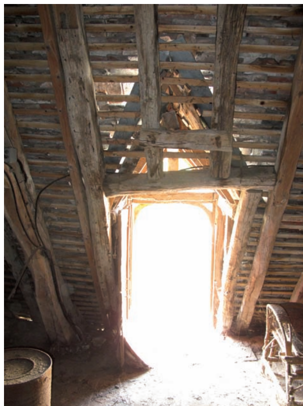
Figure 84. DE 5218. Détail de la lucarne depuis l'intérieur des combles. Cliché J.-Ph. Chimier, 2016.
