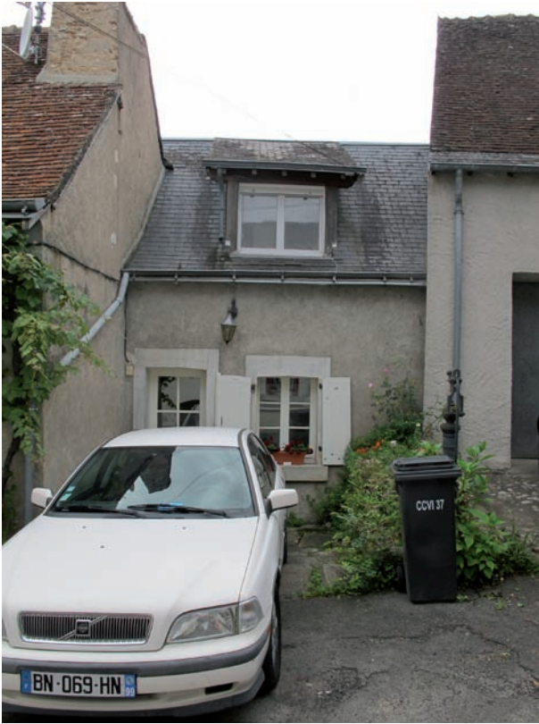
Figure 98. DE 5223. Vue du mur gouttereau est depuis la cour des Douard . Cliché J.-Ph. Chimier, 2016.
