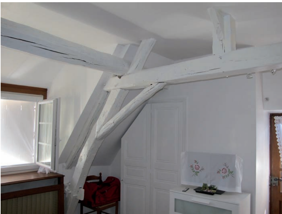
Figure 118. DE 5333. Détail de la charpente et de la lucarne. Cliché J.-Ph. Chimier, 2016.
