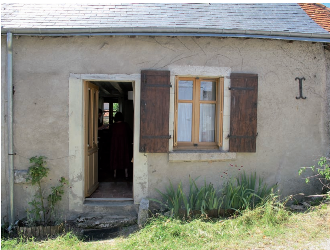
Figure 138. DE 5310. Détail de la façade est. Cliché J.-Ph. Chimier, 2016.
