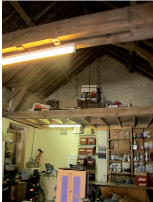
Figure 124. DE 5208. Vue générale de l'intérieur du bâtiment et du pignon ouest avec les consoles de la cheminée et la trace d'arrache du coffre du conduit. Cliché J.-Ph. Chimier, 2016.
