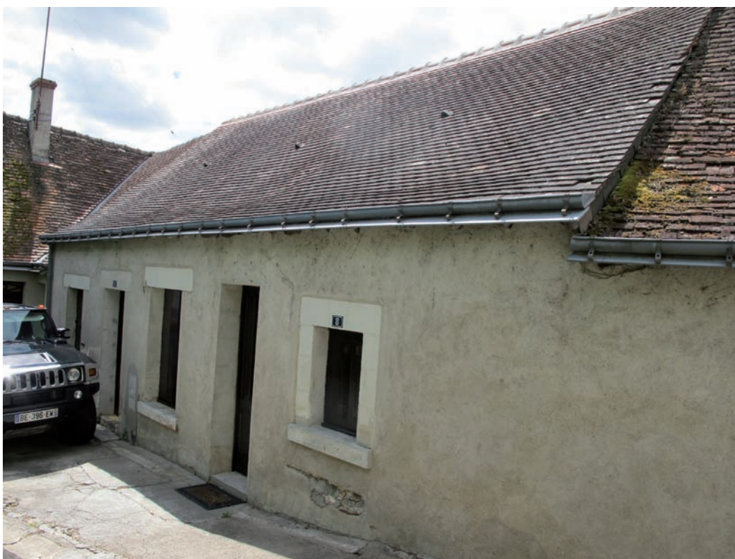
Figure 161. Les DE 5110 et 5111 rue château. Vue depuis le sud. Cliché J.-Ph. Chimier, 2016.
