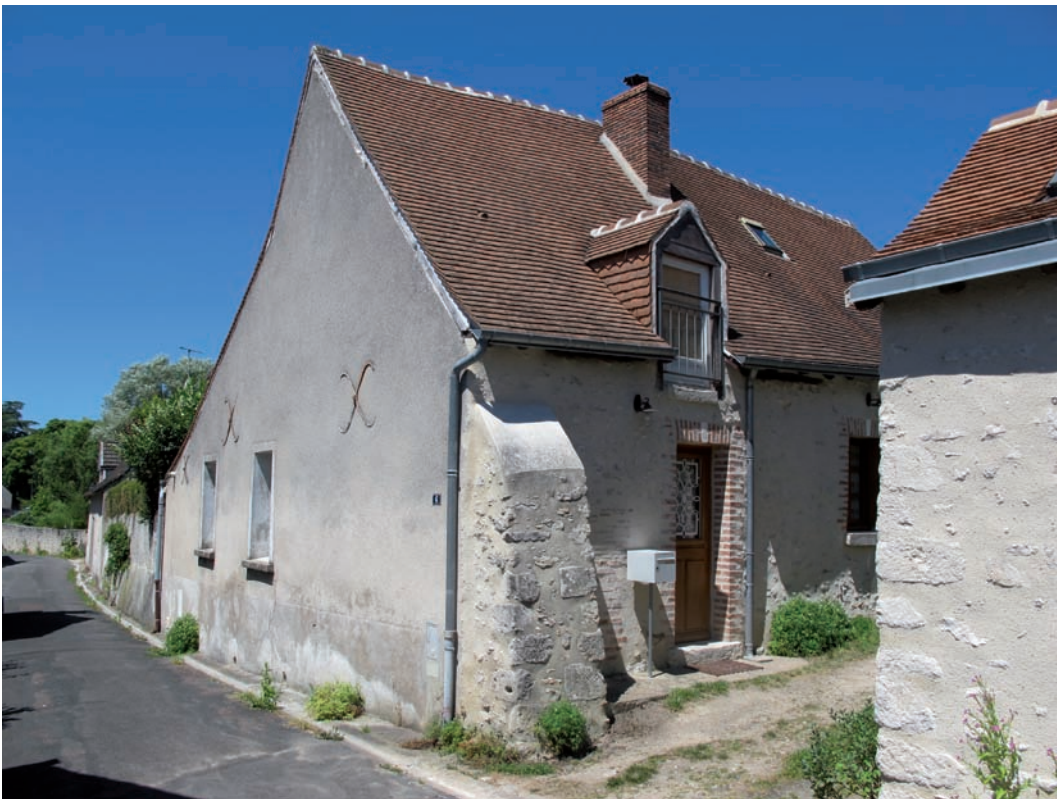
Figure 163. DE 5103. Vue depuis l'est. Cliché J.-Ph. Chimier, 2016.
