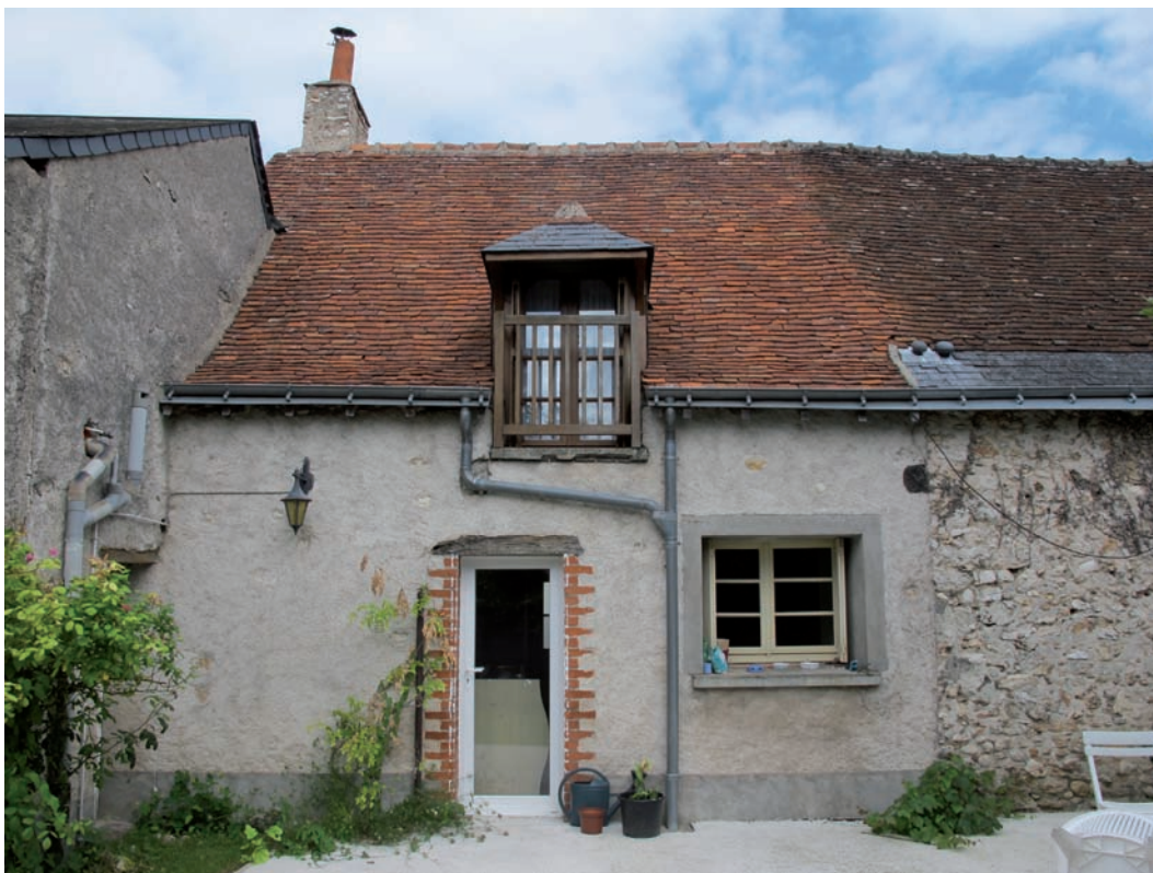
Figure 104. Vue du mur gouttereau ouest depuis le jardin. Cliché J.-Ph. Chimier, 2016.
