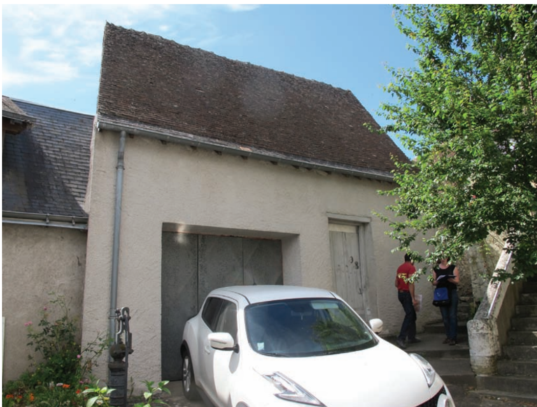
Figure 93. DE 5224. Vue du mur gouttereau est depuis la cour des Douard. Cliché J.-Ph. Chimier, 2016.
