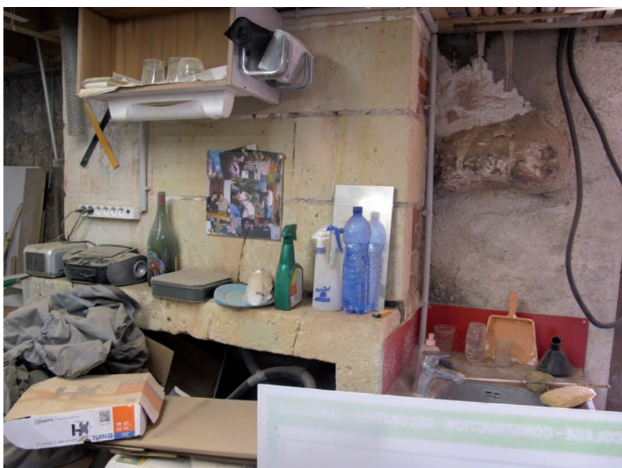
Figure 134. DE 5232. La cheminée en tuffeau, à droite la pierre traversante, vestige de l'état à faux manteau et console. Cliché J.-Ph. Chimier, 2016.
