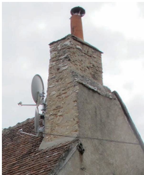
Figure 105. Détail de la souche de la cheminée vue depuis le nord-est. Cliché J.-Ph. Chimier, 2016.
