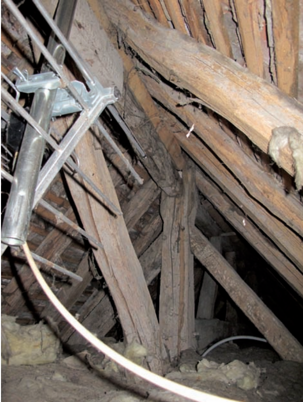
Figure 109. Détail de la charpente dans la partie non accessible des combles. Cliché J.-Ph. Chimier, 2016.
