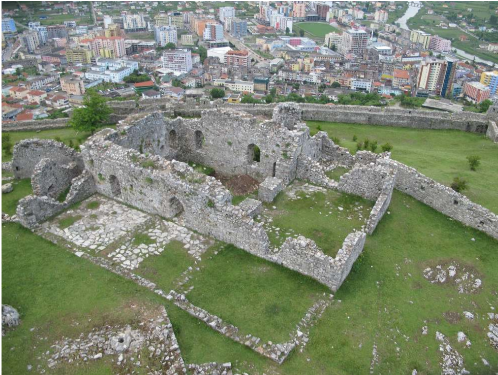
Fig. 6 – Lezha. Vue générale du secteur de la mosquée.
