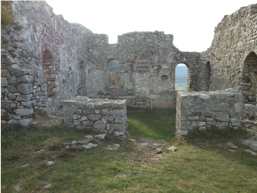
Fig. 7 – Lezha. Vue, vers le sud-est, de la pièce principale depuis la pièce d'entrée.
