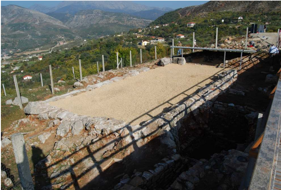
Fig. 38 – Lezha. L'église de la nécropole et la citerne après travaux de consolidation.
