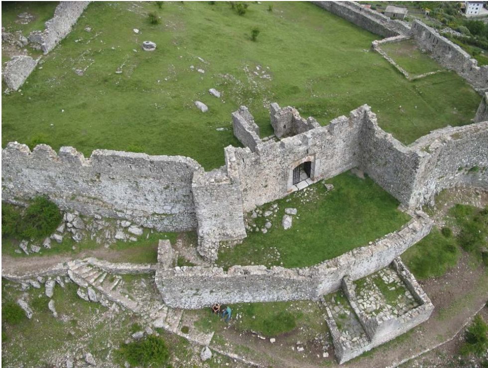
Fig. 4 – Lezha. Vue de la porte ouest de l'enceinte.
