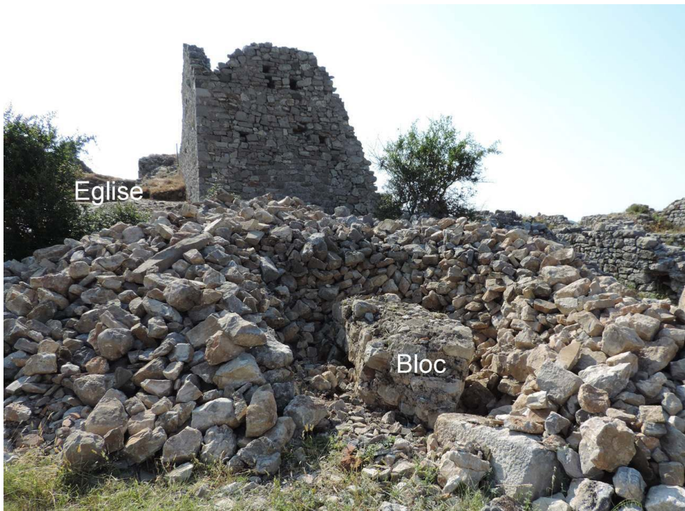
Fig. 5 – Bloc maçonné provenant du mur de l'abside, retrouvé dans un pierrier en contrebas de l'église (au nord-est).
