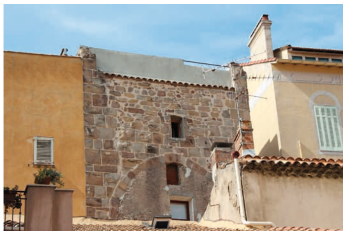
Fig. 4 - Vue de la tour ouverte à la gorge, parcelle BE331 (Cl. Hélène Garcia).
