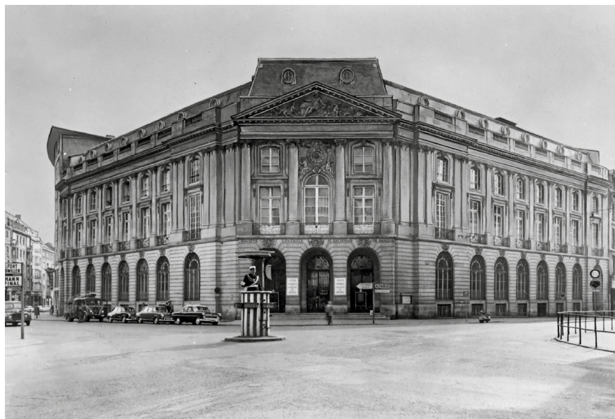
Agence Sogenal, rue du Sauvage, Mulhouse, 1960. © Archives historiques Société Générale.
