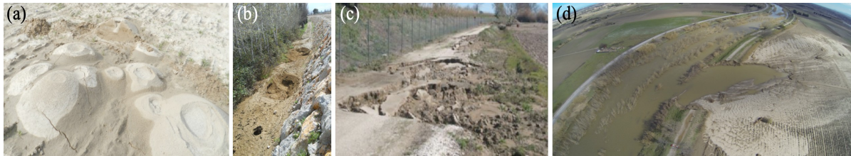
Fig.1- Exemples de signatures d'érosion observées en 2012, 2013, 2014 à proximité des digues de l'Agly en période de crue et de décrue : sand-boils (a), fontis (b,c), effondrements (d) (Photos INRAe).
