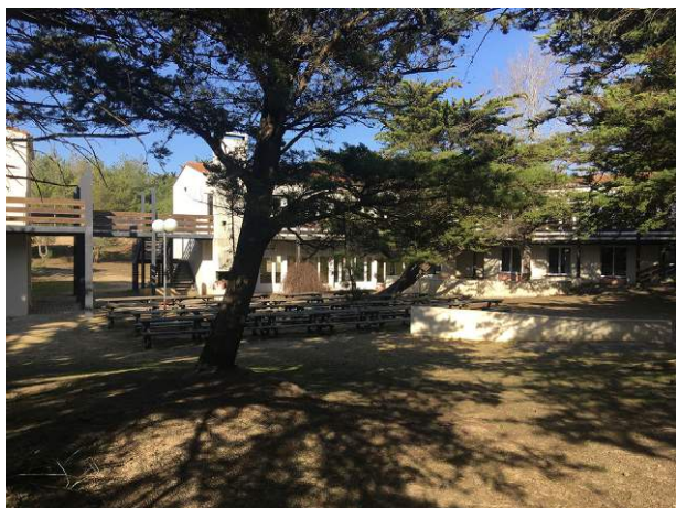
Figure 4 : Bâtiment principal du centre de vacances de la ville de Saint-Denis
