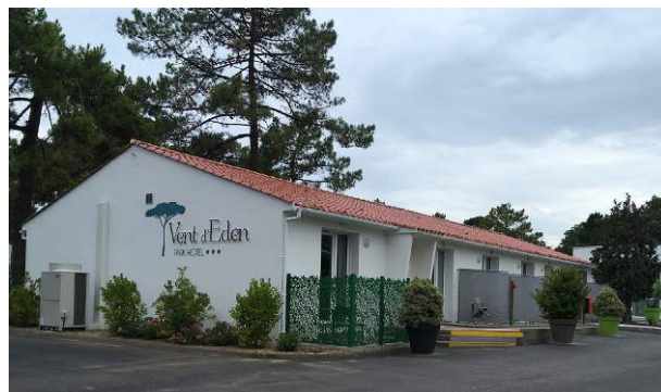
Figure 6 : Un des bâtiments du Vent d'Eden Park Hôtel (ancienne colonie des PTT) One of the buildings of the Vent d'Eden Park Hotel (former PTT holiday camp)
