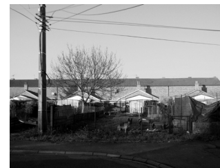
Figure 2. Le coron de la rue Debarge, Harnes.
