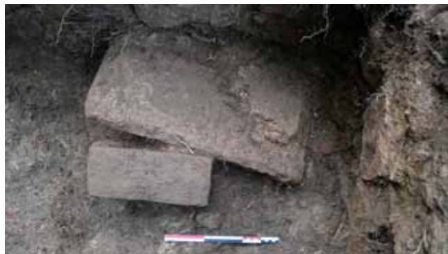
Fig. 65 : Détail de la dalle effondrée de la suspensura qui conserve un morceau de terrazzo
