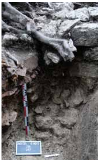
Fig. 52 : Fondation du mur 272 au niveau du mur 216
