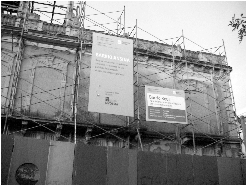
Illustration 1 : Réhabilitation des maisons de la rue Ansina, barrio Palermo (© Clara Biermann 2010).
