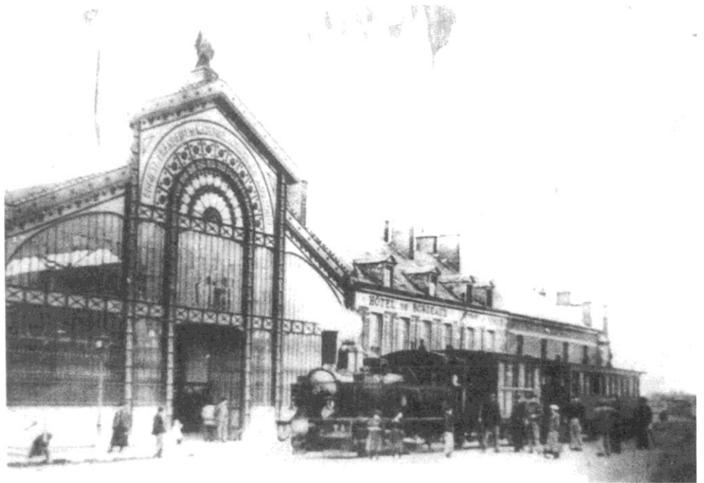
La façade de l'usine de la Société française et le « tacot » de Vierzon.
