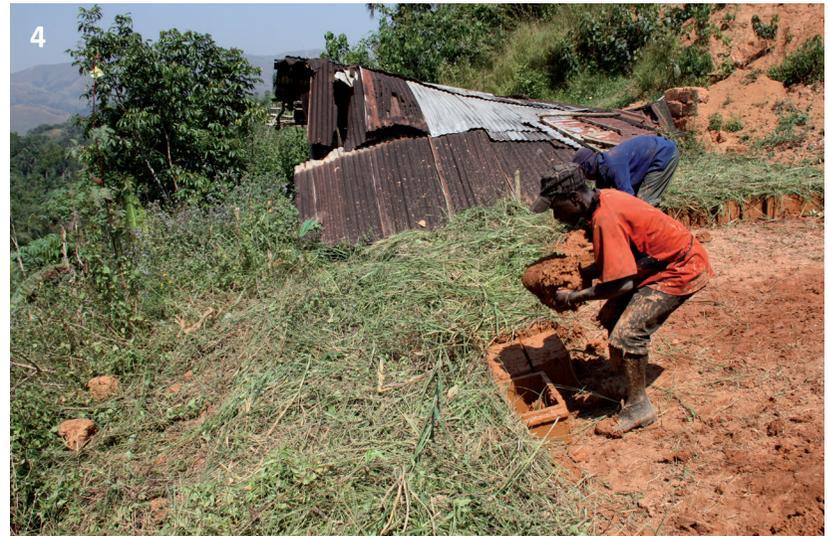
1 : Chantier de collecte de terre pour la construction de briques en terre séchée ;
