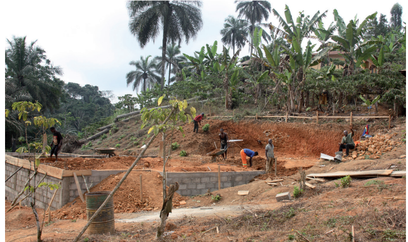
Construction d'une maison moderne
