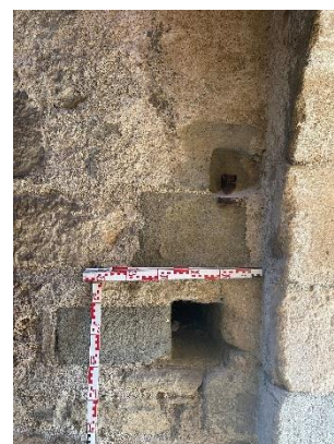
Fig. Gond et encoche de barre de porte, porte amont (nord), côté est. Crédit F. Guillot
