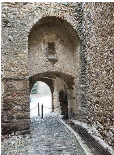
Fig. Le passage désaxé et décalé posé contre l'amont de la tour-porte. Crédit F. Guillot.
