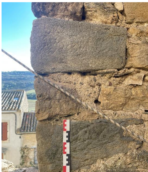
Fig. Angle interne ouest de la bretèche. Grès. Traces de percussions et style du mortier de chaux. Crédit F. Guillot
