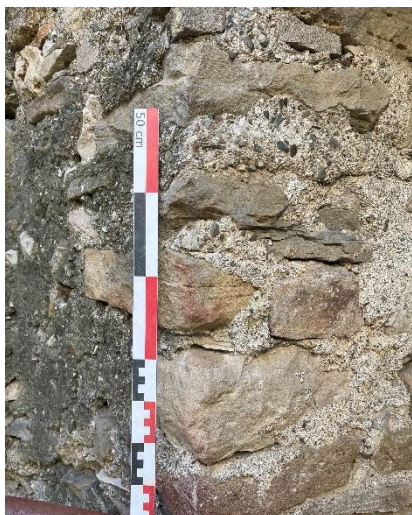
Fig. Mortier de chaux du premier étage, parement interne, mur ouest. Crédit F. Guillot.
