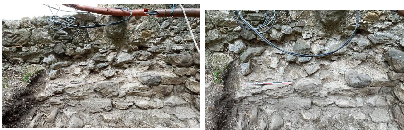
Fig. Uc7 sud interne. Dérasée au premier étage. Crédit F. Guillot
