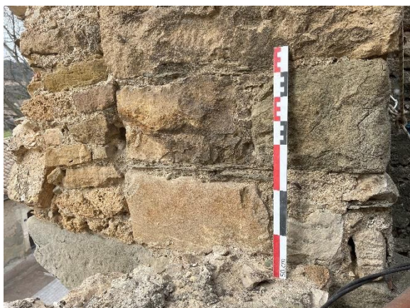
Fig. Grès et calcaire. Schistes ardoisiers en calages et réglage d'assise dans l'encadrement de l'ouverture de la bretèche (phase 2). Parement ouest. Crédit F. Guillot.
