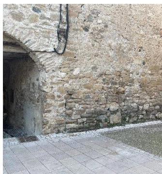
Fig. Coup de sabre entre la porte en haut du passage de la Carambelle et le bâti 0041. Crédit F. Guillot
