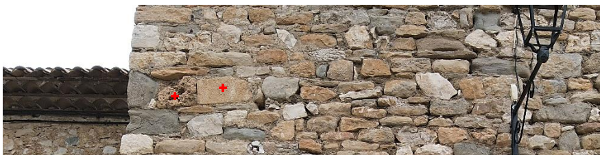
Fig. Exemples de réemplois avérés. Parement externe sud — phase 1. Crédit F. Guillot.
