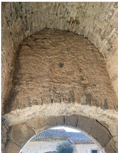
Fig. Face interne du sommet de la porte extérieure, arcature de la porte, arrière-voussure et voûte. Crédit F. Guillot.
