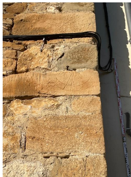
Fig. Angle externe sud-est. Les besaces sont en grès, mais présence de calcaires en parement. Partie d'un cadran solaire. Notez les mortiers peu chargés en galets. Crédit F. Guillot.
