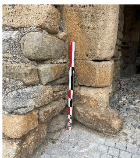
Fig. Piédroit ouest, porte aval.
