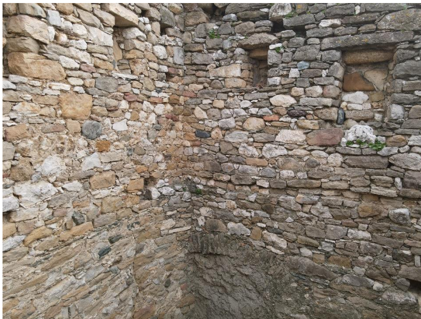
Fig. Parements bigarrés du premier étage à l'intérieur (angle nord-est) de la tour-porte. Bouchage au ciment, nombreux grès, calcaires, tufs et galets. Irrégularité des niveaux d'assises, du volume et de la forme des moellons, etc. Crédit F. Guillot
