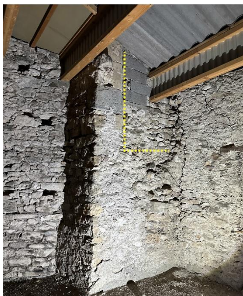
Fig. Porte ouest de l'étage 1 (ouv15) dans les combles du restaurant « La Cave ». Crédit E. Garcia et P. Robert-Cols
