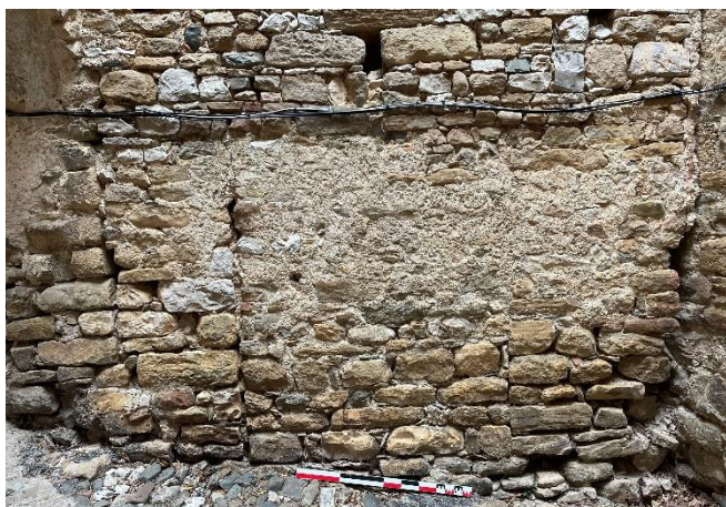
Fig. Est. À gauche, probable entrée (bouchage 116). À droite, réparation entre les deux arcatures (121 et 120). Crédit F. Guillot.
