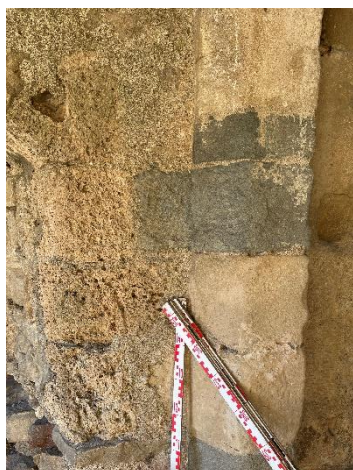
Fig. Tufs dans l'encadrement d'une ouverture de tir et grès dans l'encadrement de la porte intérieure. Notez le chaînage de la porte dans le parement du mur. Crédit F. Guillot
