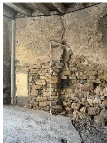
Fig. Est. À gauche, probable entrée (bouchage 116). À droite, réparation entre les deux arcatures (121 et 120). Crédit F. Guillot.
