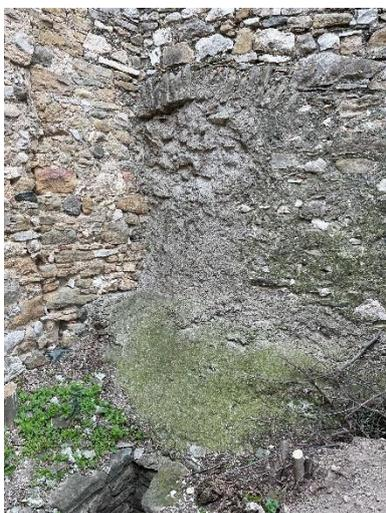
*Fig. Porte bouchée et Uc 42 (à gauche). Premier étage angle nord-est. Crédit F. Guillot*
