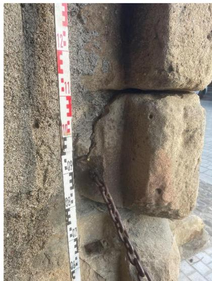
Fig. Usure à l'arrière du piédroit.
