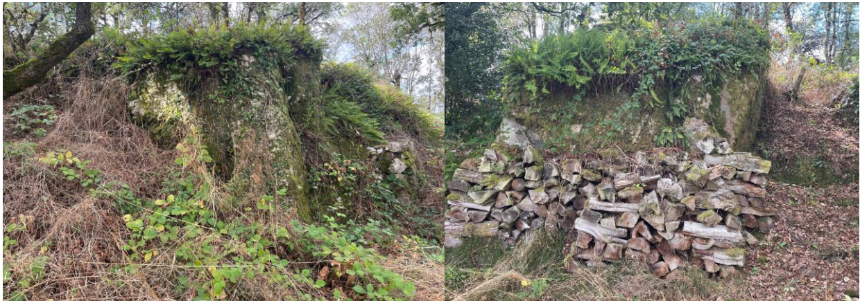
Fig. Retaillies du substrat et murs en pierres sèches au nord-ouest de Montcoyoul. Crédit F. Guillot.
