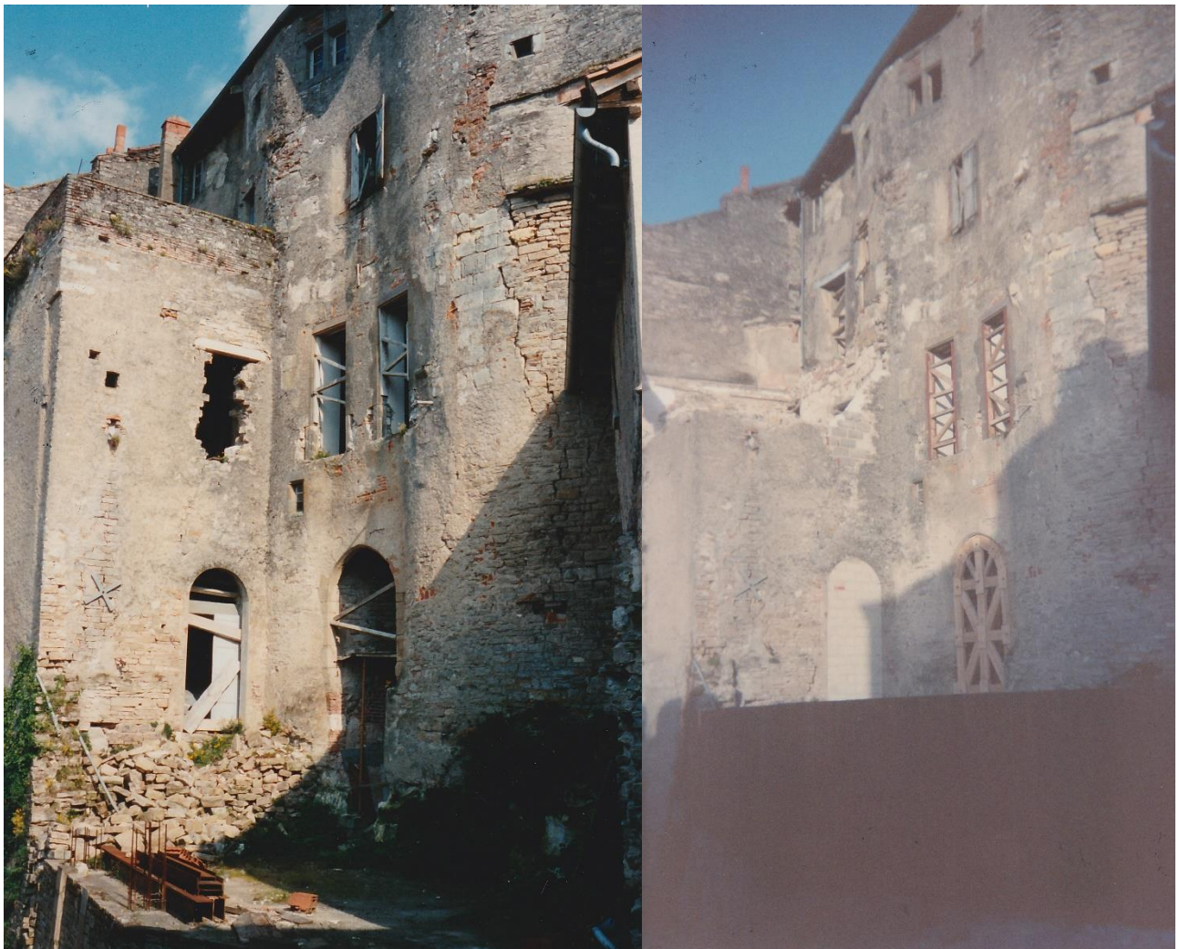
Fig. Maison Cordier face est avant le dérasement et juste après. Noter le bouchage de la porte ouv160. Photographies des dossiers Calvel (fin XXe siècle), archives DRAC Toulouse. Sur l'image de gauche, une autre ouverture située au-dessus de l'ouv160 est visible, informée et confortée d'un linteau en bois qui paraît neuf. On remarque aussi dans l'angle nord-ouest la hauteur du M54 inférieure au toit-terrasse et égale à son arrachement Uc62. Le toit-terrasse est un remontage d'époque contemporaine lors de la destruction du toit de la maison.
