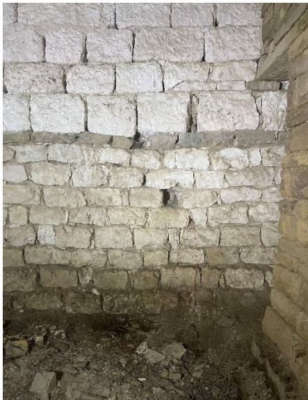
Fig. Vue des trois unités à la base du parement interne du M1 à l'est. Notez le boulon en partie basse. Existente aussi des bouchons d'assise, mais ils sont plus rectangulaires que les empochements des échafaudages. Crédit F. Guillot.
