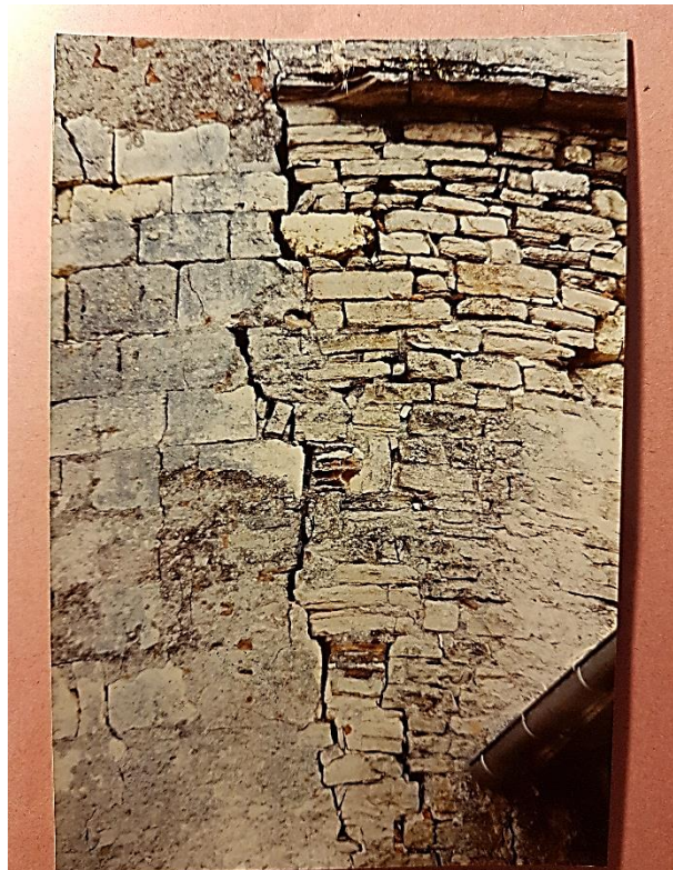
Fig. Exemple de mélange calcaires dolomitiques/calcaires blancs dans la même phase (1) en parement externe, tour nord de la porterie, côté nord. Archives de la Drac-Toulouse, 1988
