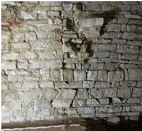
Fig. Arrachement mur Uc211, rétrécissement en largeur à la base (départ de voûte d'une entrée ?). Crédit F. Guillot
