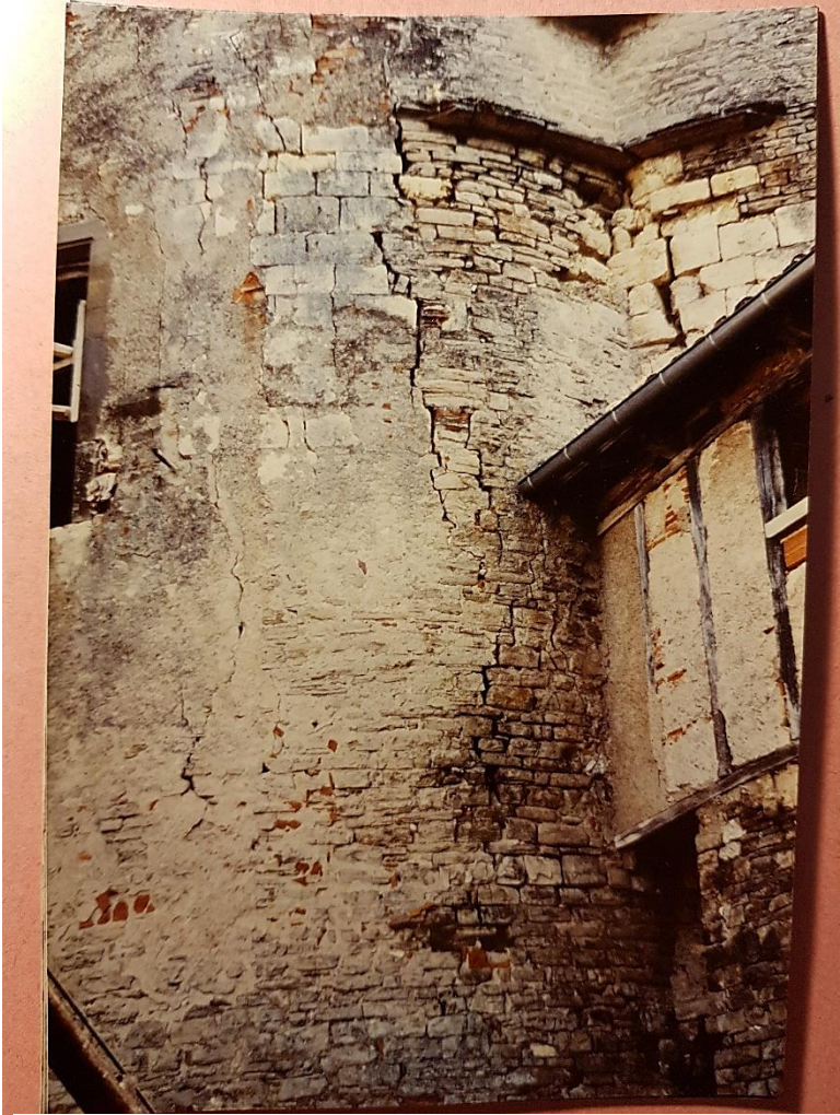
Fig. Mélanges calcaires dolomitiques et blancs. Contact tour nord-ouest de la porterie (à droite) et M1. Archives DRAC Toulouse — 1988
