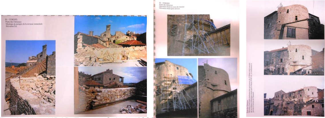
Fig. Archives UDAP. Travaux Calvel >1996
