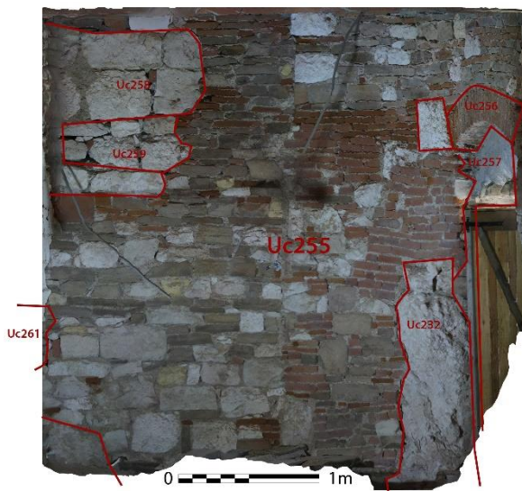
Fig. Orthoimage de la partie ouest du M1 interne niveau-1. Non développée Crédit F. Guillot.
