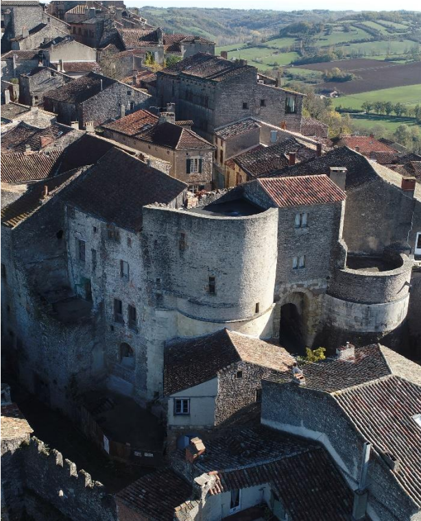
Fig. La porte des Ormeaux et la maison Fabre (à gauche de l'image). Crédit Pascal Robert-Cols
