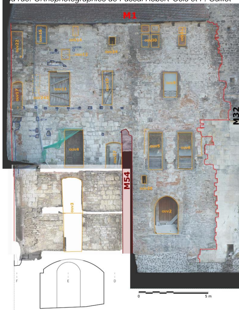
Fig. Numérotation des ouvertures, façade nord de la maison Fabre. Les ouv 17, 11 et 10a et b correspondaient avec l'ancien toit-terrasse de la maison Cordier. L'ouv4b correspond avec l'actuel toit-terrasse de cette maison et l'ouv3 avec les deux niv. -1. Le niveau -2 de la maison Cordier n'est accessible que depuis la rue. Orthophotographies de Pascal Robert-Cols et F. Guillot
