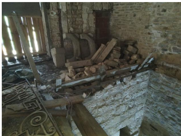
Fig. Image de gauche. Plancher du niveau + 1 et entrée sup du puits jusqu'au niv. -1. On aperçoit le parement interne de l'est du M1-enceinte au niveau 0 et jusqu'à l'ouv233 qui est incluse dans la photogrammétrie levée depuis le niveau-1. À gauche en bas de l'image, les poutres et planches en encorbellement au-dessus du vide. Image de droite : trou jusqu'au niveau -1. Crédit F. Guillot
