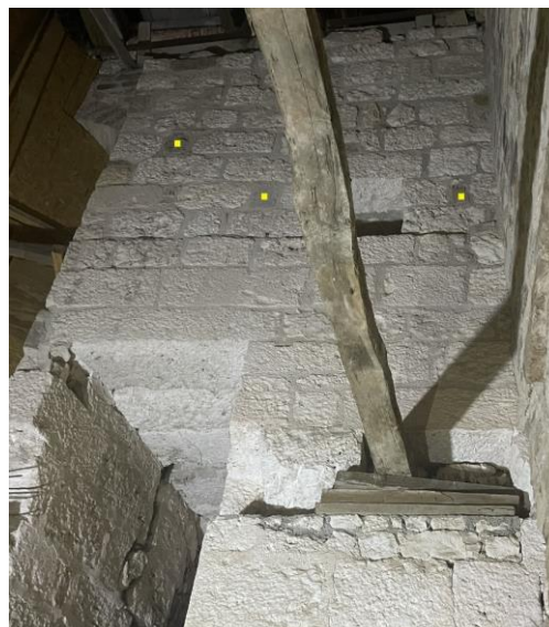
Fig. Partie haute du M1 interne est; l'ouv233 est visible en bas à gauche. Empochements (en jaune) visibles depuis le bas sous le faite dérasé du mur. Crédit F. Guillot
