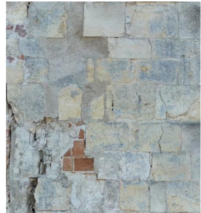
Fig. Calcaires jaunes mêlés à d'autres matériaux, dont des calcaires blancs (en bas). Contact tour nord-ouest de la porterie (à droite) et M1. Extrait de l'orthophotographie de Pascal Robert-Cols
