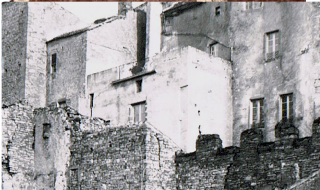
Fig. Fin XIXe siècle – début XXe siècle : l'ancien toit-terrasse en place. Notez la différence entre les deux images (présence ou pas d'ouvertures de jour rectangulaires juste sous le toit-terrasse). Notez aussi que sur l'image la plus ancienne, l'enduit est en bon état, peut-être peu ancien et donc repris lors de la création du toit-terrasse au cours du XIXe siècle. Fonds SAVC
