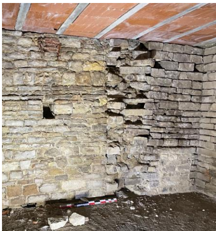
Fig. Jonction M131c(gauche) contre M131b (=M132) près de l'angle (droite) en haut du niv. -1a. À droite la tourelle et son ouv172 (de tir) bouchée. Crédit F. Guillot
