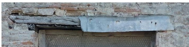
Fig. Linteau en bois et zinc de l'Ouv11, parement externe M1. Extrait de l'orthophotographie de Pascal Robert-Cols
