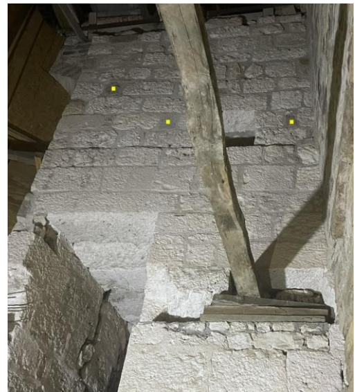
Fig. Partie haute du M1 interne est; l'ouv233 est visible en bas à gauche. Empochements (en jaune) visibles depuis le bas sous le faite dérasé du mur. Crédit F. Guillot
