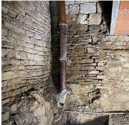
Fig. Angle sud-est, niveau-1. Tourelle (à gauche, M132) contre courtine (M1). Similitude des moellons employés dans le M132 et à la base de la courtine, mêmes niveaux, même Uc. Crédit Florence
