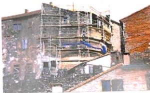
SI - CORDES Panneaux d'élévation Travaux de charpente Poutrelles boisées (sur Nord, phases 1 et 2 voir fond)
