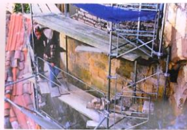
SI - CORDES Panneaux d'élévation Angle recouvert (sud de la tour vers le passage) Reprise du parement extérieur
