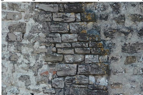
Fig. Calcaires dolomitiques. Contact tour nord-ouest de la porterie (à droite) et M1. Extrait de l'orthophotographie de Pascal Robert-Cols
