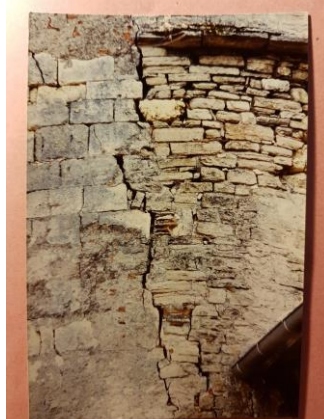
Fig. Contact tour nord-ouest/feston M1. <1988. Cliché R. Manuel. Archives de la DRAC à Toulouse – 52 DRAC 223
