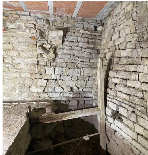
Fig. M132/M131b, angle de la tourelle posé sur M131a (synchrones). Angle nord-est, bas du niveau -1b. Crédit F. Guillot
