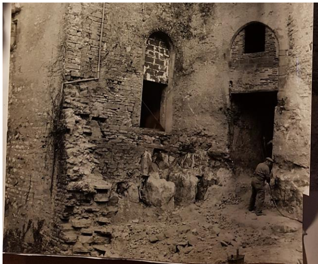
Fig. Archives Drac-Toulouse, dossier de 1989 et images < à 1989. Base M54 (avant dérasement) et M1. Notez l'allongement sous la porte ouv2 à travers le M1 qui a été bouché depuis, et remarquez le parement sous ouv160 qui n'est plus visible. Les travaux semblent être en cours de décaissement jusqu'au substrat (évacuation des anciens sols ?)
