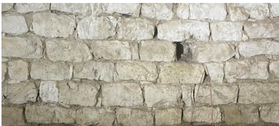
Fig. Calcaires durs à la base interne du M1. Crédit F. Guillot.
