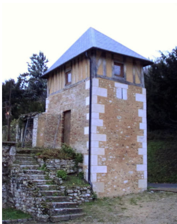
Figure 11 - La tour Paugé (source : https://commons.wikimedia.org/wiki/File:LES_ANDELYS_2017_-_ENCEINTE_PETIT_ANDELY_20.jpg )
