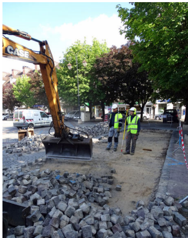
Figure 12 - Dépose des pavés de granite sous la surveillance des agents de la Made
