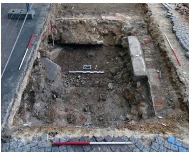
Figure 23 - Sondage 1 - Dégagement en cours de la cave
