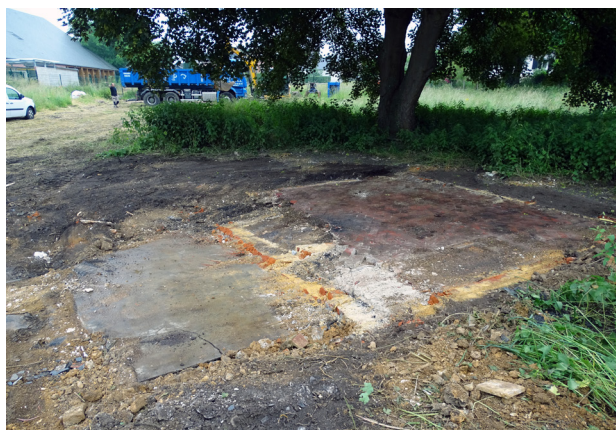
Figure 14 - Emplacement du bâtiment 2 avant purge de ses fondations
