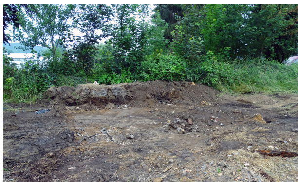
Figure 15 - Emplacement du bâtiment 3 avant purge de ses fondations
