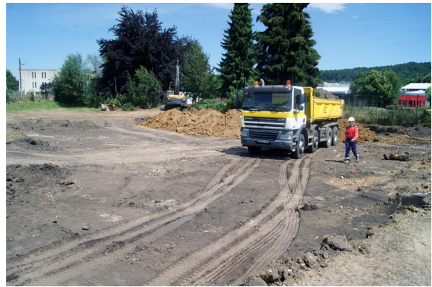
Figure 18 - Circulation d'engins et mise en place de remblais sur les surfaces décapées, non protégées
