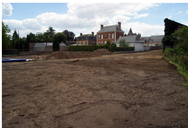
Figure 25 - Vue d'ensemble de la parcelle AH 289 après le décapage de la terre végétale
