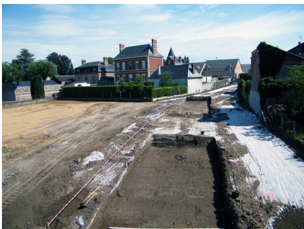
Figure 19 - Vue d'ensemble, vers le sud, des deux bassins drainants après terrassement
