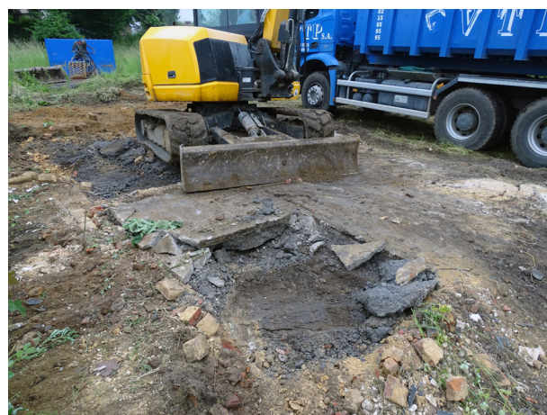
Figure 16 - Terrassement en cours sur les substructions du bâtiment 1
