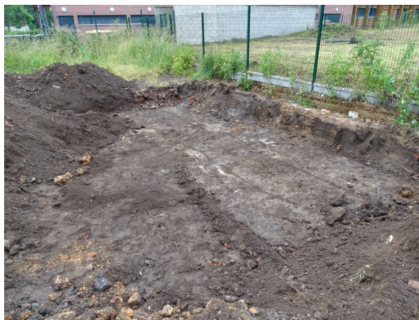
Figure 17 - L'emprise du bâtiment 1 après le terrassement
