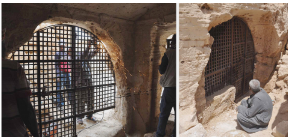
Fig. 19. Étapes successives de la restauration de la grille entre la salle 3 et l'espace 3bis (MFTMP, T. Fournet).
