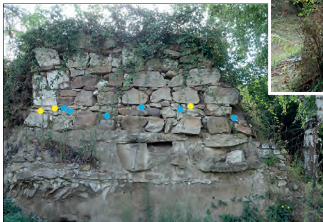
Fig. IX.1-16 - Fragments de faluns consolidés en réemploi dans le mur de soutènement plaqué contre la paroi nord-est du talus : calcaire bioclastique R1 en bleu, calcaire bioclastique R2 en jaune © Cliché A.L. Déodat.
