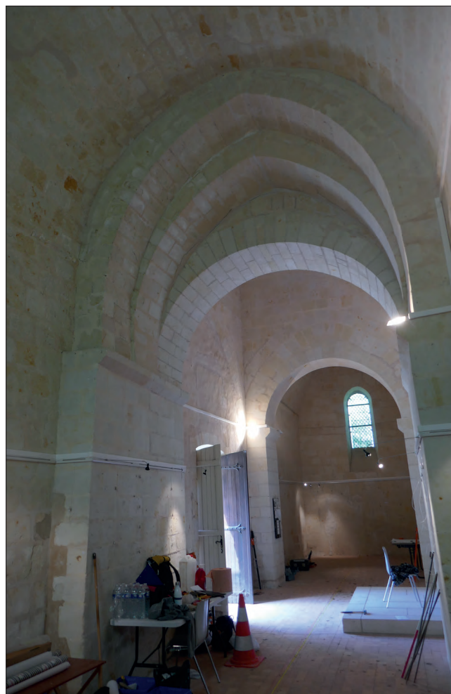
Fig. VIII.4.32 - Arc sud de la croisée à triple rouleau (restauration 30040) © Cliché A. Remy.
