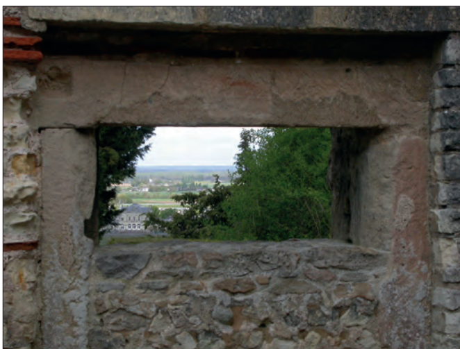
Fig. VII.2-28 - La porte antique du mur nord de la nef © Cliché L. Déodat 2018.
