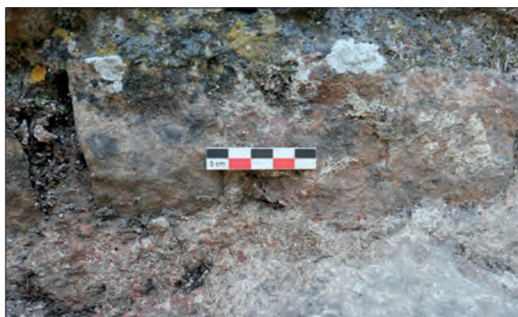
Fig. VII.3-60 - Détail de résidus de mortier de tuileau contre la paroi externe de la conduite dans le transect médian © Cliché X. Favreau, juillet 2022.
