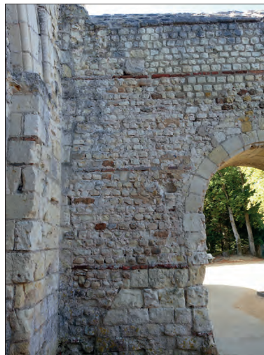
Fig. IV-9 - Parement extérieur du clocher de Saint-Vétérin présentant une alternance d'assises de moellons de tuffeau avec des briques © Cliché L. Déodat 2021.
