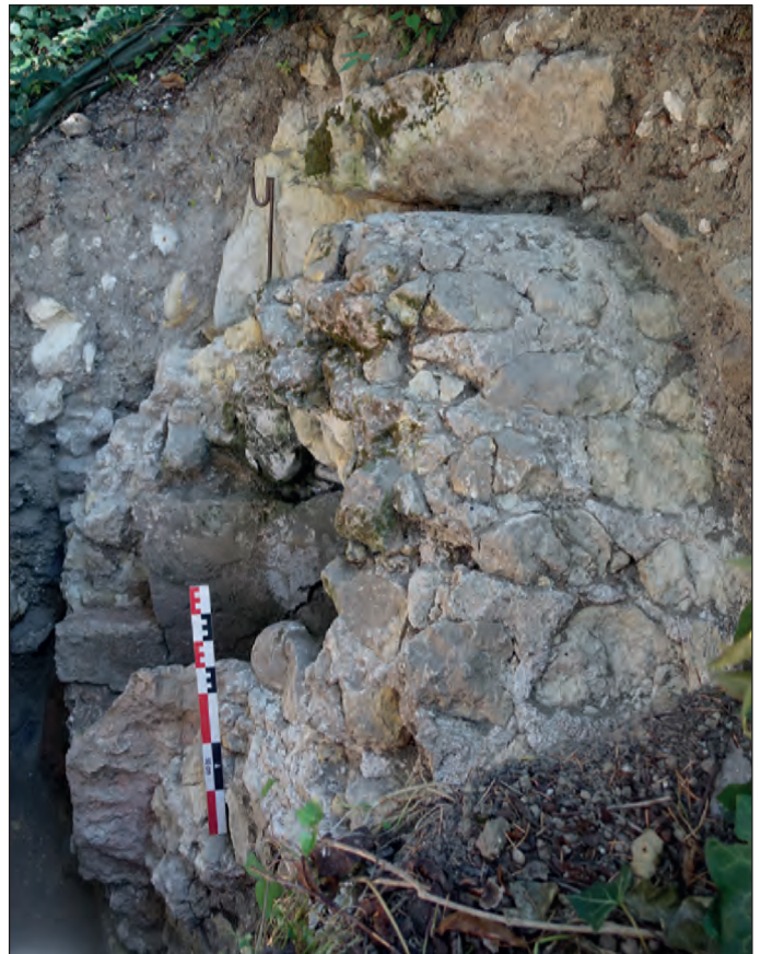
Fig. VII.4-42 - Vue de l'extrados de la voûte de l'aqueduc de Mardron, depuis le dessus © Cliché L. Déodat 2022.
