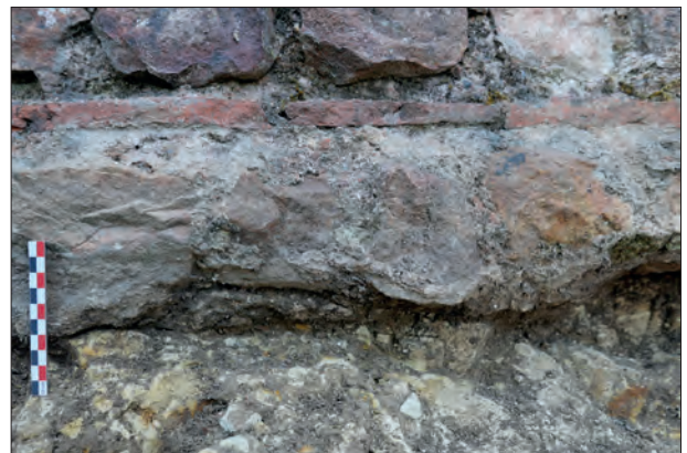
Fig. VII.3-43 - Détail des résidus de mortier collés sur la fondation de 1002 © Cliché X. Favreau, juin 2022.
