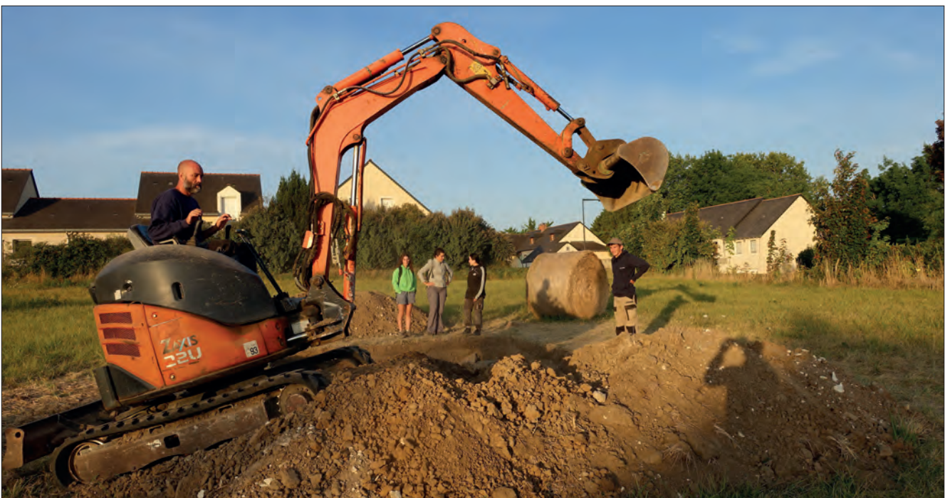
Fig. VIII.3.12 - Rebouchage des sondages à la pelle mécanique à la fin de la campagne 2022 © Cliché L. Déodat.
