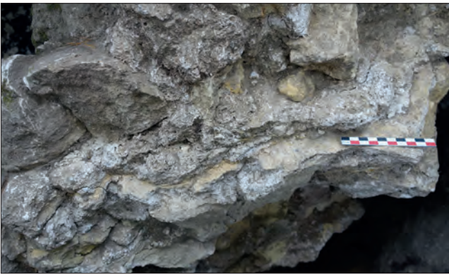
Fig. VII.4-31 - Détail sur le piédroit nord-ouest de la couche de mortier lissée, UE 10022 © Cliché L. Déodat 2022.
