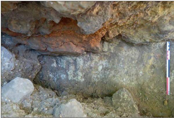
Fig. VII.4-26 - Niveau de substrat rocheux en fond de sondage, avec à gauche, un aspect brûlé : l'aqueduc est totalement détruit © Cliché L. Déodat 2022.
