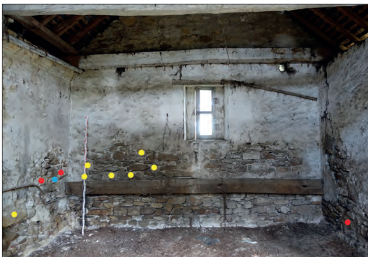
Fig. IX.1-20 - Fragments de faluns consolidés en réemploi dans le parement interne du pignon nord-est et de l'extrémité nord-est des façades nord-ouest et sud-est de la remise : calcaire bioclastique R1 en bleu, calcaire bioclastique R2 en jaune, calcaire bioclastique R3 en rouge (cl. L. Déodat).
