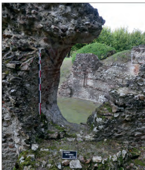
Fig. VII.3-16 - Vestiges (bûchés) de l'adduction de la conduite supérieure (UE 1004) © Cliché A. Remy, octobre 2021.
