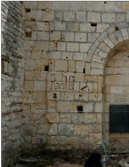
Fig. VIII.4.36 - Détail du contact entre la nef et le bras sud du transept © Cliché A. Remy.
