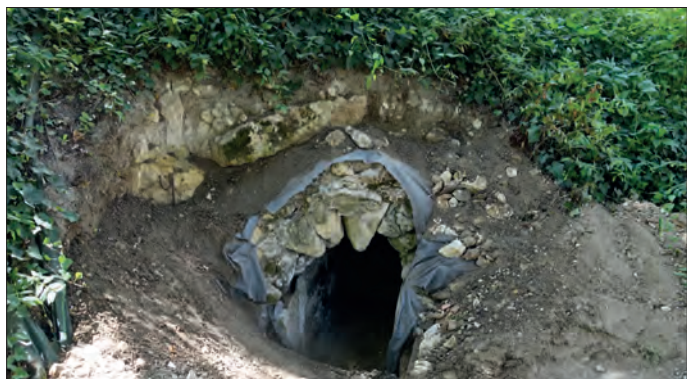
Fig. VII.4-45 - L'aqueduc après recouvrement dans son état initial, avec pose d'un géotextile de protection © Cliché L. Déodat 2022.
