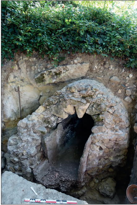
Fig. VII.4-24 - L'aqueduc après les fouilles, vu depuis le nord-est © Cliché L. Déodat 2022.
