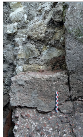
Fig. VII.4-36 - Détail de la paroi sud, avec l'enduit hydraulique formée de deux passes bien distinctes, UE 100007 et 10015 © Cliché L. Déodat 2022.
