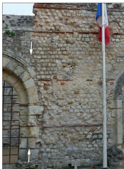
Fig. VIII.4.15 - traces de l'ancien collage du mur perpendiculaire à la façade sud © Cliché A. Remy.
