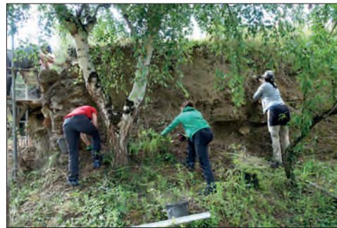
Fig. VIII.3.6 - Le mur M.2 en cours de démontage depuis l'échafaudage © Cliché L. Déodat.
