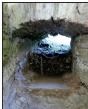
Fig. VII.3-55 - Vue de la conduite inférieure © Cliché X. Favreau, septembre 2022.
