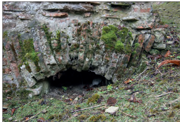
Fig. VII.3-10 - Vue de la conduite inférieure dans le soubassement de l'abside 1002 © Cliché A. Remy, octobre 2021. Fig. VII.3-11 - Détail du débouché ouest de la conduite inférieure de l'abside 1002 © Cliché X. Favreau, octobre 2021. Fig. VII.3-12 - Détail du débouché nord de la conduite inférieure de l'abside 1002 © Cliché X. Favreau, mars 2021.
