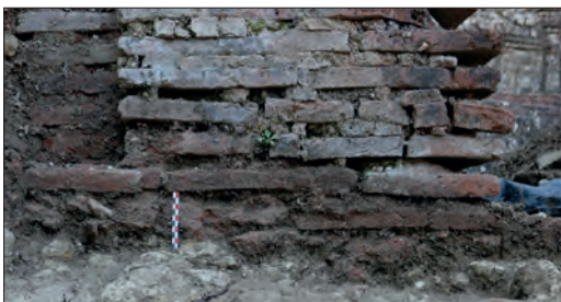
Fig. VII.3-37 - Détail du radier 1023 à la base du massif d'angle nord de l'abside 1002 © Cliché X. Favreau, juillet 2022.
