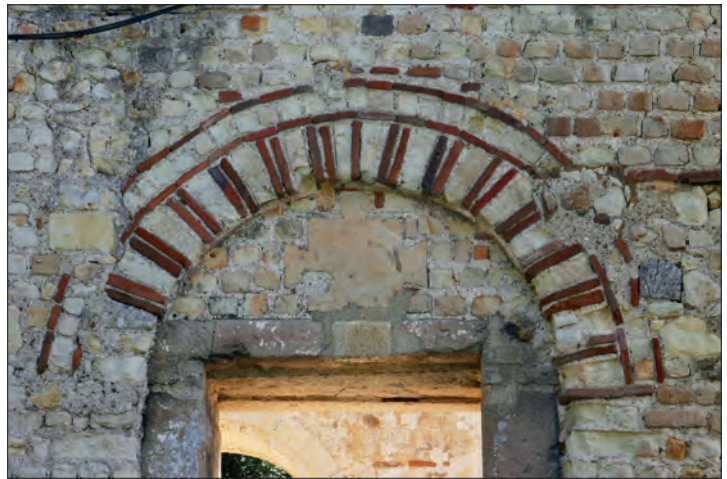
Fig. VIII.4.24 - Détail de la porte nord (UE 30001) © Cliché A. Remy.
