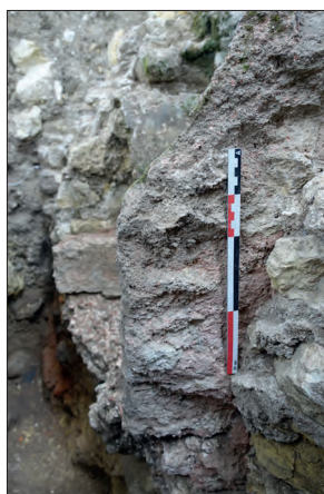
Fig. VII.4-38 - Détail de la paroi nord vue du nord, à l'arrière avec le piédroit nord à droite © Cliché L. Déodat 2022.
