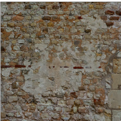
Fig. VIII.4.18 - enduits conservés sur le mur sud de la nef © Cliché A. Remy.
