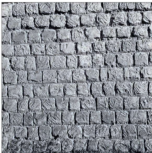
Fig. VII.3-75 - Élévation en opus vittatum de l'enceinte de Beauvais, Oise © d'après Adam 1984, p. 151 : fig. 326.
