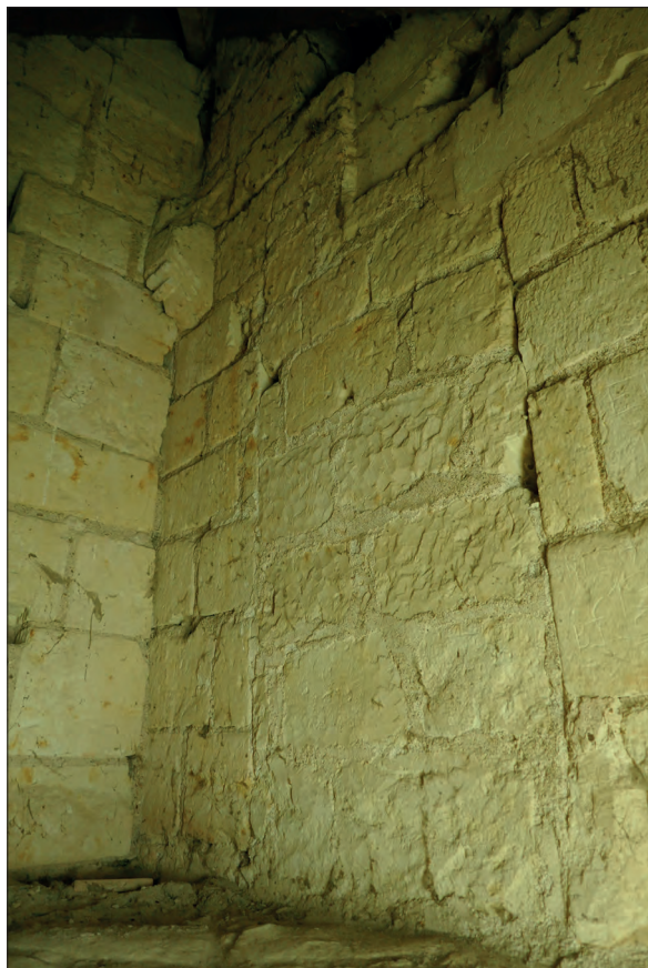
Fig. VIII.4.39 - Porte murée débouchant sur la travée droite du chœur © Cliché A. Remy.
