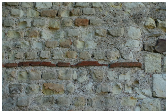
Fig. VIII.4.8 - Tegulae et briques mises en œuvre dans le mur 30001.
