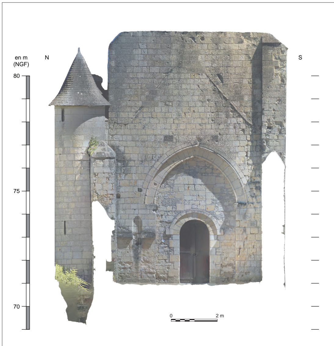
Fig. VIII.4.26 - Orthophotographie du parement ouest de la croisée © Réalisation A. Remy.
