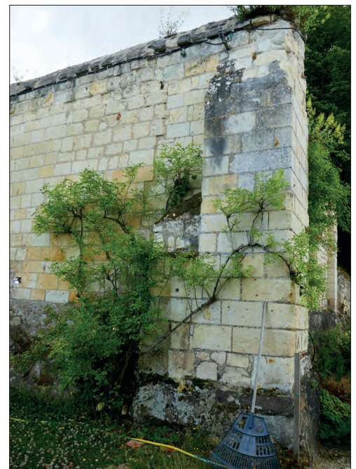
Fig. VIII.4.23 - Ancien piédroit lié à la base du contrefort nord-ouest.
