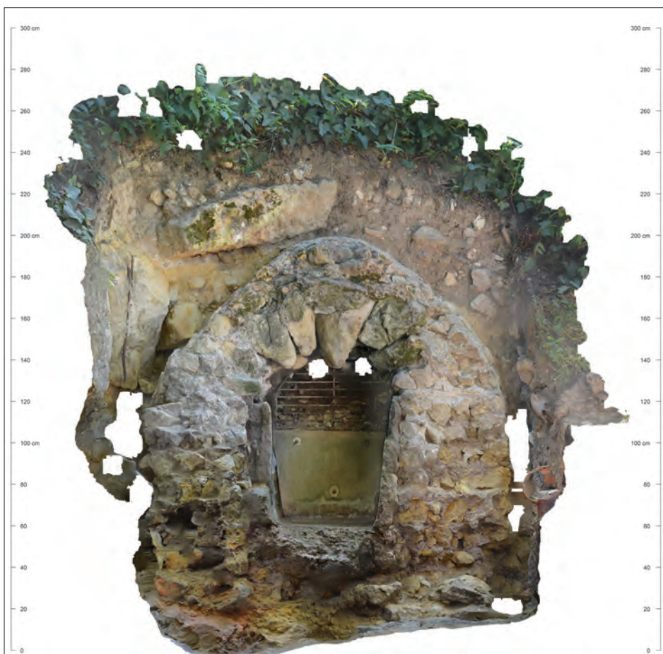
Fig. VII.4-23 - Orthophotographie de l'aqueduc © Réalisation D. Morleghem 2022.
