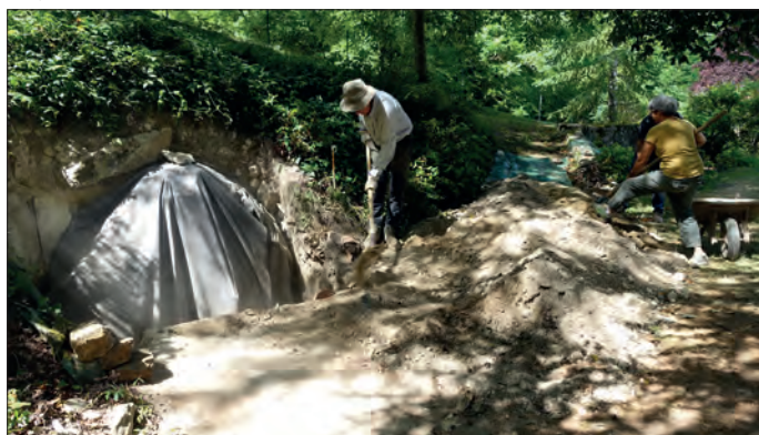
Fig. VII.4-44 - L'aqueduc en cours de recouvrement avec pose d'un géotextile de protection, M. Cousin et C Coiffard à l'œuvre © Cliché L. Déodat 2022.
