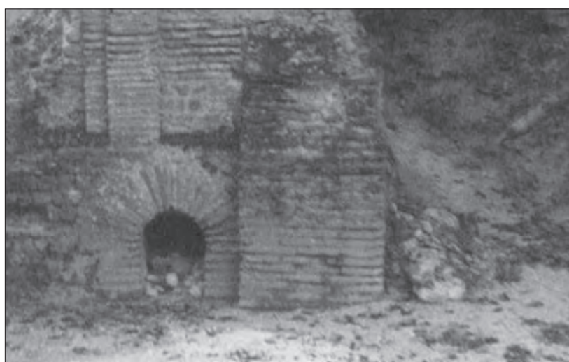
Fig. VII.3-29 - Vue depuis le nord-ouest de la conduite hydraulique 1021 dans la continuité de la conduite inférieure de l'abside 1002 © Cliché X. Favreau, juillet 2022.
