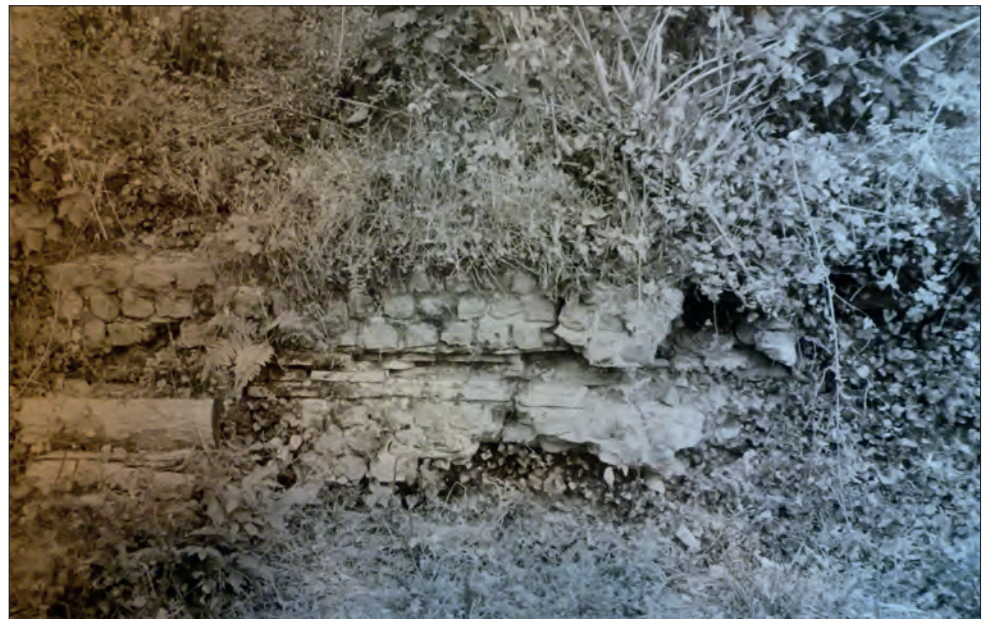
Fig. VI-4 - Photographie d'une maçonnerie de l'édifice de spectacle de Gennes © ADML, 252 J 104.
