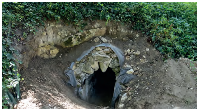
Fig. VII.4-45 - L'aqueduc après recouvrement dans son état initial, avec pose d'un géotextile de protection © Cliché L. Déodat 2022.
