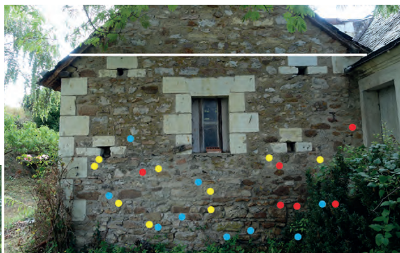
Fig. IX.1-17 - Fragments de faluns consolidés en réemploi dans la partie basse du parement externe du pignon nord-est de la remise : calcaire bioclastique R1 en bleu, calcaire bioclastique R2 en jaune, calcaire bioclastique R3 en rouge © Cliché A.L. Déodat.
