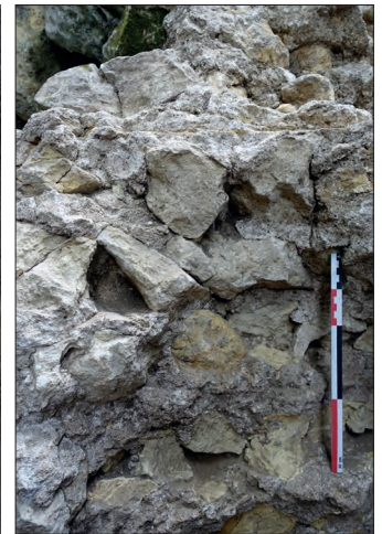
Fig. VII.4-30 - Détail de la morphologie du piédroit nord-ouest, avec l'UE 100021 formée de plusieurs assises et terminée par une couche de mortier lissée, UE 10022 © Cliché L. Déodat 2022.
