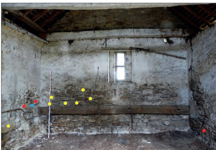
Fig. IX.1-20 - Fragments de faluns consolidés en réemploi dans le parement interne du pignon nord-est et de l'extrémité nord-est des façades nord-ouest et sud-est de la remise : calcaire bioclastique R1 en bleu, calcaire bioclastique R2 en jaune, calcaire bioclastique R3 en rouge (cl. L. Déodat).
