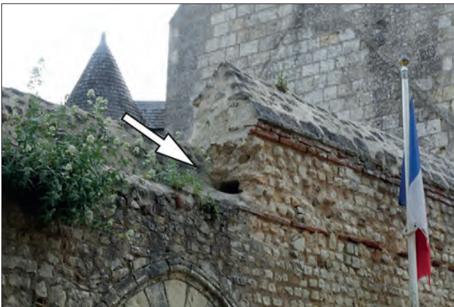
Fig. VIII.4.11 - localisation du négatif de poutre prise dans l'épaisseur du mur 30001 © Réalisation A. Remy.
