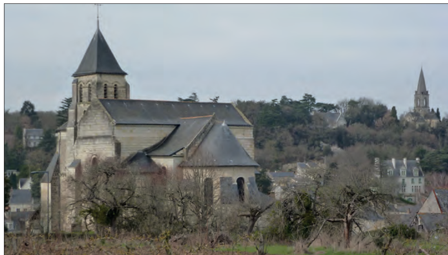
Fig. VIII.2-10 - Les églises de Saint-Vétérin et Saint-Eusèbe © Cliché M. Marc2019.
