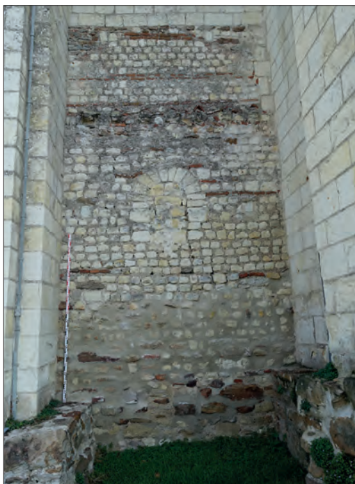
Fig. IV-8 - Parement intérieur de la nef de Saint-Eusèbe présentant une alternance d'assises de moellons de tuffeau avec des briques © Cliché L. Déodat 2021.
