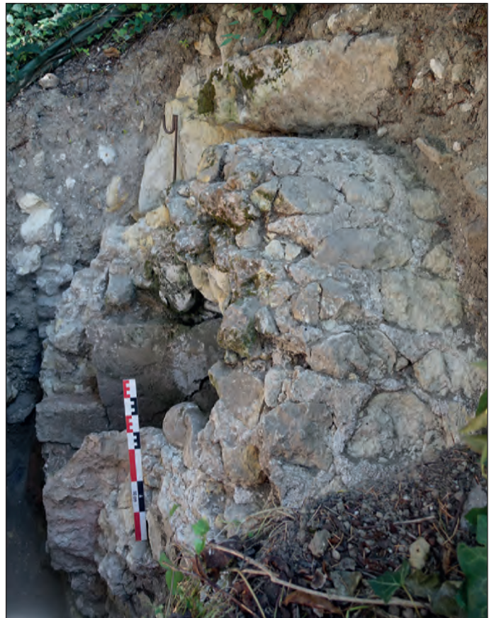
Fig. VII.4-42 - Vue de l'extrados de la voûte de l'aqueduc de Mardron, depuis le dessus © Cliché L. Déodat 2022.
