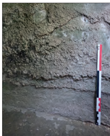
Fig. VII.4-39 - L'intérieur du specus avec l'enduit de la paroi qui repose sur le radier et les différents niveaux de concrétions marquant peut-être plusieurs niveaux d'eau © Cliché L. Déodat 2022.
