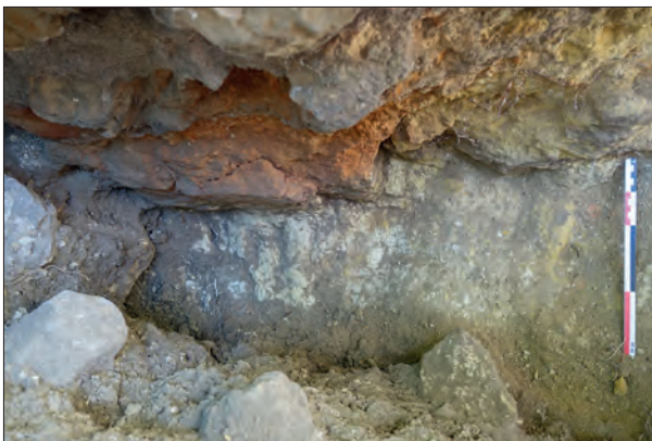
Fig. VII.4-26 - Niveau de substrat rocheux en fond de sondage, avec à gauche, un aspect brûlé : l'aqueduc est totalement détruit © Cliché L. Déodat 2022.
