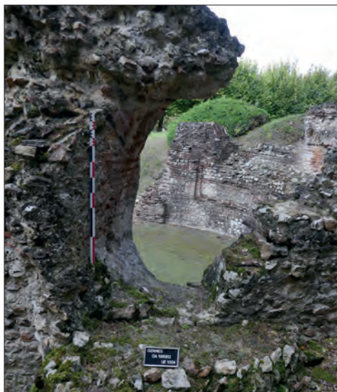
Fig. VII.3-16 - Vestiges (bûchés) de l'adduction de la conduite supérieure (UE 1004) © Cliché A. Remy, octobre 2021.
