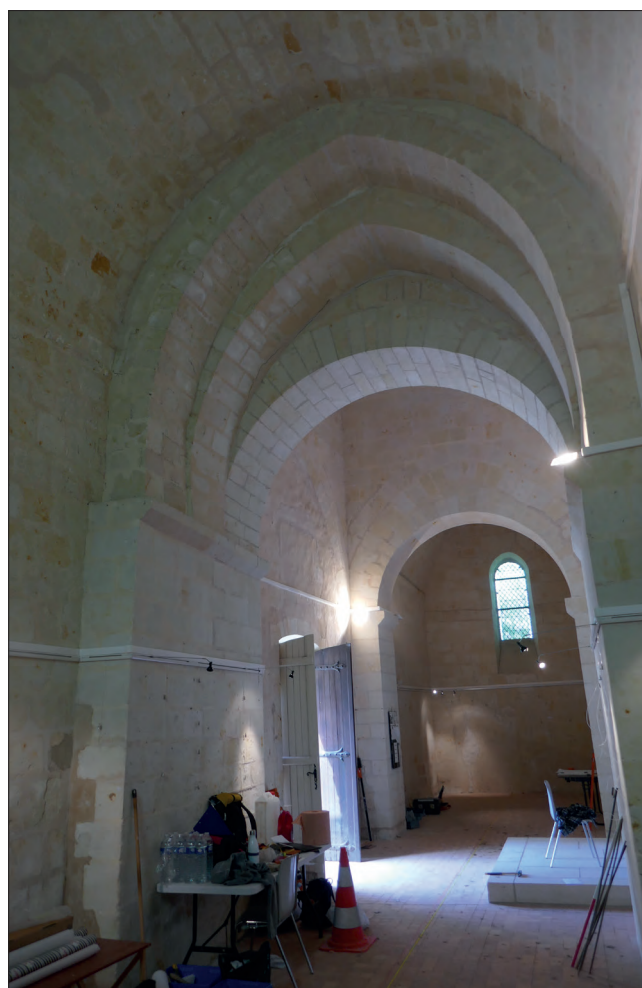
Fig. VIII.4.32 - Arc sud de la croisée à triple rouleau (restauration 30040) © Cliché A. Remy.
