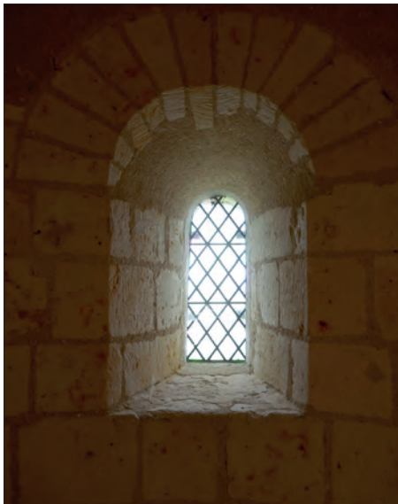
Fig. VIII.4.34 - Fenêtre de l'abside orientée sud © Cliché A. Remy.
