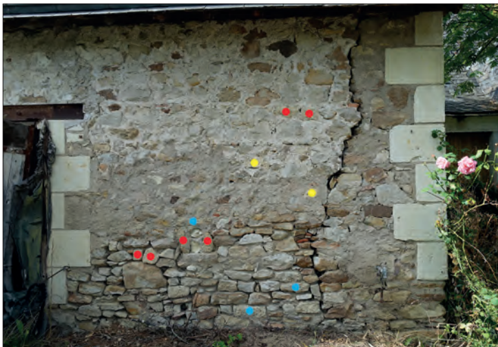
Fig. IX.1-19 - Fragments de faluns consolidés en réemploi dans le parement externe de l'extrémité nord-est de la façade sud-est de la remise : calcaire bioclastique R1 en bleu, calcaire bioclastique R2 en jaune, calcaire bioclastique R3 en rouge (cl. L. Déodat).
