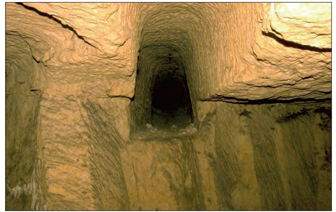
Fig. IV-13 - Souterrain aménagé alto-médiéval présent dans les carrières de Saint-Eusèbe, site de La Cave Forte © Cliché M. Cousin.
