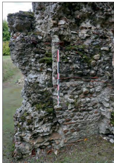
Fig. VII.3-3 - Fondation apparente du mur 1001 © Cliché A. Remy, octobre 2021.
