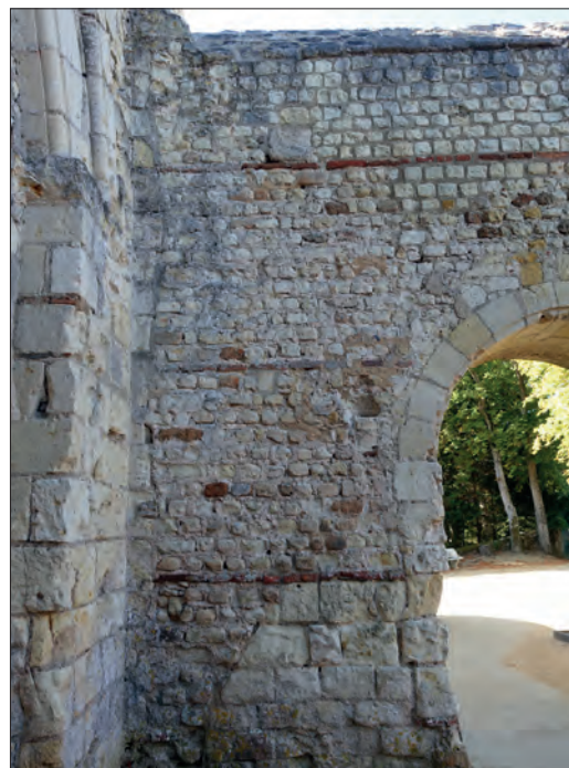
Fig. IV-9 - Parement extérieur du clocher de Saint-Vétérin présentant une alternance d'assises de moellons de tuffeau avec des briques © Cliché L. Déodat 2021.
