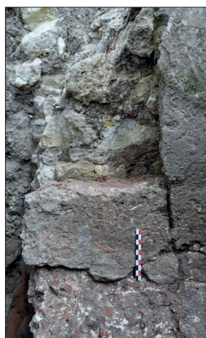
Fig. VII.4-36 - Détail de la paroi sud, avec l'enduit hydraulique formée de deux passes bien distinctes, UE 100007 et 10015 © Cliché L. Déodat 2022.
