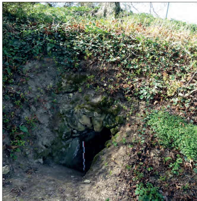
Fig. VII.4-20 - L'aqueduc à son débouché dans la parcelle de Mardron © Cliché L. Déodat 2020.
