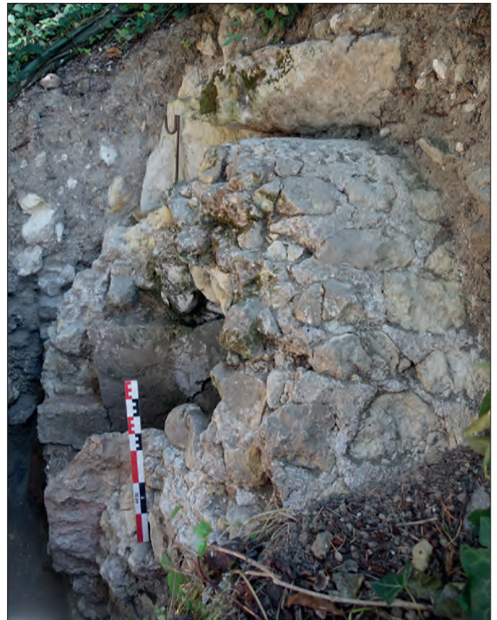
Fig. VII.4-42 - Vue de l'extrados de la voûte de l'aqueduc de Mardron, depuis le dessus © Cliché L. Déodat 2022.
