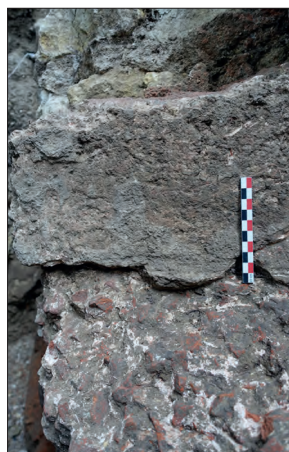
Fig. VII.4-34 - Détail de la conduite de l'aqueduc, le specus, avec le radier visible par destruction de la couche de finition et la paroi latérale sud © Cliché L. Déodat 2022.
