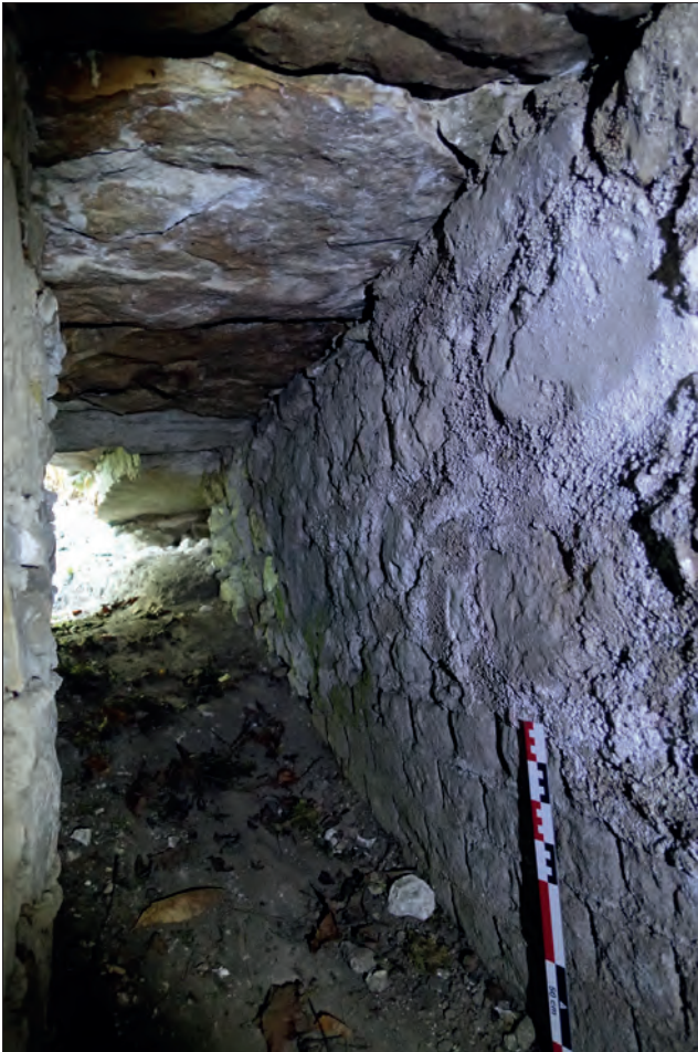
Fig. VII.3-63 - Vue de l'entrée de la galerie souterraine depuis l'intérieur de cette dernière © Cliché L. Déodat, octobre 2021.
