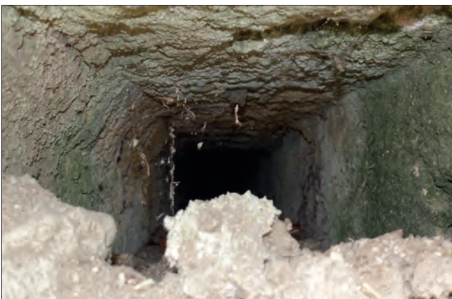
Fig. VIII.4.12 - empreinte d'une poutre prise dans l'épaisseur du mur 30001 © Cliché J.-Y. Hunot.
