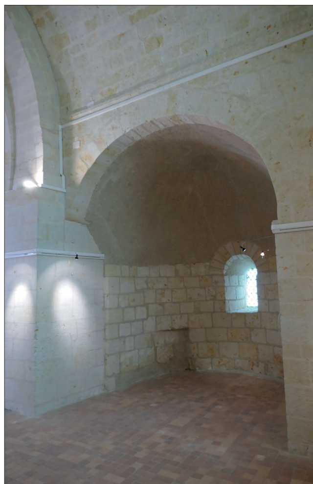
fig. VIII.4.33 - L'abside orientée sud vers le chœur © Cliché A. Remy.
