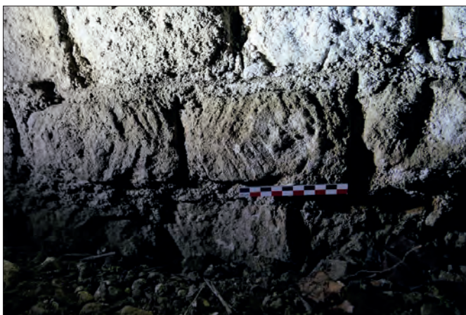
Fig. VII.3-66 - Vue depuis le nord-ouest d'un moellon portant des traces incisées de taille sur l'élévation de la maçonnerie 1025. Cliché réalisé en lumière artificielle © Cliché T. Maisonneuve, septembre 2022.
