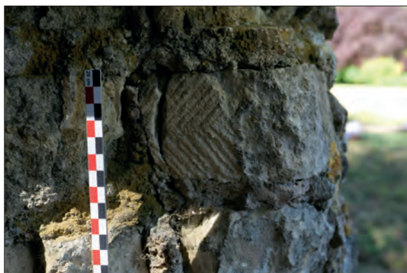
Fig. VII.3-74 - Vue depuis l'est d'un moellon portant des traces incisées de taille sur le piédroit occidental de la baie sud de l'abside 1002 © Cliché T. Maisonneuve, septembre 2022.
