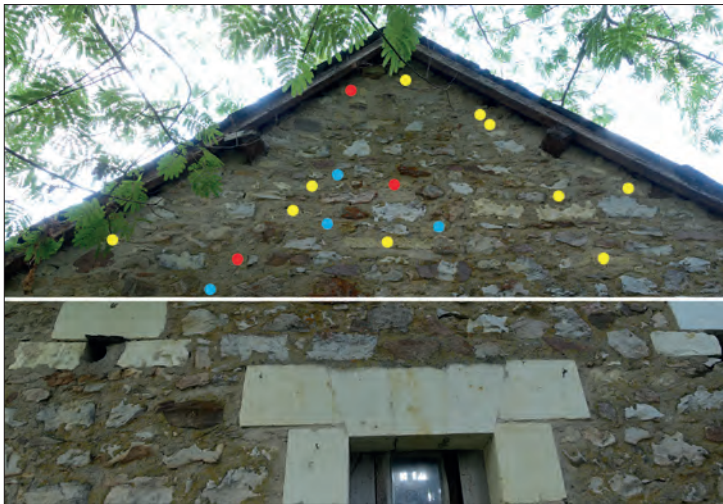
Fig. IX.1-18 - Fragments de faluns consolidés en réemploi dans la partie haute du parement externe du pignon nord-est de la remise : calcaire bioclastique R1 en bleu, calcaire bioclastique R2 en jaune, calcaire bioclastique R3 en rouge (cl. L. Déodat).
