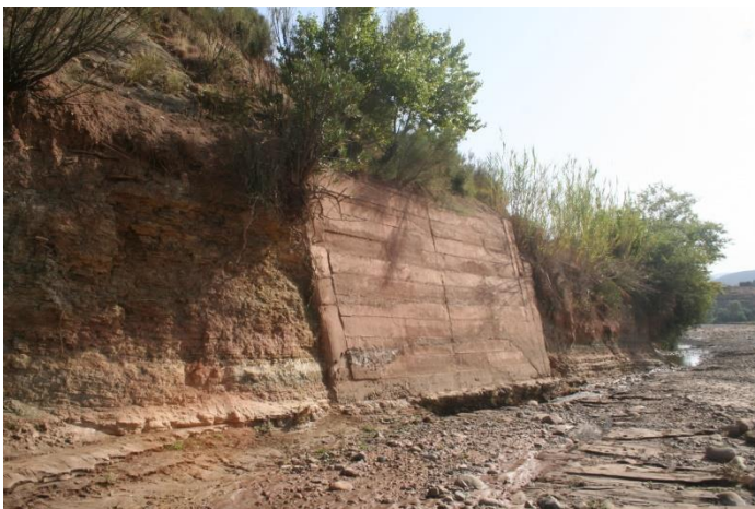
Photo n°4: Exemple d'une berge bétonnée
