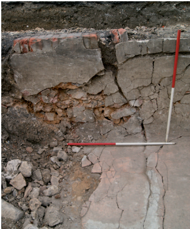
Figure 70 - Vue du coeur de la maçonnerie du mur MR 67 et du radier du bassin
