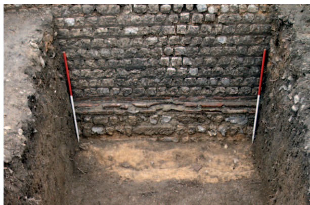
Figure 31 - Vue de détail du remblai de démolition US 42 au pied du rempart
