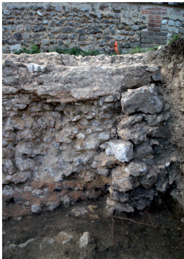
Figure 39 - Vue de détail du parement de la maçonnerie MR 61
