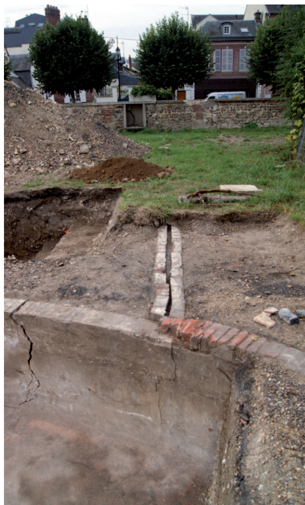
Figure 72 - Le dispositif de trop-plein CN 69 vu vers le sud
