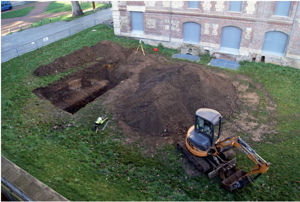
Figure 11 - Vue d'ensemble de la zone d'intervention depuis la médiathèque à la fin des terrassements
