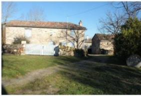
Fig. 16 - Fermes construites au nord du noyau ancien.
