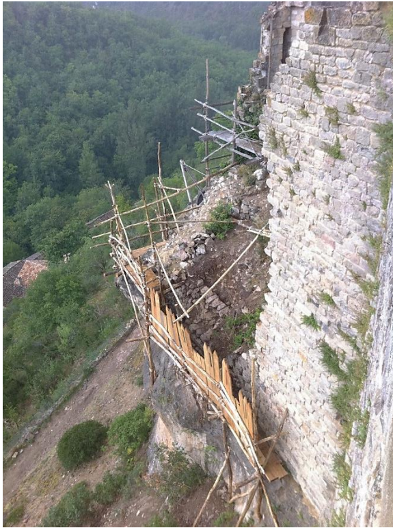
Fig. M26 avant restauration (2011). Crédit Axel Letellier
