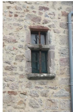
Fig. 18 - Elévation nord, demi-croisée.
