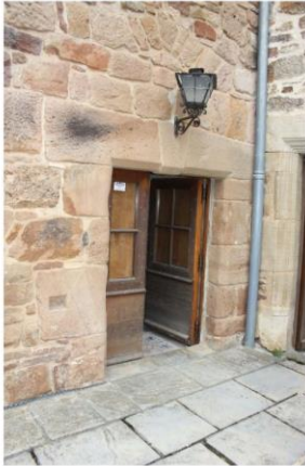
Fig. 31 - Corps de logis, élévation est, porte du rez-de-chaussée.
