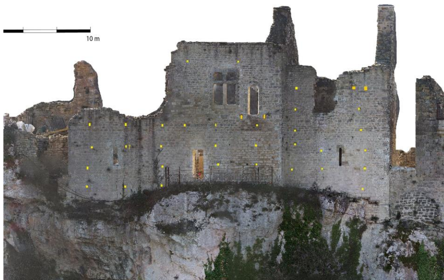
Fig. Parements externes logis 2 (à gauche) et 1 (à droite), boulines (jaunes) et empochements (orange). Certains boulines peuvent avoir disparu du fait la réfection des murs et les ouvertures peuvent aussi avoir servi à l'échafaudage traversant. Crédit F. Guillot
