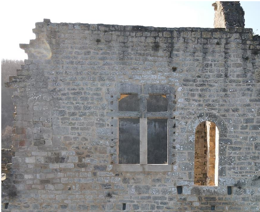
Fig. Les ouvertures du premier étage nord du logis 2. (Notez celle qui est bouchée à gauche). Crédit F. Guillot.
