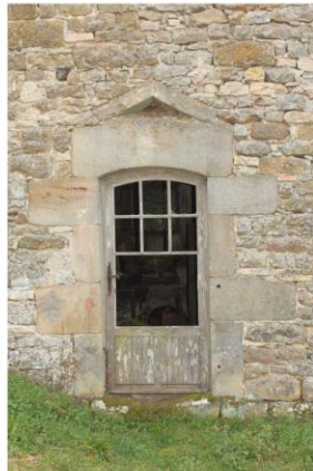
Fig. 26 - Bâtiments occidentaux de la ferme, porte.
