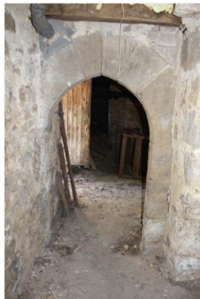
Fig. 14 - Porte en arc brisé du premier logis du château.
