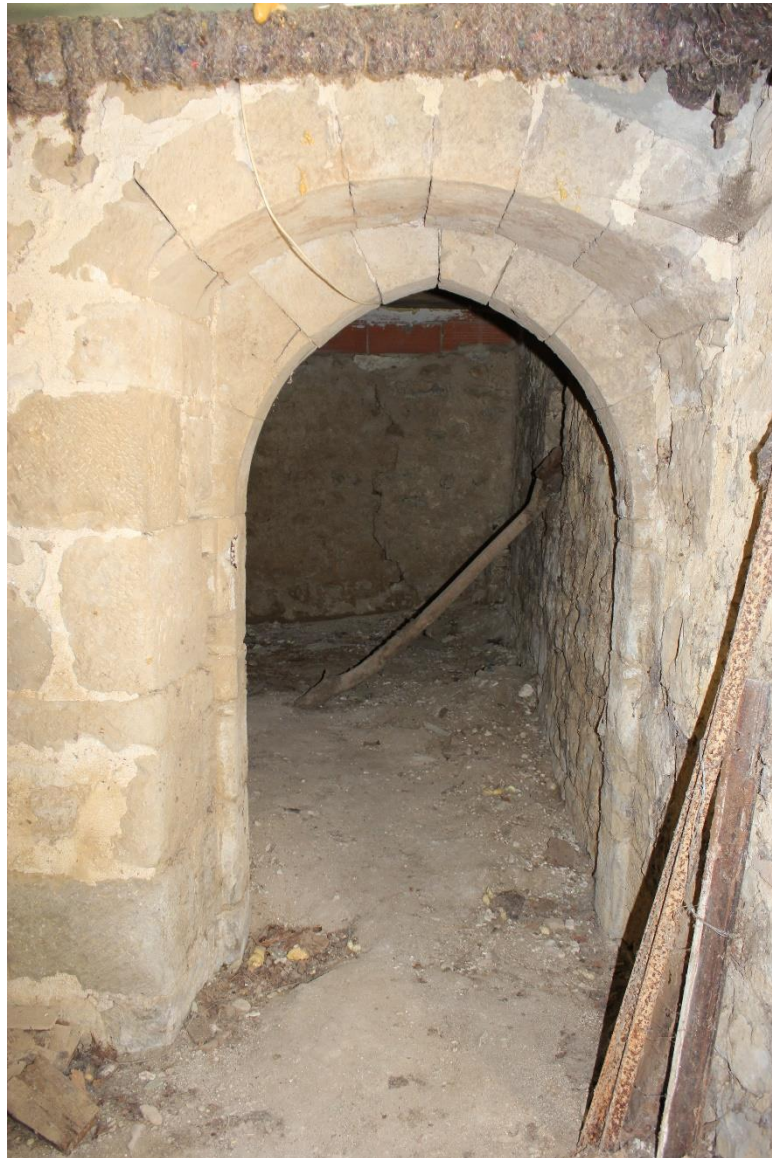
Fig. 3. Château Granier, ébrasement de la porte du XIII e siècle. Crédit A. Béa
