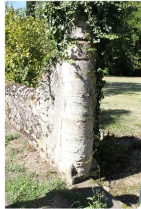
Fig. 45 - Colonne avec congé pyramidal.
