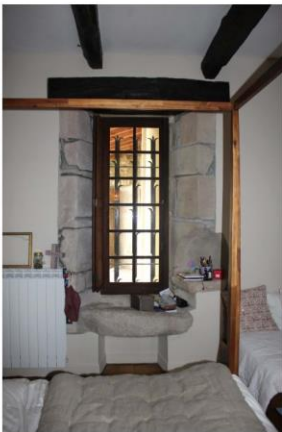
Fig. 16 - Premier étage, chambre du maître de maison, demi-croisée avec lavabo.
