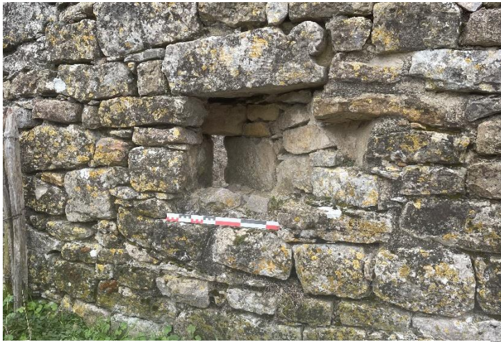
Fig. Interne M3b. Ouverture. Notez le linteau (réemploi d'un décor à colonnette). Crédit F. Guillot
