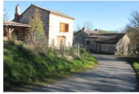
Fig. 14 - Unités de petites fermes élevées au sud du noyau ancien du hameau.
