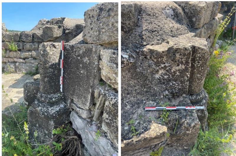
Fig. Dernier étage de la tour à éperon, base d'un fût de colonne engagée, tore et fût dans l'angle d'une ouverture de jour (nord). Crédit F. Guillot.
