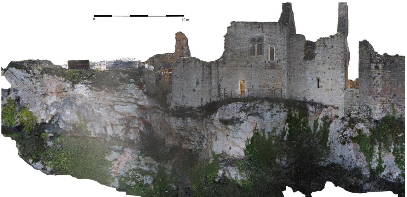
Fig. Orthophotographie tirée de la photogrammétrie du parement externe (nord) des logis. Crédit F. Guillot
