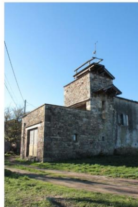
Fig. 8 - Détail de la tour.
