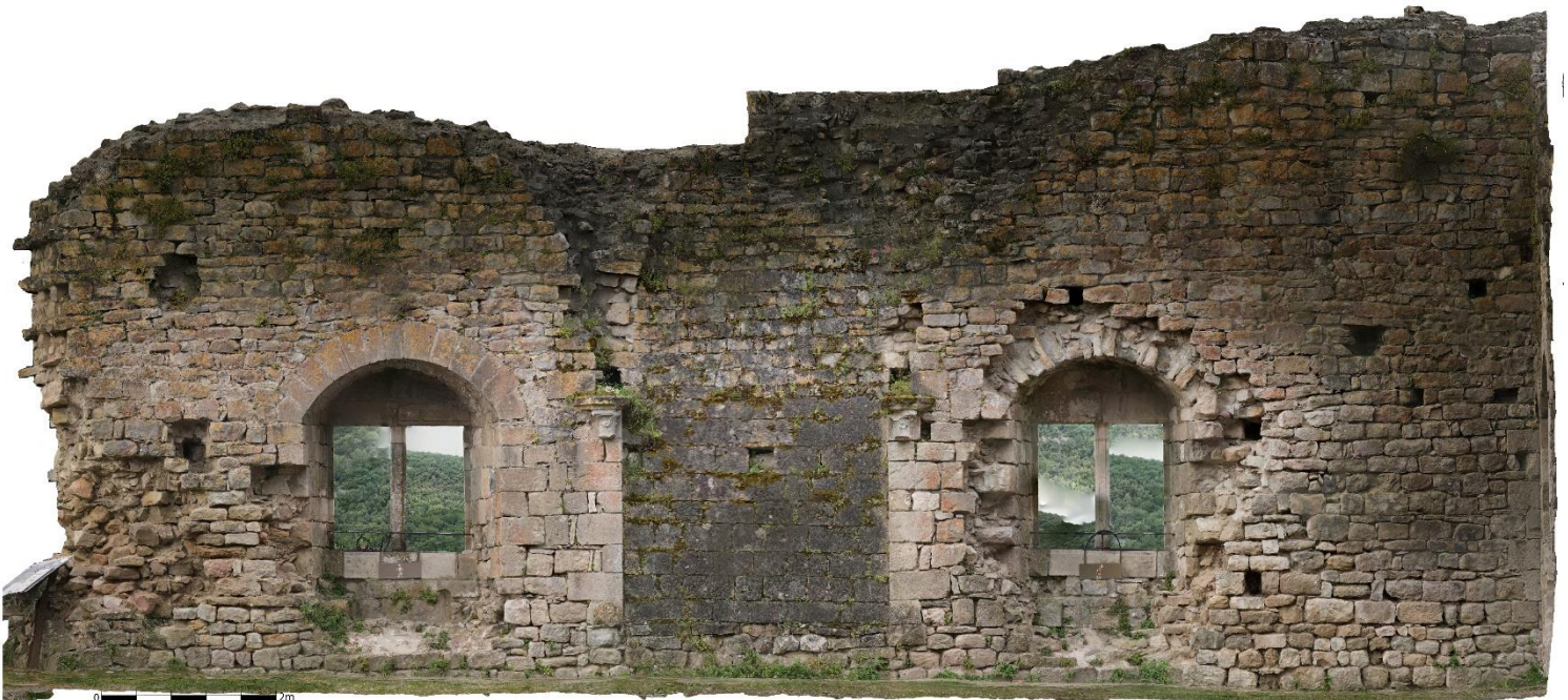
Fig. M27 (aula), parement interne. Orthophotographie tirée de la photogrammétrie. Crédit F. Guillot
