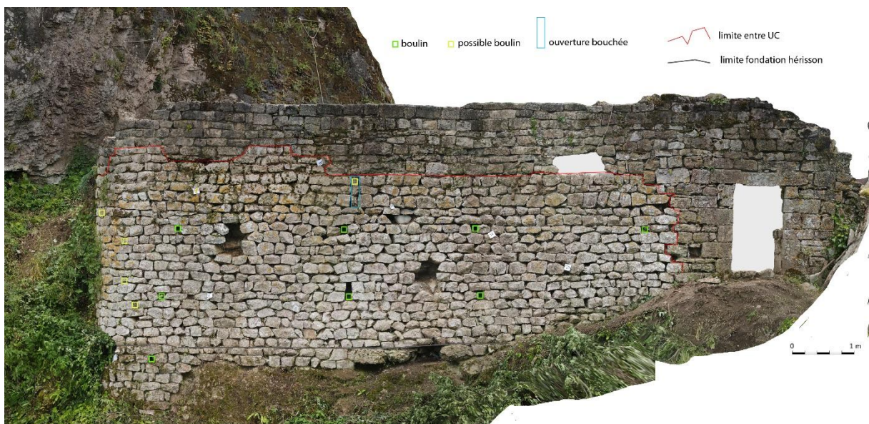
Fig. Parement externe M7. Orthophotographie développée tirée de la photogrammétrie. L'UC du dessus et la poterne datent de la mise en place de la basse-cour du château royal. L'UC inférieure a été datée par la fouille de la première moitié du XIe siècle ou du milieu du XIe siècle. L'orthophotographie du parement interne est présentée ci-dessous dans le vol. 2 (rapport de la fouille programmée). Crédit F. Guillot
