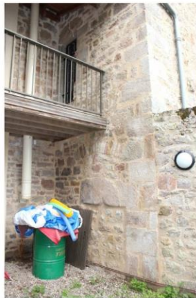
Fig. 17 - Nord, mur de retour est, porte à linteau à pointe d'accolade.
