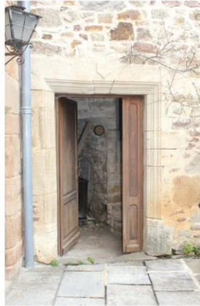
Fig. 32 - Tour d'escalier, élévation sud, porte.
