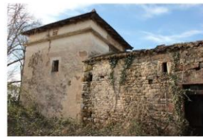
Fig. 6 - Vue des élévations nord du pigeonnier et du bâtiment annexe du 19e siècle.
