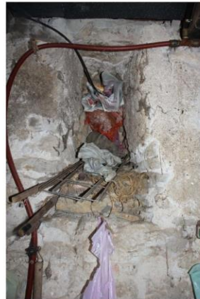
Fig. 12 - Rez-de-chaussée de la tour, fente de tir.
