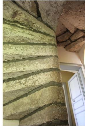
Fig. 30 - Vue de l'escalier en vis.
