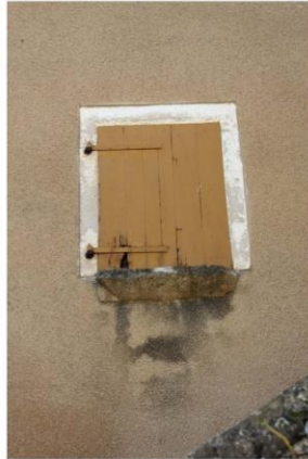
Fig. 8 - Elévation nord, baie et appui biseauté.
