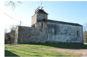
Fig. 6 - Détail du bâtiment transversal à tour et départ du bâti au nord.
