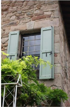
Fig. 19 - Premier étage, élévation sud, porte du premier étage sommée des armoiries du maître de maison.
