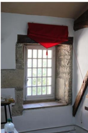
Fig. 52 - Emprise correspondant à une ancienne baie médiévale.
