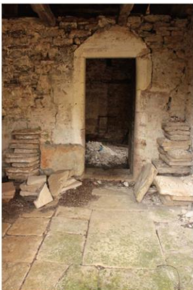
Fig. 16 - Elévation nord, détail de la porte du logis.
