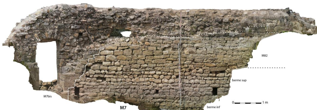
Fig. Parement interne M7, M7bis : orthophotographie issue de la photogrammétrie perpendiculaire au M7. Crédit F. Guillot.
