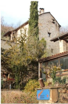
Fig. 4 - Vue générale depuis le sud-est.
