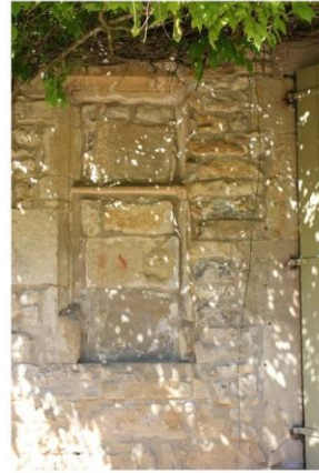
Fig. 42 - Croisée maintenant obturée dans l'élévation sud.
