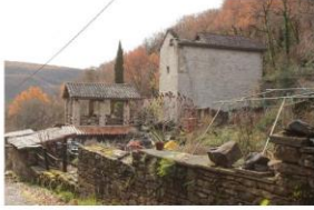
Fig. 1 - Vue générale depuis le nord-est.
