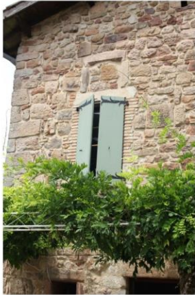
Fig. 37 - Elévation sud, vestiges d'anciennes baies.
