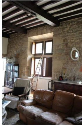
Fig. 44 - Ebrasement de la croisée nord-est avec vestige de coussièges.
