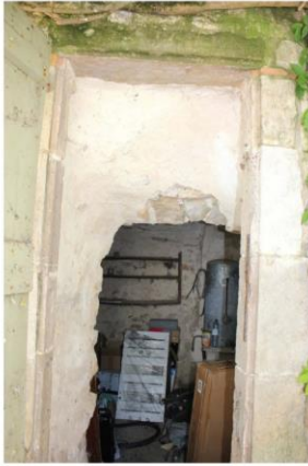
Fig. 40 - Entrée pratiquée à posteriori pour accéder au rez-de-chaussée de la tour ronde.
