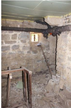
Fig. 17 - Détail de l'élevation intérieure du niveau de soubassement.
