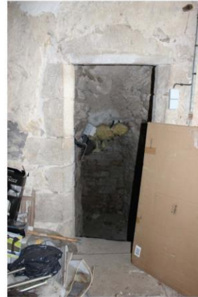
Fig. 24 - Tour ronde, porte du rez-de-chaussée, encadrement à large chanfrein et à base pyramidale.
