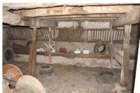
Fig. 61 - Bâtiment agricole, emplacement de l'étable.
