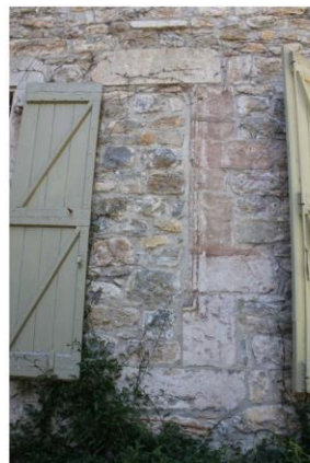
Fig. 54 - Partie d'un encadrement en emploi dans l'élévation sud du retour oriental.
