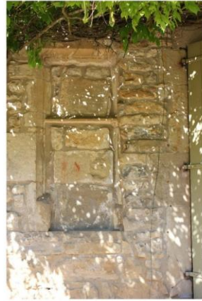
Fig. 42 - Croisée maintenant obturée dans l'élévation sud.
