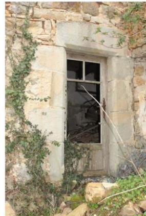
Fig. 27 - Bâtiments occidentaux de la ferme, porte.
