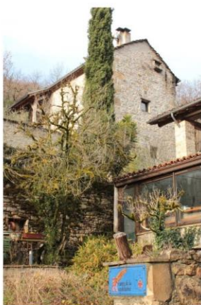
Fig. 4 - Vue générale depuis le sud-est.
