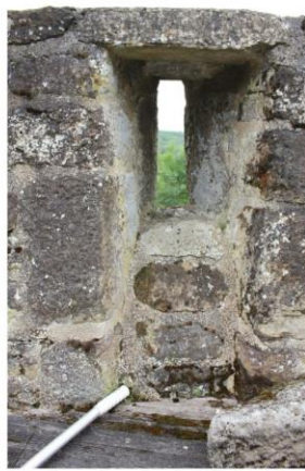
Fig. 35 - Mur de clôture occidentale, fente de tir bouchée en partie.
