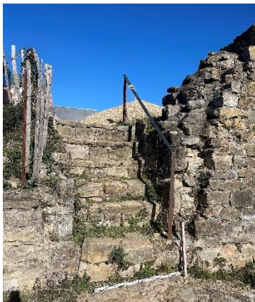
Fig. M22, accès actuel au logis 3 depuis la circulation centrale. Crédit F. Guillot.
