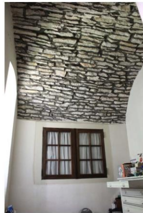
Fig. 33 - Voûte en berceau segmentaire au premier étage de la tour ronde.
