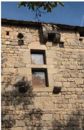
Fig. 7 - Détail de la fenêtre et des latrines.
