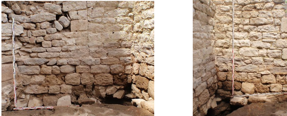
Fig. Secteur église. M75 (gauche) et M52 (droite). Ils sont chaînés. Crédit A. Priol et G. Vialatte.
