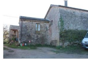
Fig. 12 - Elévation postérieure et baie ouverte à l'arrière.
