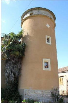
Fig. 5 - Vue de la tour.
