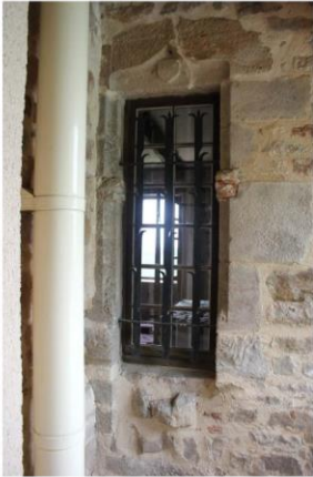
Fig. 13 - Nord, retour est, demi-croisée du premier étage.
