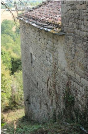
Fig. 10 - Vue de l'élévation latérale,
