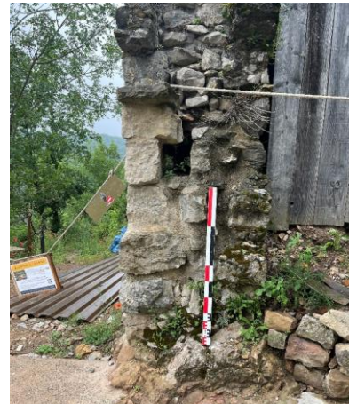
Fig. L'entrée dans la basse-cour, piédroit ouest. Les moellons de gauche au centre sont une restauration, mais le trou de barre préexistait. Crédit F. Guillot
