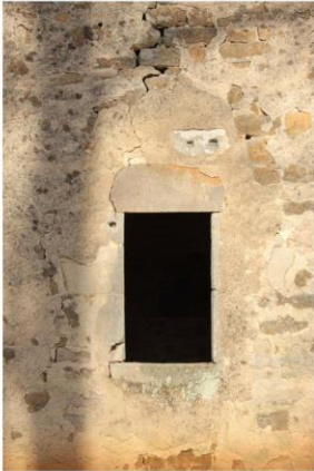
Fig. 10 - Détail de la baie percée dans l'élévation orientale de la tour.
