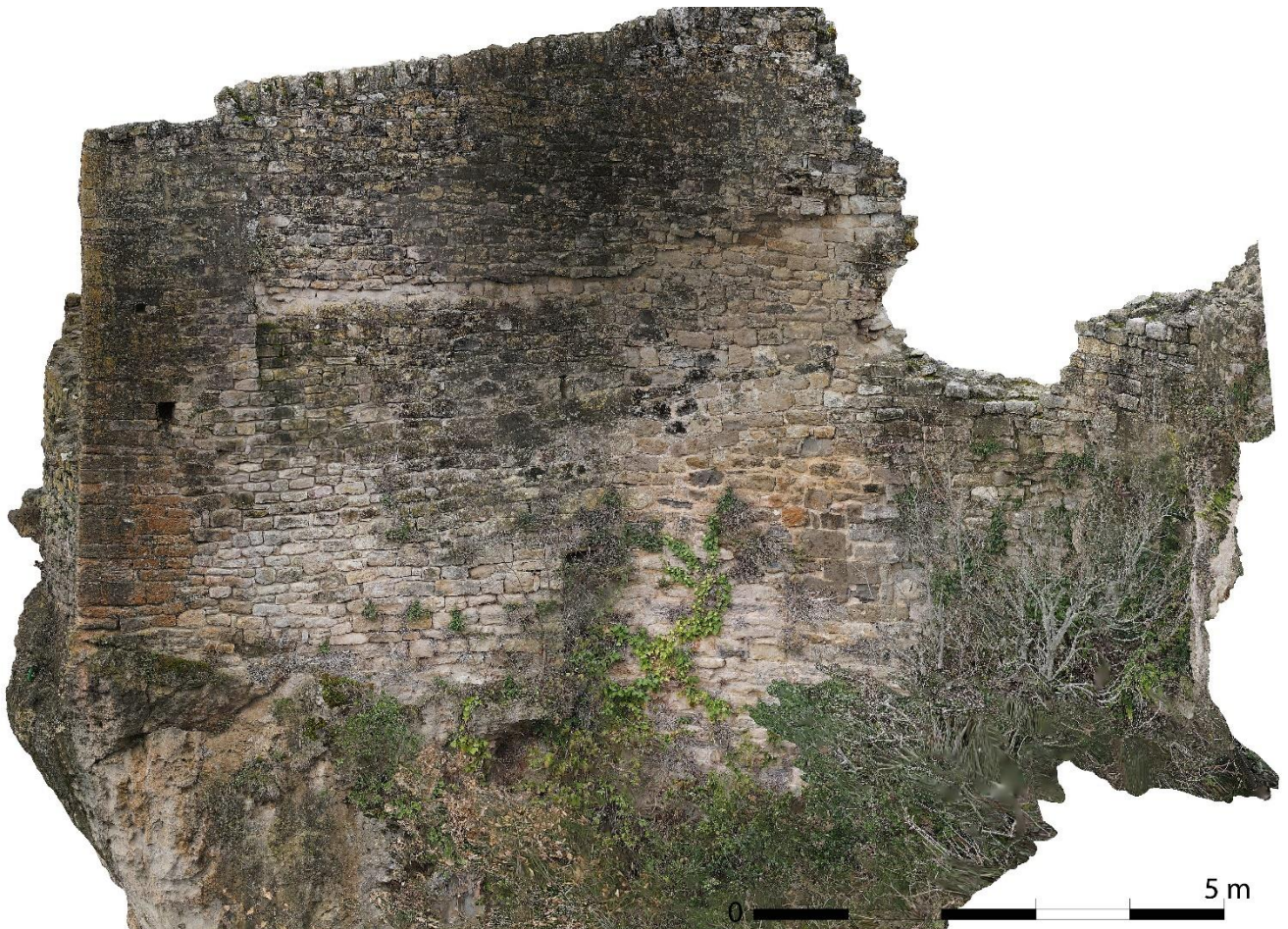
Fig. Orthophotographie tirée de la photogrammétrie, M32 externe est. Crédit F. Guillot
