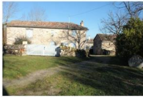
Fig. 16 - Fermes construites au nord du noyau ancien.
