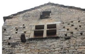
Fig. 11 - Croisée percée au second étage et baie de comble.
