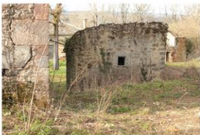
Fig. 13 - Annexe abritant le puits.
