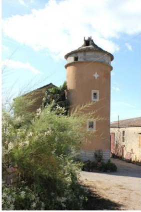
Fig. 1 - Vue de la maison forte.
