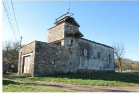
Fig. 1 - Vue du bâtiment transversal comprenant une tour.
