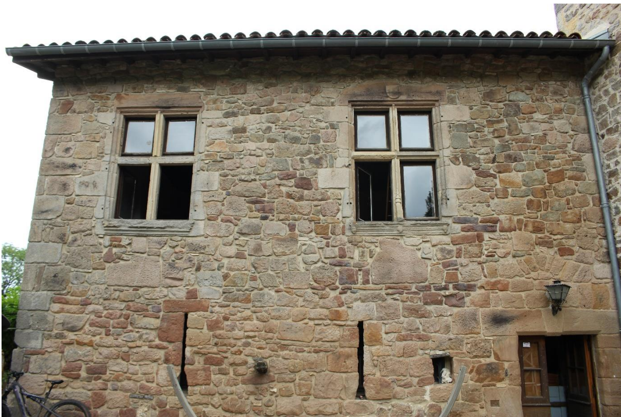
Fig. 5. Château de Périlhac, élévation est. Crédit A. Béa
