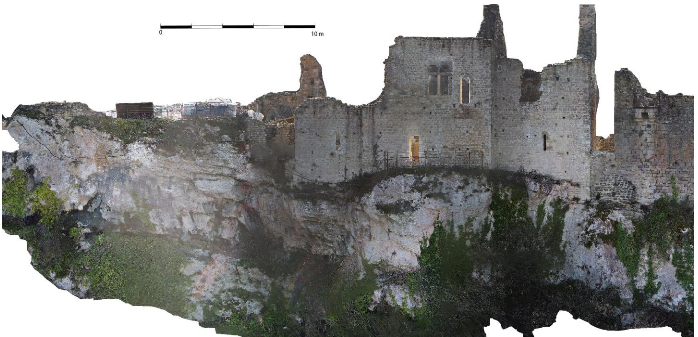
Fig. Orthophotographie tirée de la photogrammétrie du parement externe (nord) des logis. Crédit F. Guillot
