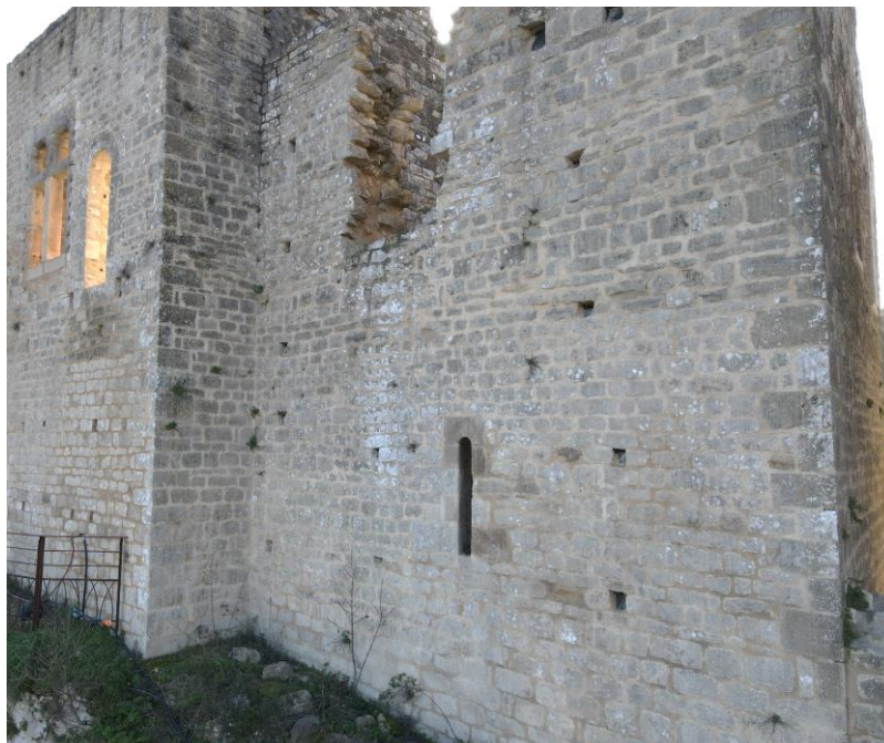
Fig. Parements externes logis 2 (à gauche) et 1 (à droite), décrochement et jonction. Crédit F. Guillot
