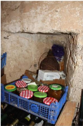
Fig. 10 - Rez-de-chaussée de la tour, fente de tir fortement ébrasée.
