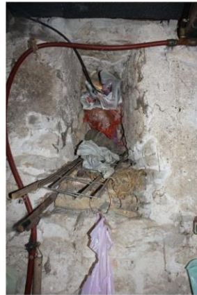
Fig. 12 - Rez-de-chaussée de la tour, fente de tir.
