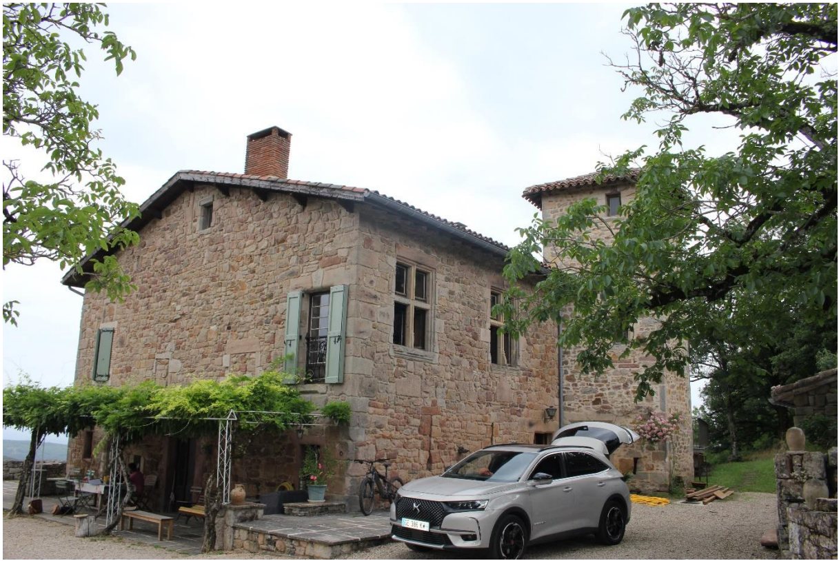
Fig. 4. Château de Périlhac, vue de trois quarts. Crédit A. Béa
