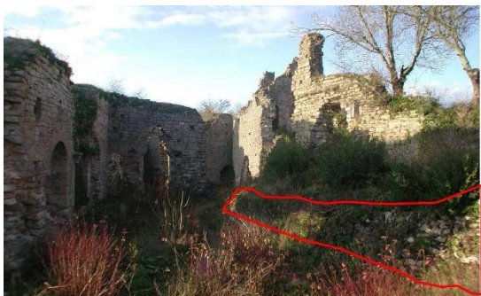
Image du M29 avant restauration et dégagement; Axel Letellier et Bernard Pousthomis. 2008-2011.
