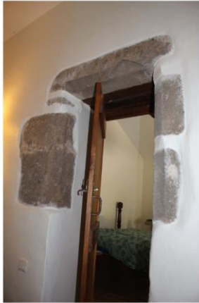
Fig. 43 - Communs, ancienne fenêtre à encadrements chanfreinés.
