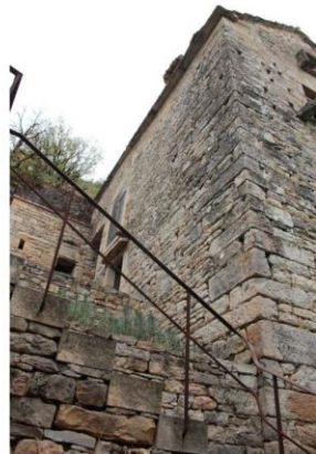
Fig. 5 - Vue de l'élévation ouest.
