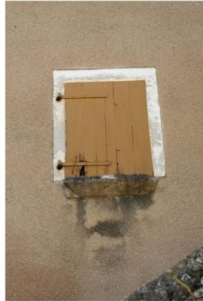
Fig. 8 - Elévation nord, baie et appui biseauté.
