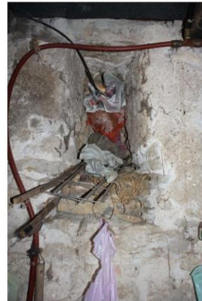
Fig. 12 - Rez-de-chaussée de la tour, fente de tir.
