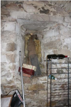
Fig. 22 - Tour ronde, baie du rez-de-chaussée.
