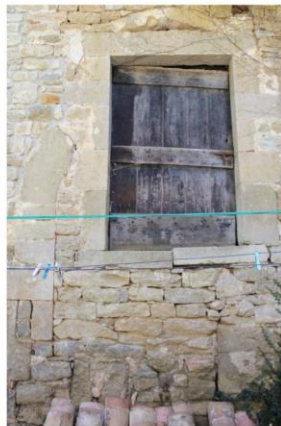
Fig. 59 - Élévation nord du bâtiment agricole, tracé partiel d'un arc.
