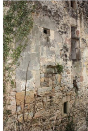
Fig. 21 - Elévation occidentale, emplacement de l'évier et demi-croisée.
