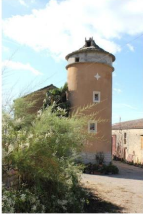
Fig. 1 - Vue de la maison forte.
