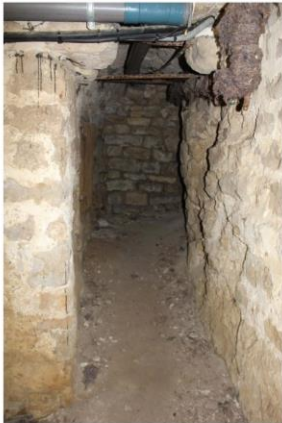
Fig. 19 - Passage au niveau du soubassement en arrière de la tour ronde.
