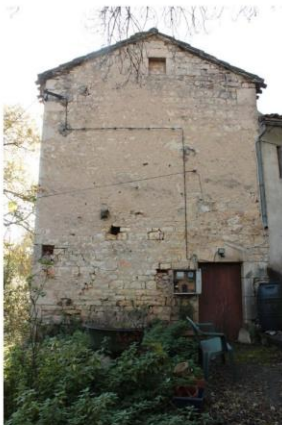
Fig. 4 - Elévation orientale de la tour.
