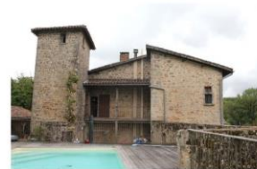
Fig. 9 - Vue générale depuis le nord.
