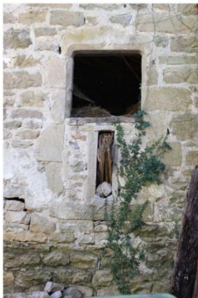
Fig. 58 - Elévation nord du bâtiment agricole, baie couverte d'un arc en accolade et encadrement chanfreiné.
