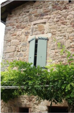
Fig. 37 - Elévation sud, vestiges d'anciennes baies.
