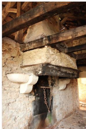
Fig. 17 - Logis, cheminée sur corbeaux avec tablette.
