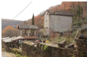
Fig. 1 - Vue générale depuis le nord-est.
