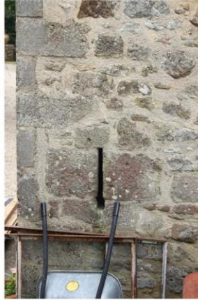
Fig. 29 - Tour, face nord, bouche à feu.
