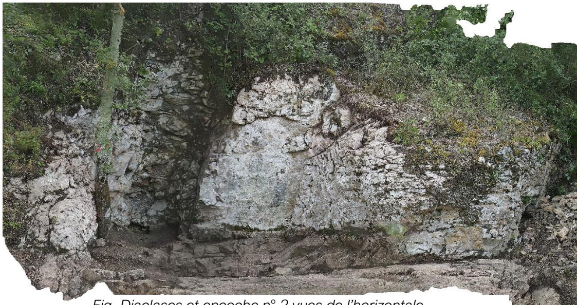
Fig. Diaclases et encoche n° 2 vues de l'horizontale, orthophotographie de la photogrammétrie. Crédit F. Guillot
