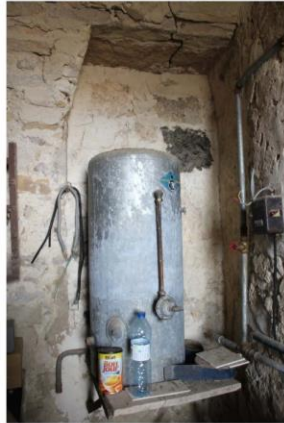
Fig. 23 - Tour ronde, rez-de-chaussée, ancien passage maintenant obturé.
