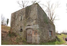
Fig. 28 - Grange-étable située à l'extrémité ouest du hameau.
