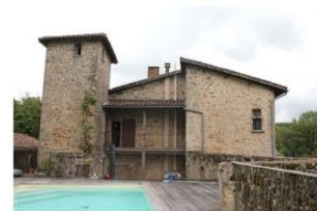
Fig. 9 - Vue générale depuis le nord.
