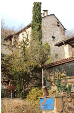
Fig. 4 - Vue générale depuis le sud-est.
