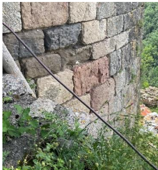
Fig. Dolosparites ou grès rouges, parement externe de la tour ronde du châtelet et dans les claveaux de la voûte du sas. Crédit F. Guillot
