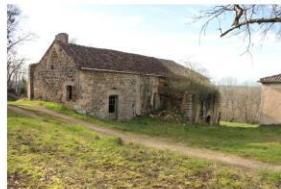
Fig. 23 - Bâtiments du côté occidental de la cour.
