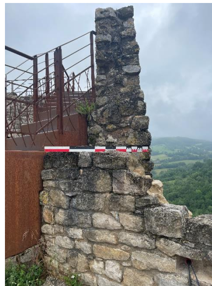
Fig. Partie occidentale du M35, rétrécissement du mur en hauteur. Crédit F. Guillot.
