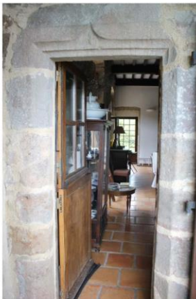
Fig. 10 - Elévation nord, porte du premier étage.
