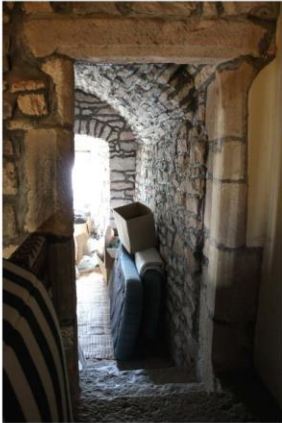
Fig. 34 - Voûte en berceau segmentaire de la tour ronde.
