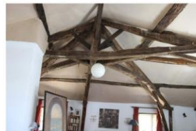
Fig. 51 - Extrémité nord, charpente de la croupe du corps de logis principal.
