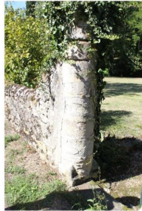
Fig. 45 - Colonne avec congé pyramidal.
