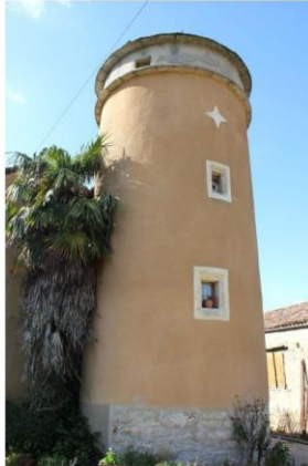
Fig. 5 - Vue de la tour.
