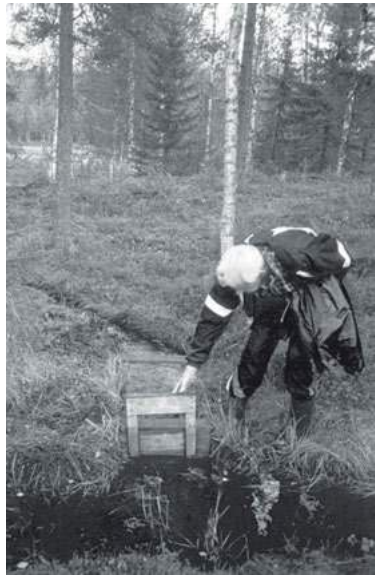
n°3: vanne en bois pour le réglage du débit de l'eau dans les rigoles de distribution sur les prés de fauche arrosés en rive droite du Petikan (village de Rörträsk, commune de Norjö (Vbt), 21 août 1993, in Cabouret 1999)
