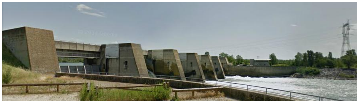
Figure 7 : Barrage du Péage-de-Roussillon/Saint-Pierre-de-Bœuf Source : Google Street
