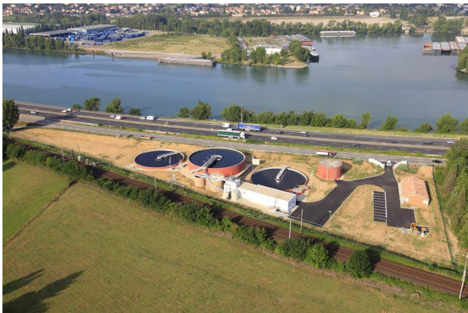
Figure 13 : Vue aérienne de la station d'épuration de Chasse-sur-Rhône Source : Site internet de la ville de Chasse-sur-Rhône
