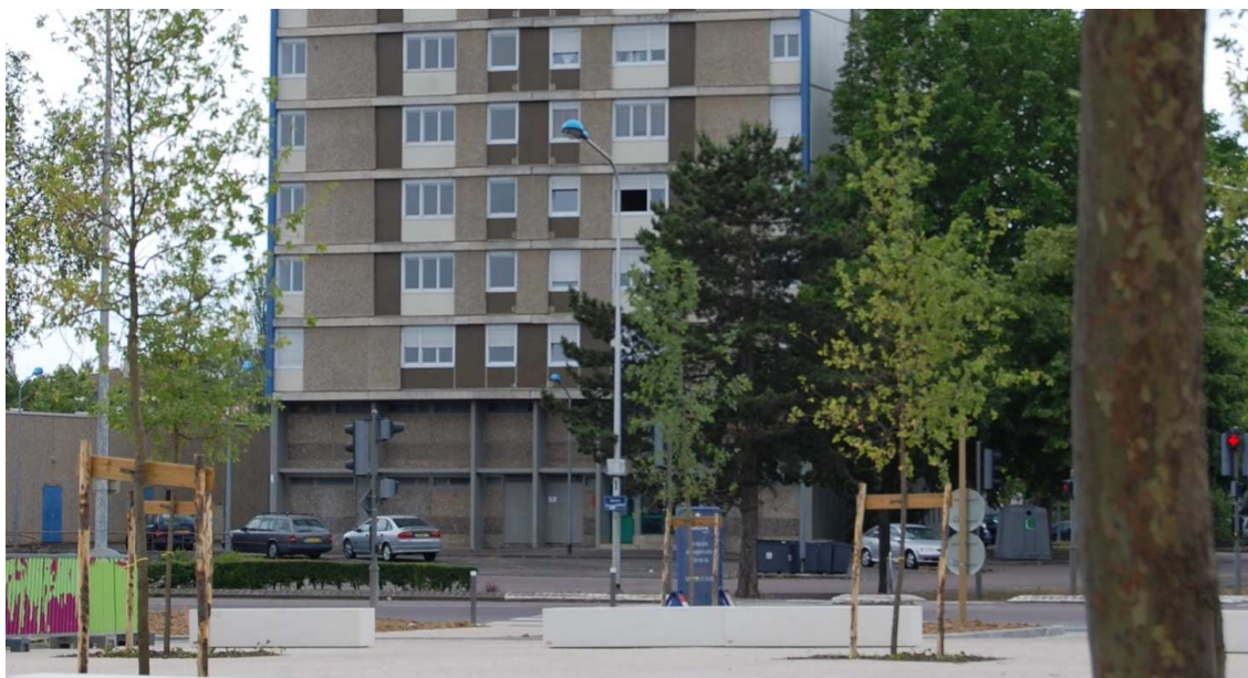
Figure 20 : Exemple d'un rez-de-chaussée non aménagé sur le quartier des Près-Saint-Jean
