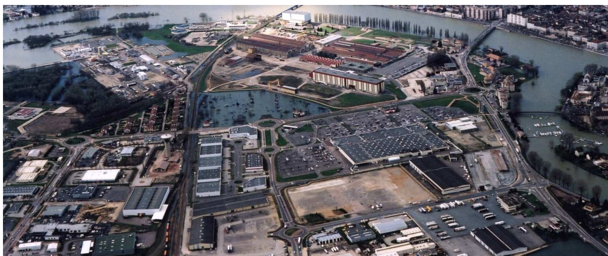
Figure 23 : La zone d'activité sud lors de la crue de 2001 Source : DDT 71
