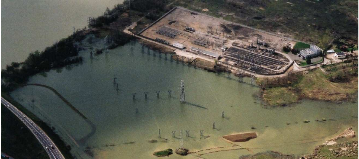
Figure 26 : Transformateur de la zone d'activité sud lors de la crue de 2001 Source : DDT 71 – EPTB Saône Doubs
