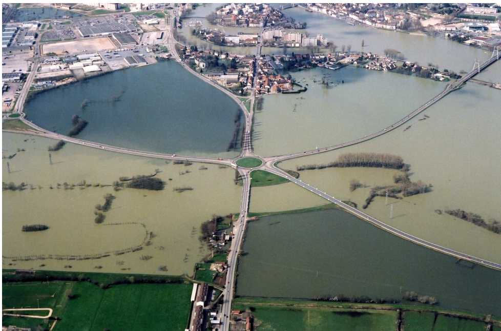
Figure 4 : Secteur des Chavannes durant la crue 2001 Source : DDT 71
