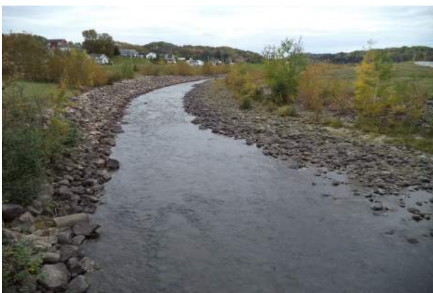
Figure 7 : Rivière Ha!Ha! en amont de La Baie
