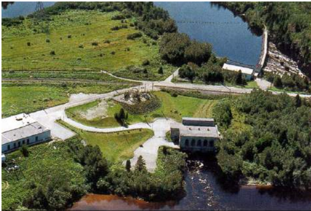
Figure 25 : Barrage Pont Arnaud avant catastrophe (source Hydro-Québec)
