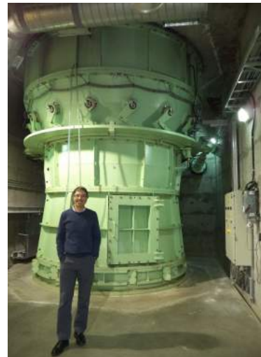
Figure 28 : Martin Vachon (Hydro-Jonquière) devant le groupe Kaplan 6 MW à axe vertical de Pont-Arnaud
