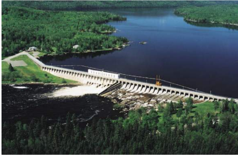
Figure 18: Barrage du Portage des Roches sur le Lac Kénogami
