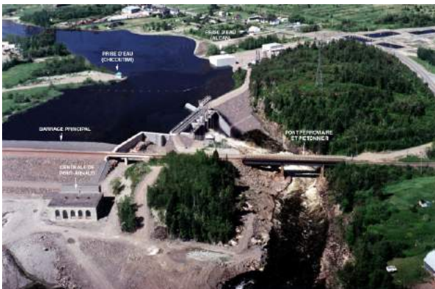
Figure 27 : Barrage Pont Arnaud après travaux (source Hydro-Québec)
