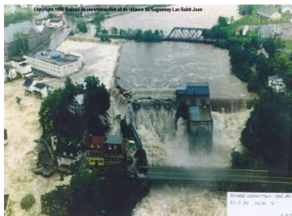
Figure 4: Inondation du barrage aval Rivière Chicoutimi et Quartier du Bassin à Chicoutimi
