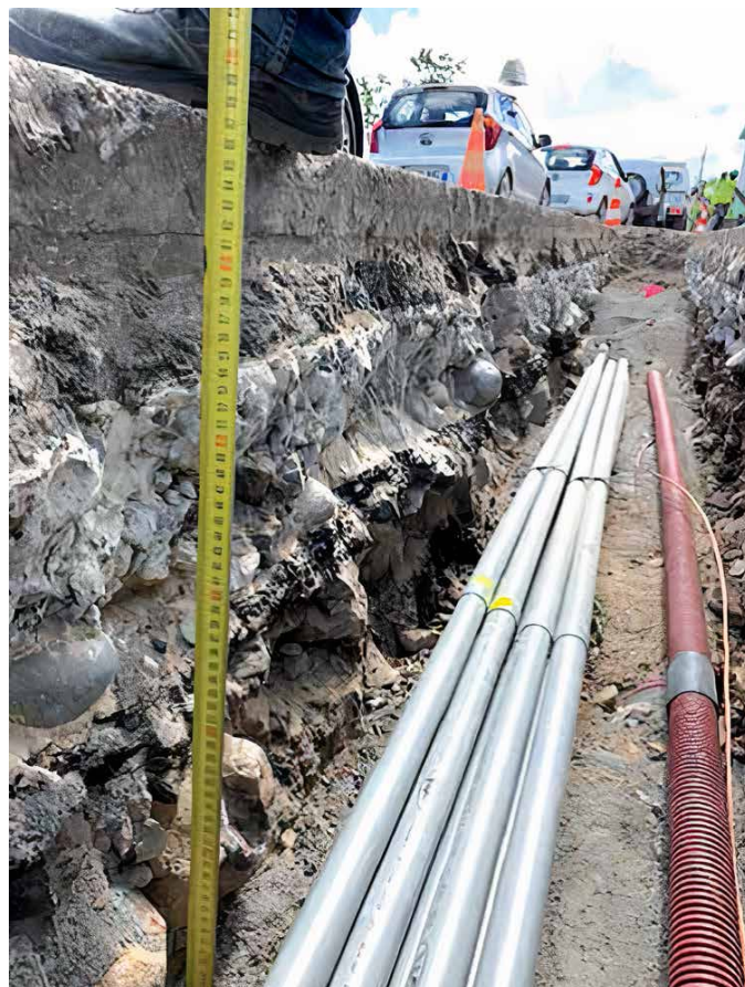
Enfouissement des lignes électriques et des lignes de téléphonie à Saint-Martin (Source: collectivité de Saint-Martin, avril 2019).
