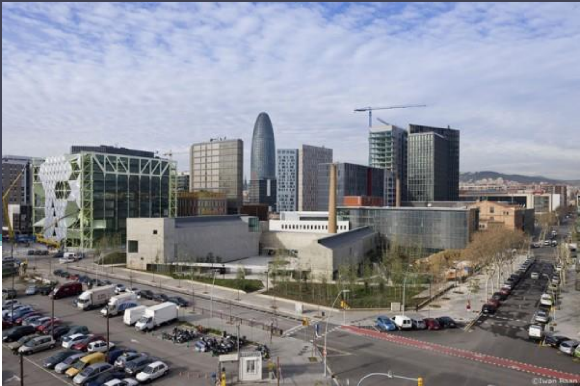
Etat d'avancement des travaux.
