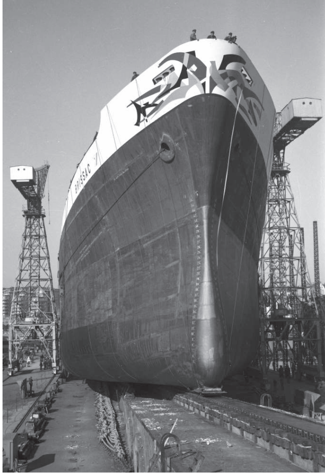
Fig. 9. – Lancement du Brissac , photographie des chantiers Loire-Normandie, 1961
