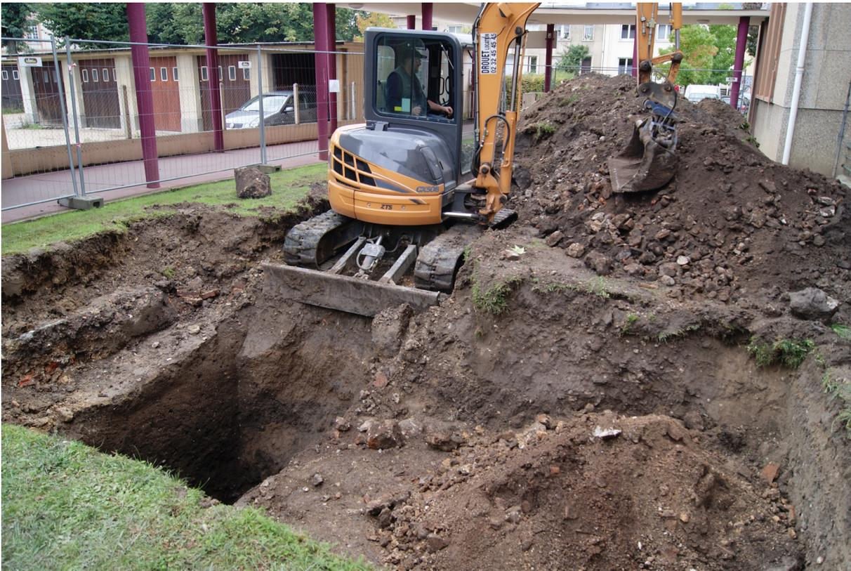
Figure 8 - La mini-pelle à l'œuvre sur le sondage 2
