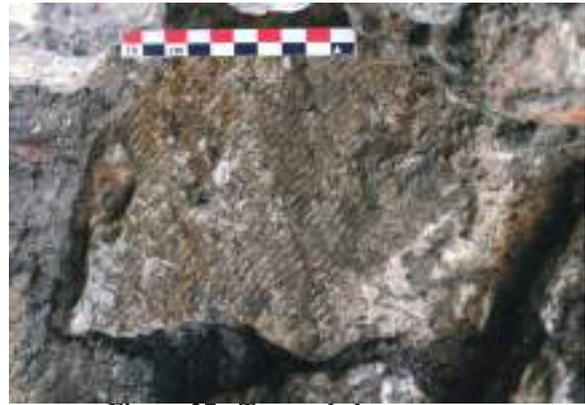
**Figure 37 - Traces de brettage sur un bloc en remploi dans une fondation de l'hospice du XIX<sup>e</sup> siècle**
